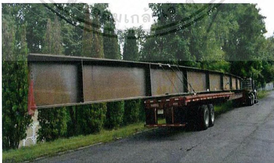
รูปที่ 1.2 การเคลื่อนย้าย girder จากโรงงานผลิต [6]
