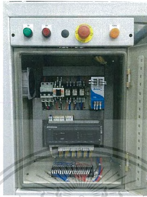
รูปที่ 4.3 การติดตั้งวงจรไฟฟ้าภายในระบบเสร็จสมบูรณ์
