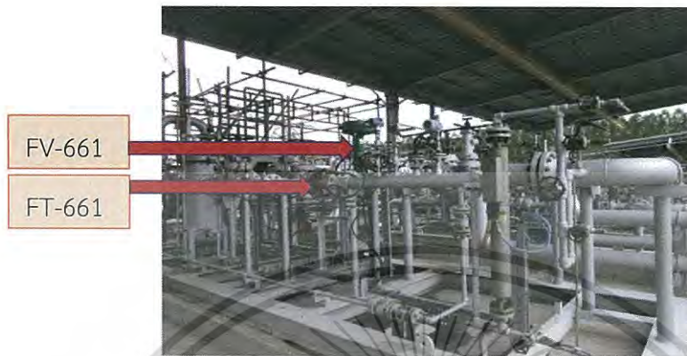
รูปที่ 3.2 มาตรวัดที่ใช้ในการซื้อ-ขายคอนเดนเสทเรซิดิวที่ศึกษา
