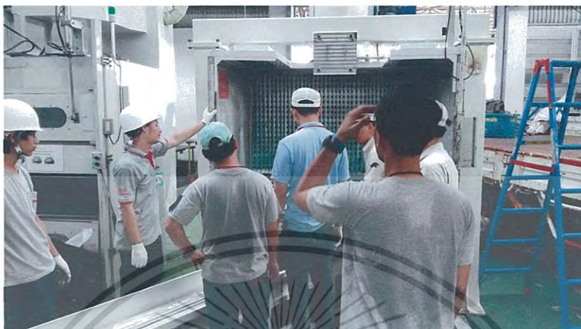
รูปที่ 4.17 ส่วนการติดตั้งหน้างาน
