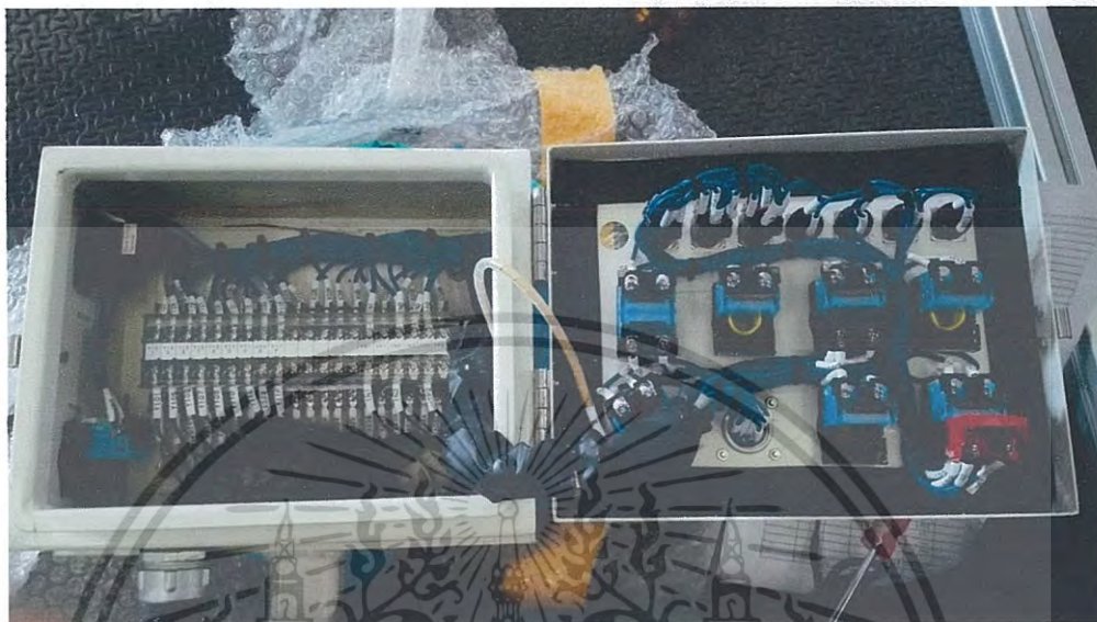
รูปที่ 3.25 ตู้ Operation ที่ Wiring เรียบร้อยแล้ว
