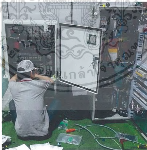
รูปที่ 3.28 เดินสายไฟเชื่อมต่อระหว่างตู้ Robot กับตู้ Control
