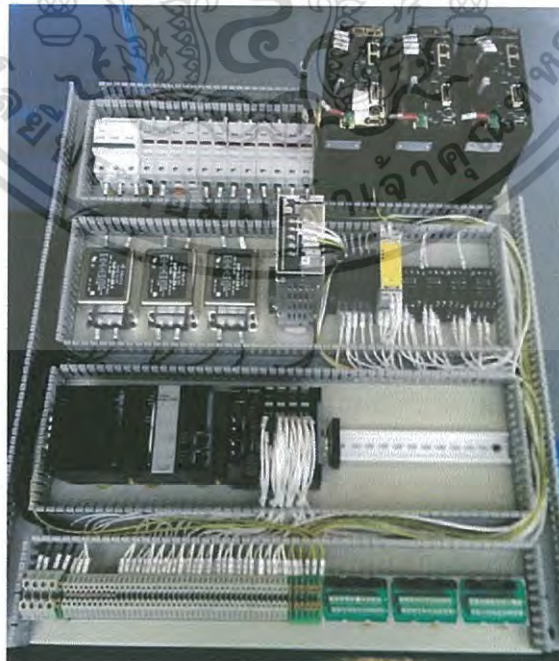
รูปที่ 3.8 การวางอุปกรณ์ไฟฟ้าบนแผงวงจร
