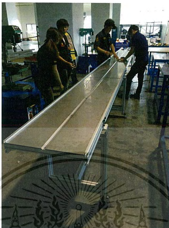
รูปที่ 3.10 การประกอบโครงสร้าง
