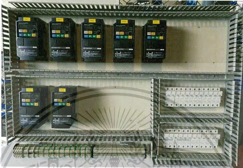
รูปที่ 3.39 การยึดอุปกรณ์ลงบนแผงอุปกรณ์
