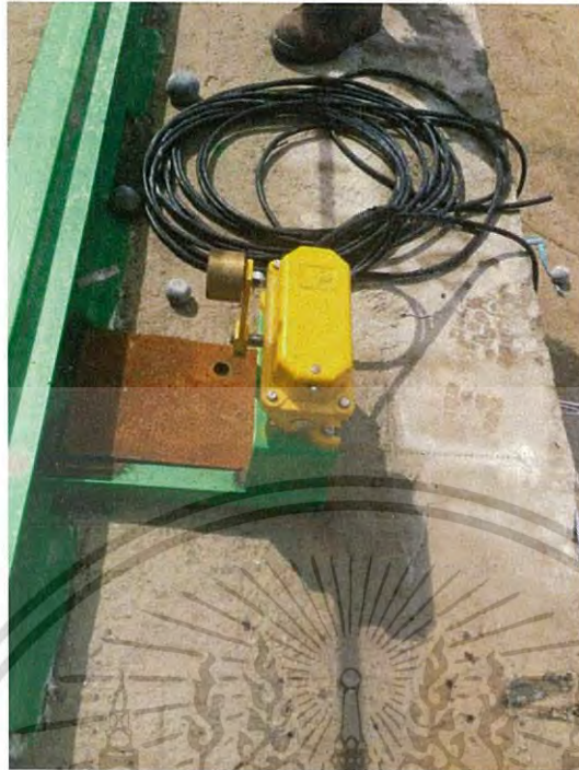
รูปที่ 2.21 การติดตั้ง Roller lever limit switches ที่สายพานลำเลียง
