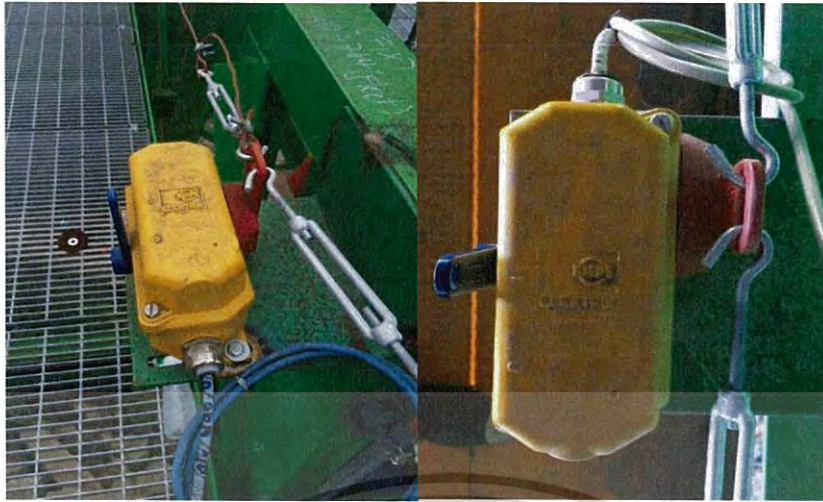
รูปที่ 2.23 การติดตั้ง Pull rope switches ยี่ห้อ KIEPE รุ่น HEN ที่สายพานลำเลียง
