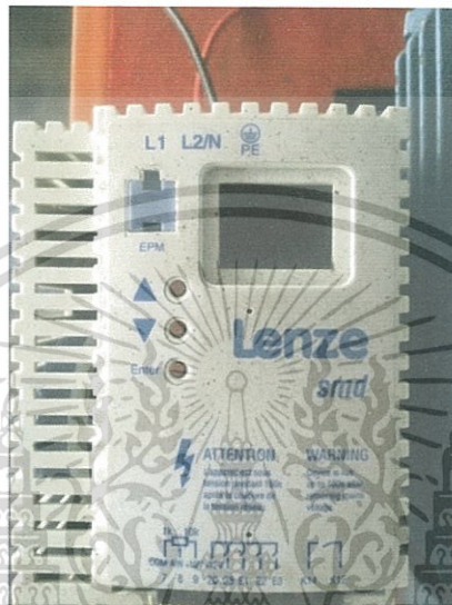
รูปที่ 3-12 อินเวอร์เตอร์ที่ใช้กำหนดรอบ
