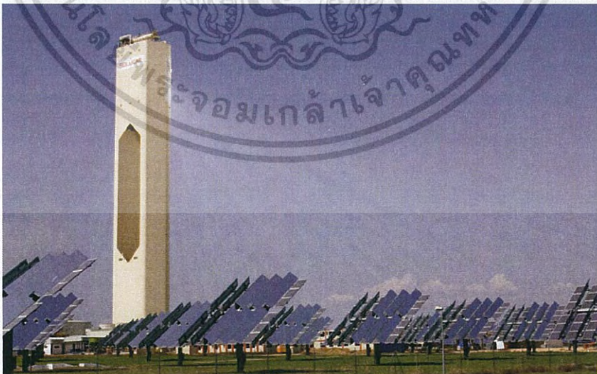
รูปที่ 2.4 แสดงระบบหอคอยแสงอาทิตย์
