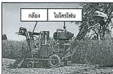
รูปที่ 2 จุดติดตั้งชุดบันทึกภาพและเสียง
