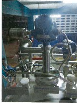
รูปที่ 3.29 แสดงการติดตั้ง Guide Wave Radar
