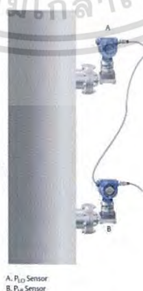
รูปที่ 2.17 แสดงตำแหน่งการติดตั้งอุปกรณ์วัดประเภท Electronic Remote Sensors
