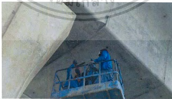
รูปที่ 4.37 การสกัดคอนกรีตบริเวณ Shear Key ที่มีลักษณะแตกร้าว
