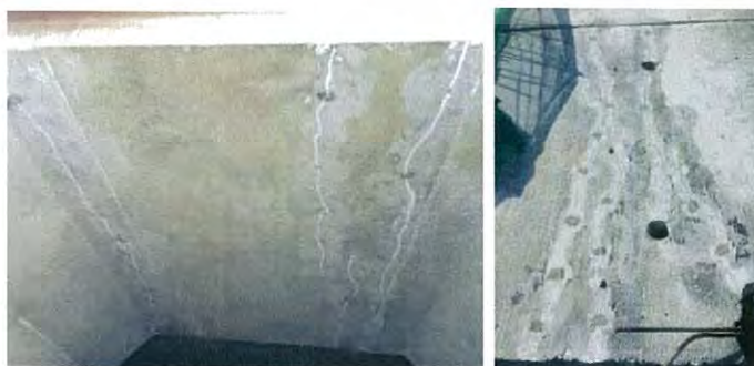
รูปที่ 4.28 สภาพหลังการซ่อมแซมรอยแตกร้าวแล้วเสร็จ
