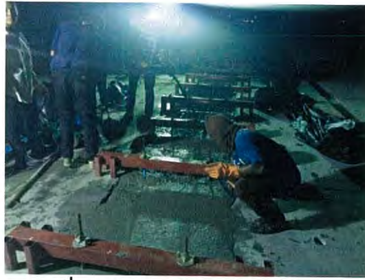
รูปที่ ข.39 การเทคอนกรีต Link Slab
