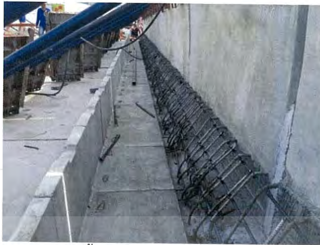
รูปที่ ข.27 การติดตั้งเหล็กเสริมของ Precast Concrete Parapet
