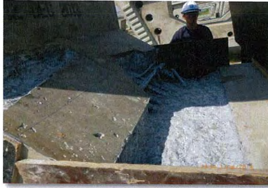
รูปที่ 4.50 การประกอบไม้แบบสำหรับเทคอนกรีต
