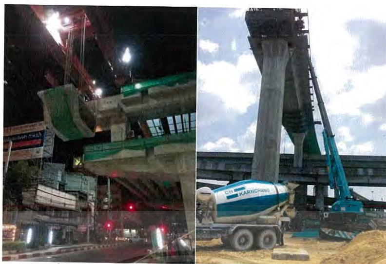
รูปที่ ข.6 การยกขึ้นส่วน Segment เข้าติดตั้งตามตำแหน่ง
