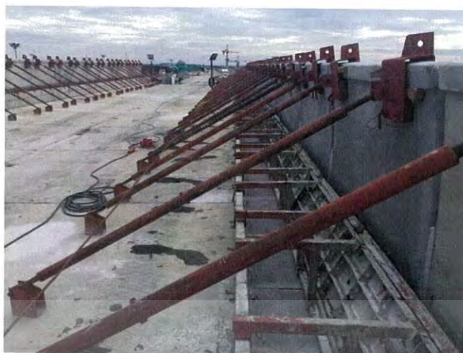
รูปที่ ข.31 การประกอบและค้ำยันแบบหล่อคอนกรีต
