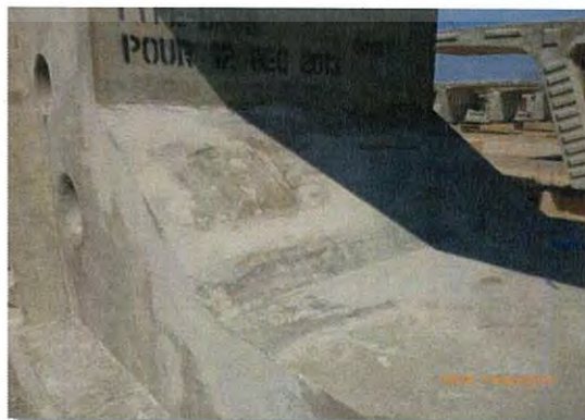
รูปที่ 4.52 การซ่อมแซม Segment มีลักษณะเป็นโพรง (Honeycomb) เสร็จ
