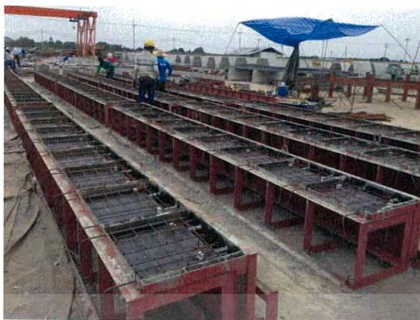
รูปที่ ข.34 การเตรียมแบบหล่อ Cable Trough
