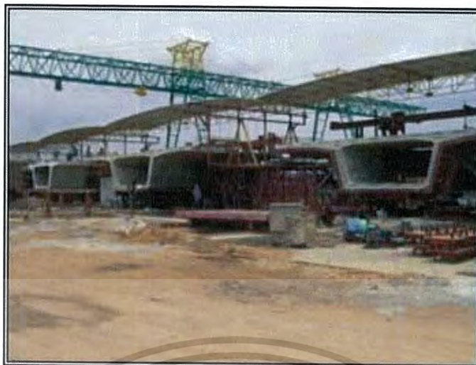
รูปที่ 2.5 การหล่อชิ้นส่วนของคานสะพานรูปกล่องที่โรงงาน (Precast Segmental Viaduct)
