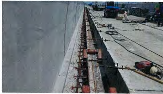
รูปที่ 4.17 การเข้าแบบหล่อเพื่อเตรียมเทคอนกรีต
