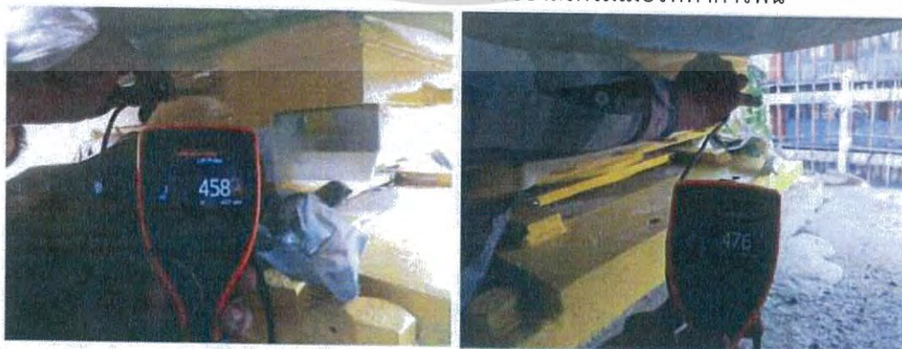
รูปที่ 4.23 การตรวจสอบความหนาของสีไพรเมอร์ของงานเหล็กที่สำหรับยึด Bolt ของ Pot Bearing
