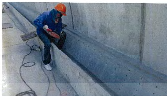
รูปที่ 4.14 การเจาะรูโดยใช้สว่าน สำหรับเสียบเหล็กเสริมคอนกรีต
