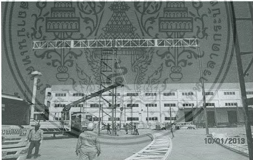
รูปที่ 2.41 การค้ำยันเสาโดยใช้เหล็กโครงหลังคา
