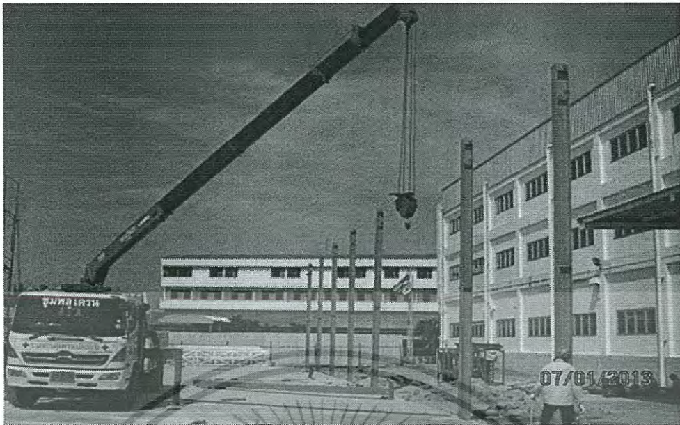
รูปที่ 2.40 การตั้งเสาและการยัดเสากับเหล็กแผ่น
