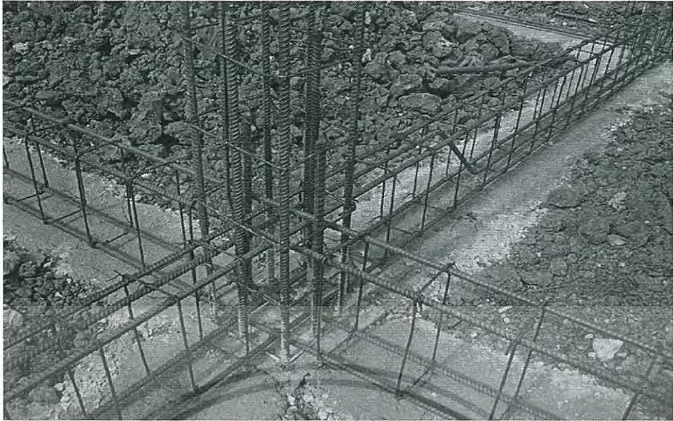
รูปที่ 2.30 การเท lean concrete ก่อนแล้วค่อยวางเหล็กเสริมคาน
