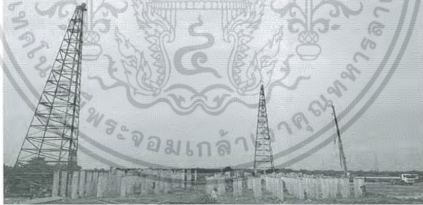
รูปที่ 2.22 การเสร็จสิ้นการตอกเสาเข็ม
