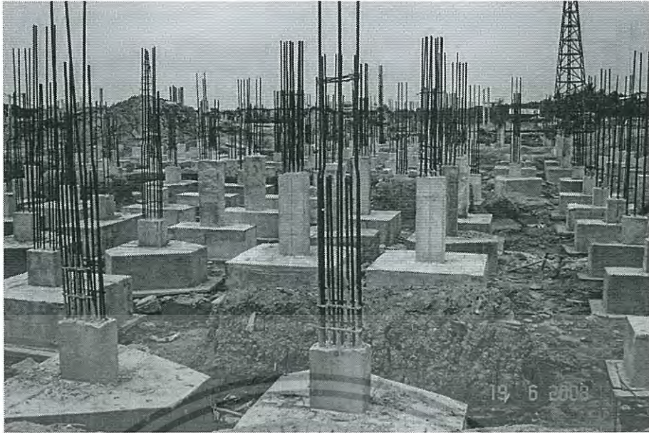
รูปที่ 2.29 ลักษณะของเสาตอม่อ
