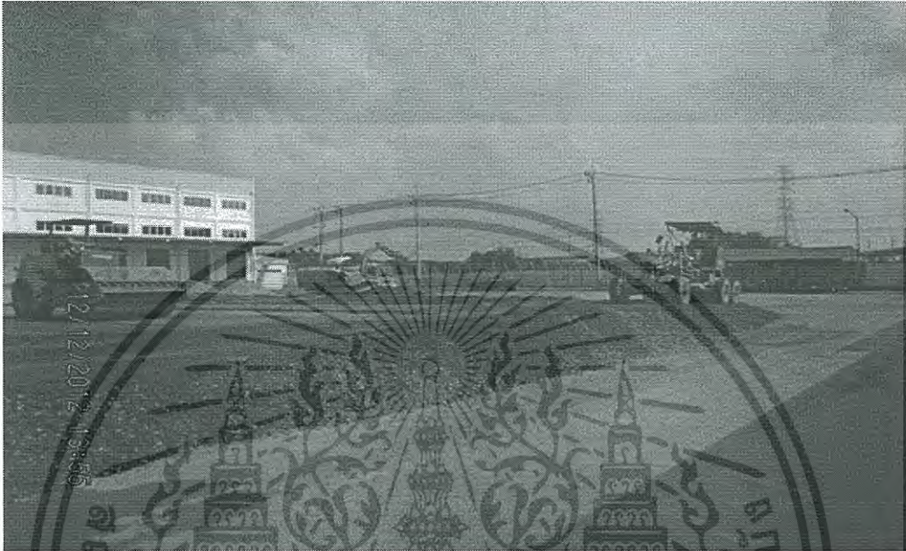
รูปที่ 2.32 การปรับระดับดินและบดอัดดิน
