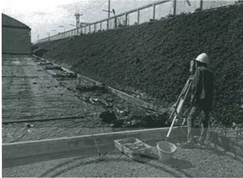
รูปที่ 2.17 ใช้กล้อง Theodolites สร้างแนวอาคาร
