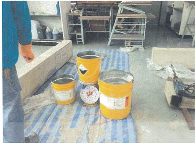
รูปที่ 4.15 การผสมน้ำยาประสาน อีพ็อกซี่ A 3 ส่วน กับ B 1 ส่วน
