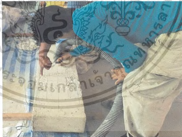
รูปที่ 4.14 การเตรียมผิวเพื่อติดตั้ง CFRP
