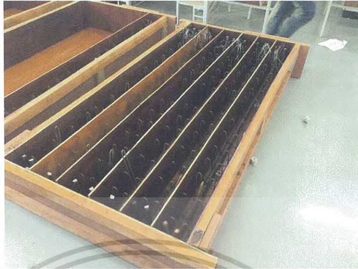
รูปที่ 4.2 แบบหล่อคานคอนกรีต
