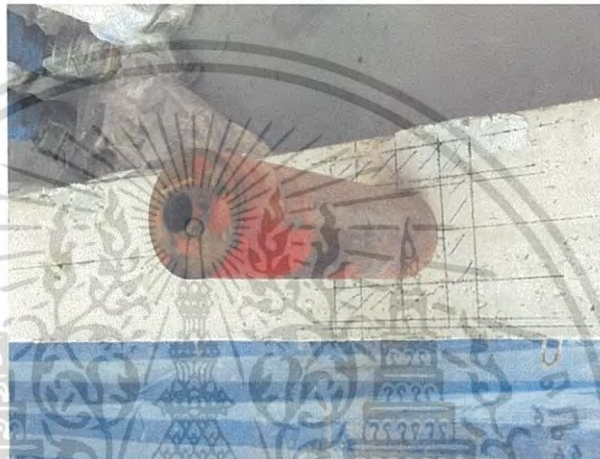
รูปที่ 4.13 วางตำแหน่ง แนวที่จะติดตั้ง CFRP
