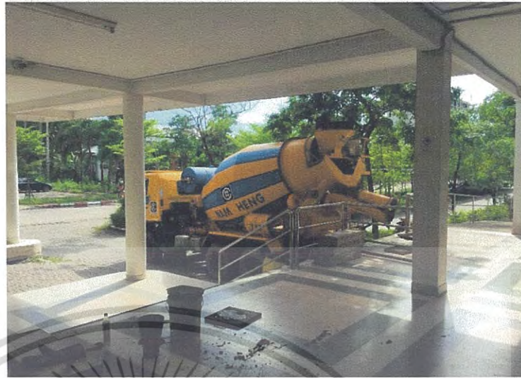
รูปที่ 4.6 คอนกรีตผสมเสร็จที่ใช้หล่อคาน
