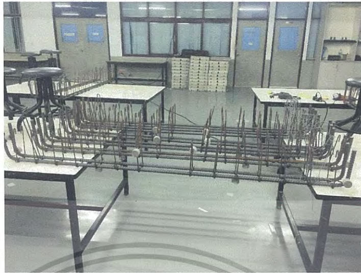
รูปที่ 4.4 ผูกเหล็กคานหนูนลูกปูน
