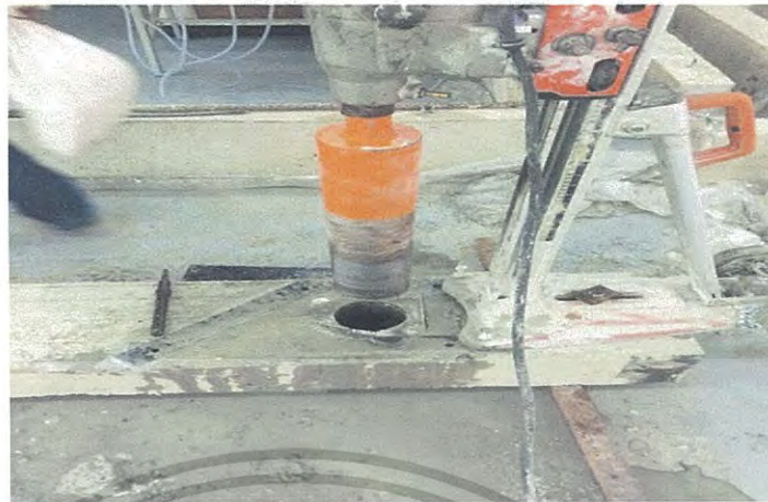
รูปที่ 4.18 ทำการคoringคาน
