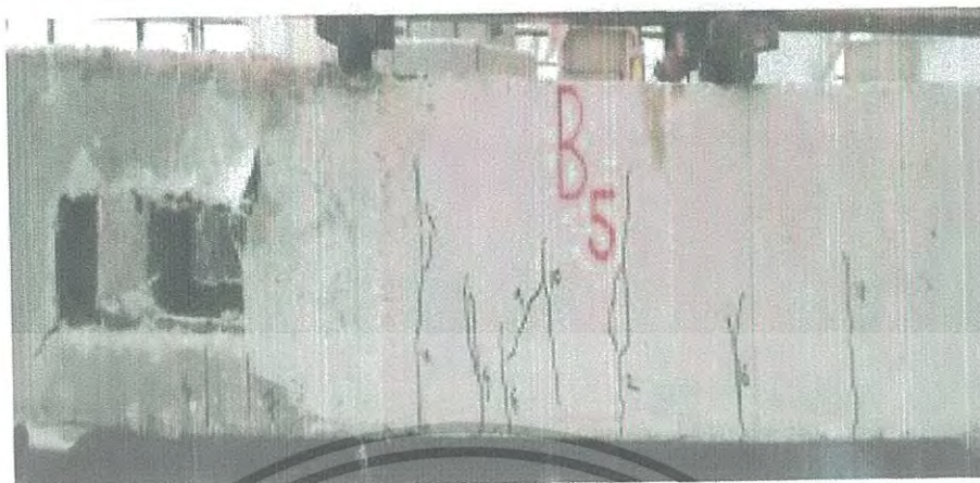
รูปที่ 2.16 GFRP wrapping around the opening by double layer
