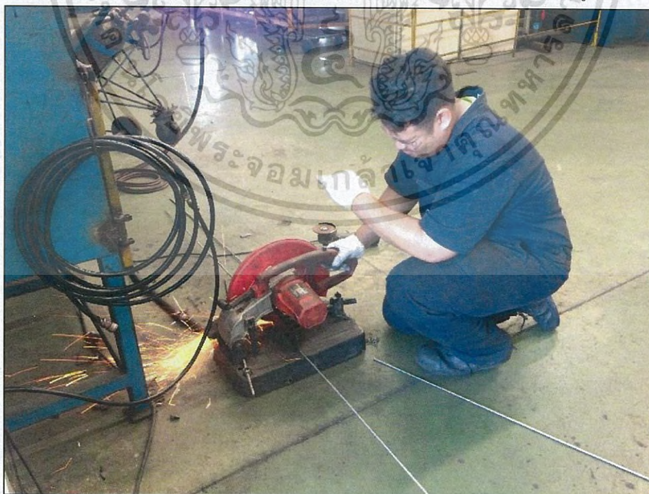
รูปที่ 4.9 การตัดเหล็ก
