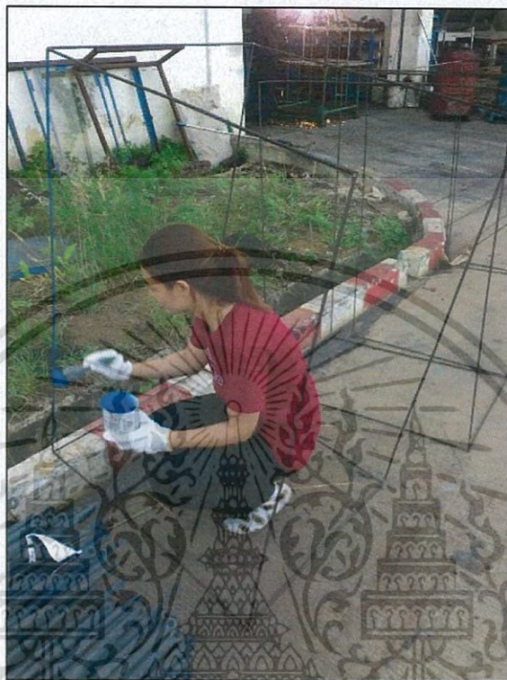
รูปที่ 4.12 การทาสีโครงพื้นที่จัดเก็บกระดาดไข่ไข่
