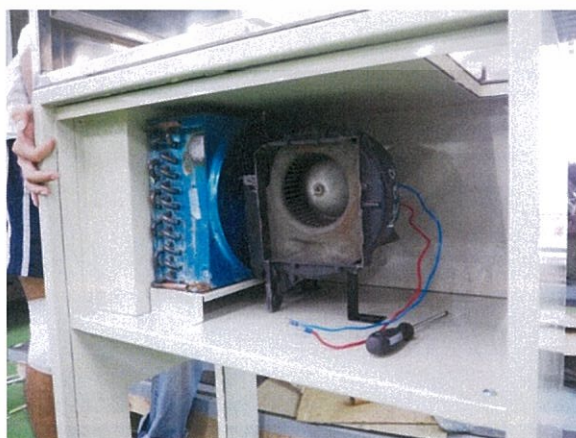
รูปที่ 3.11 ติดตั้งระบบเครื่องปรับอากาศภายในตู้อบ
