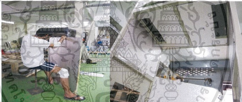
รูปที่ 3.10 ทำการติดตั้งฉนวนกันความร้อน
