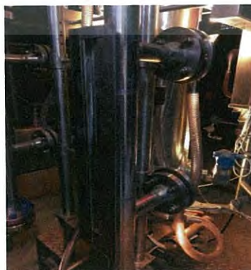
รูปที่ 3.3 อุปกรณ์วัดระดับของเหลวประเภทลูกลอยแม่เหล็ก
