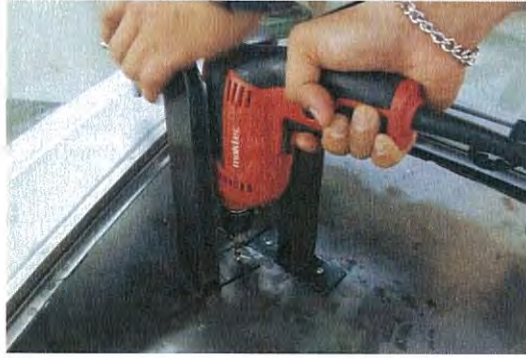
รูปที่ 3.20 การติดตั้ง Clamp บนแผ่นเหล็ก
