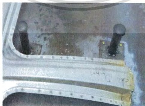
รูปที่ 3.15 การยึดเสาเหล็กติดกับฐานเหล็กด้วยนอต
