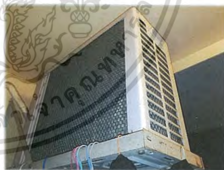
รูปที่ 3.12 การทดลองล้างเครื่องปรับอากาศในกรณีที่คอยล์ร้อนมีสิ่งอุดตัน
