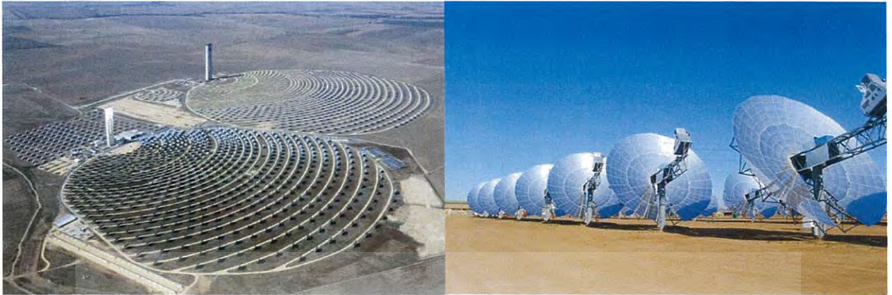
รูปที่ 2.1 โรงไฟฟ้าแบบหอคอยพลังงาน และ โรงไฟฟ้าพลังงานความร้อน ระบบงานรับแสง
