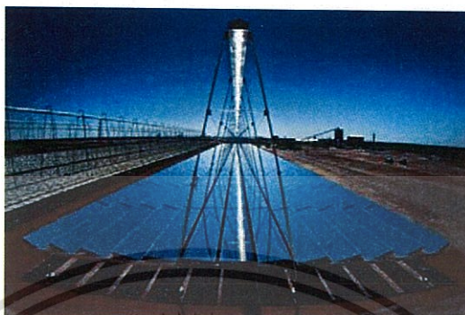
รูปที่ 2.5 แผ่นรับแสงแบบเลนส์สะท้อนรวมแสงแบบเส้นตรง (Linear Fresnel reflector)
