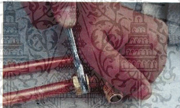
รูปที่ 3.25 ต่อข้อต่อฉากทองเหลืองเข้ากับปลายท่อทองแดงแต่ละด้าน
