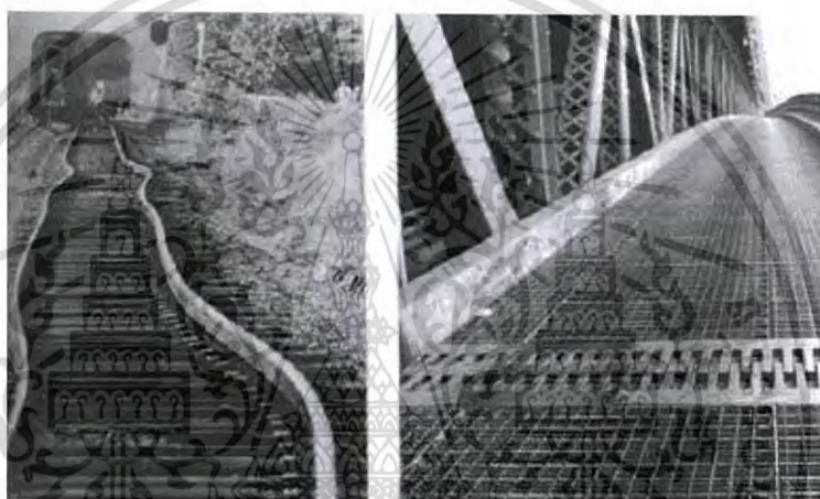
รูปที่ 2.25 แสดงรางรถไฟที่ต้องเว้นช่องว่างเพื่อป้องกันการขยายตัวเมื่อรางรถไฟมีอุณหภูมิสูงขึ้น
