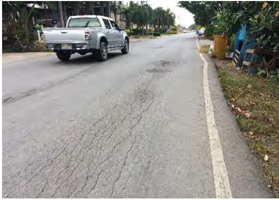
รูปที่ 4.36 กิโลเมตรที่ -1+900 ถึง 0+200 (ทรุดตัวเป็นแนวยาว)
