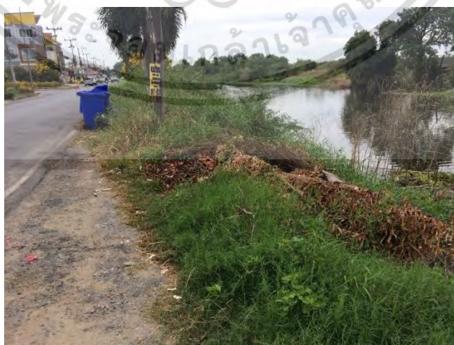
รูปที่ 4.6 คับทางในอดีตที่เกิดการพิบัติแล้ว (สังเกตได้จากพืชที่ขึ้นในบริเวณส่วนใกล้ผิวน้ำ ู ต่อ)
