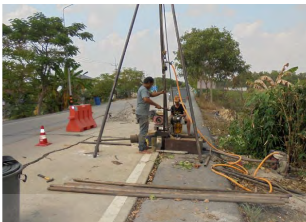
รูปที่ 3.8 การเจาะสำรวจชั้นดินแบบ 3 ข้ำ (รูปหน้างานจริง BH-AY 38)
