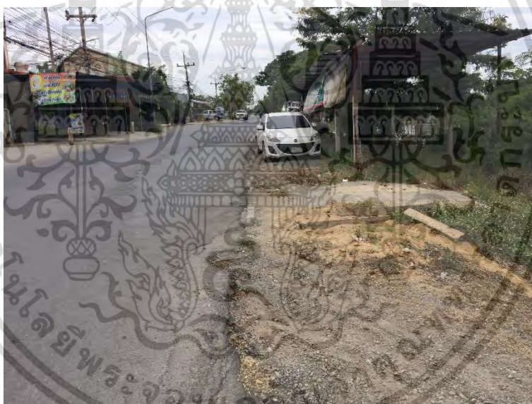
รูปที่ 4.22 จุดพิบัติที่ 2 ระดับ B (ในจุดพิบัติที่ 2 ค้นพบว่าได้มีการพิบัติเกิดขึ้นแล้ว และมีการซ่อมแซมไปแล้ว)
