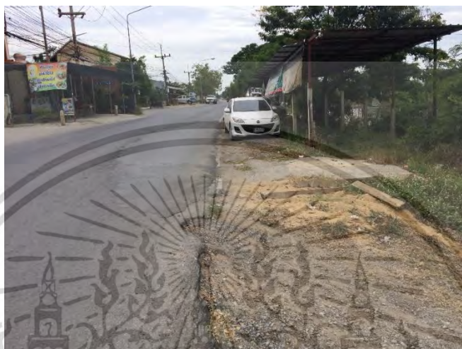
รูปที่ 4.2 ช่วงถนนที่เกิดความเสียหาย และการถมดินเพื่อสร้างโรงจอดรถชั่วคราว
