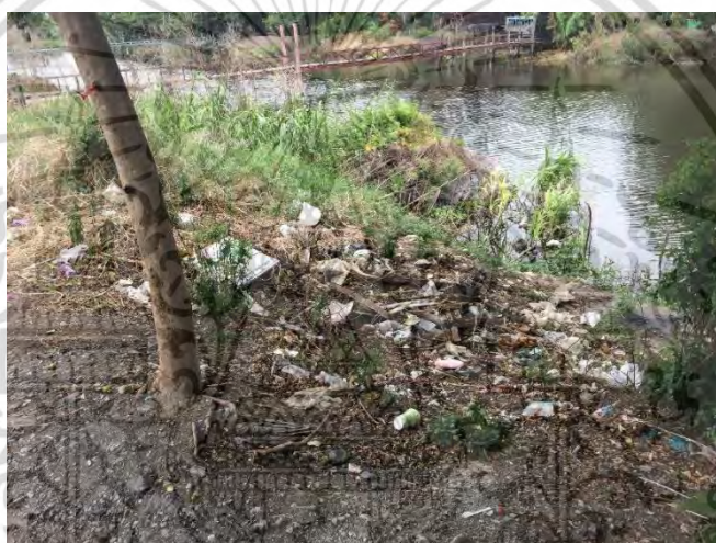
รูปที่ 4.5 คับทางในอดีตที่เกิดการพิบัติแล้ว (สังเกตได้จากพืชที่ขึ้นในบริเวณส่วนใกล้ผิวน้ำ แสดงว่ามี คับทางบางส่วนได้เกิดการเคลื่อนตัวลงไปยังส่วนของคลองชลประทานแล้ว)
