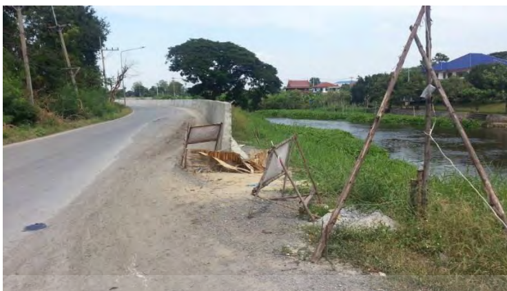
รูปที่ 4.19 แสดงการเสริมก ลัง ฟ้ งค้ นเลี้ย บคลอ งชลประ ทาน (จาก การ ส ามจ พบ ว่า ข้ างต้ ข้ อง โครงสร้ างถนนนี้เป็ นการถมดินท้ บคลอ งชลประ ทานสายย่ ยเดิ ม กิ โลเม เต รที่ -3+300 )
