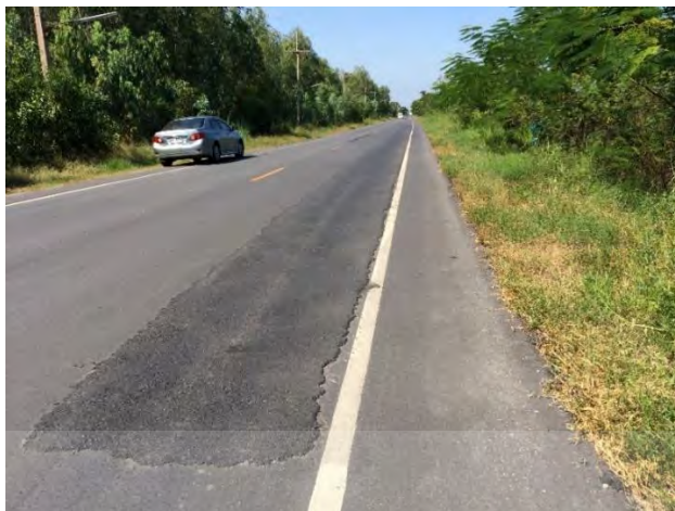
รูปที่ 4.33 กิโลเมตรที่ 4+000 ถึง 4+100
