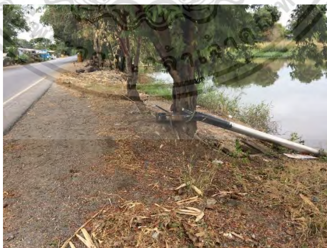
รูปที่ 4.9 ต้นไม้ และการขุดคันทางเพื่อท ารชบสูบน้ำ จากคลองชลประทาน เข้าพื้นที่ไร่นาในฤดูนี้ แล้ง
