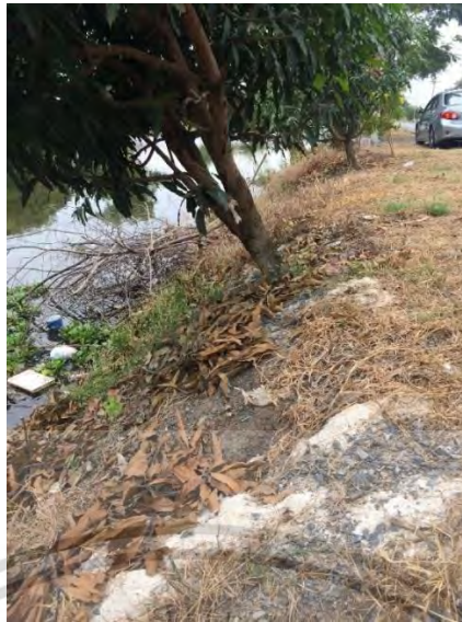
รูปที่ 4.16 แสดงการเอียงตัวของต้นไม้ไปพร้อมกับการเปลี่ยนความชันของคันทาง
