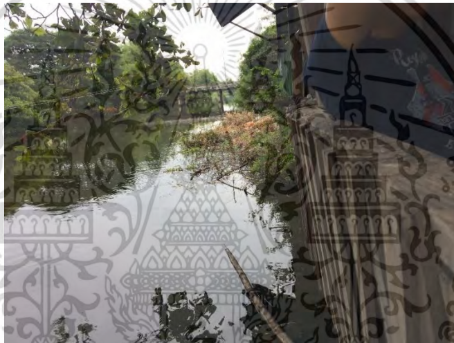
รูปที่ 4.8 ร้านค้าริมทาง และส่วนของคันดินที่เกิดการพิบัติและเคลื่อนตัวลงในคลองชลประทาน
