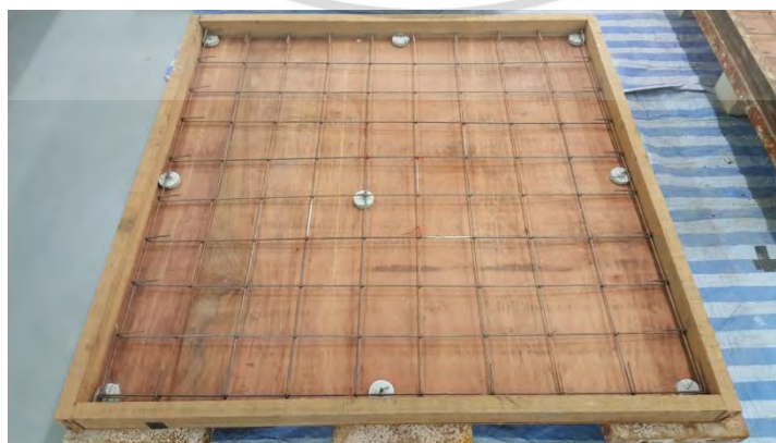
รูปที่ 3.13 แสดงเหล็กเสริมและแบบหล่อสำหรับทำพื้นตัวอย่างทดสอบ
