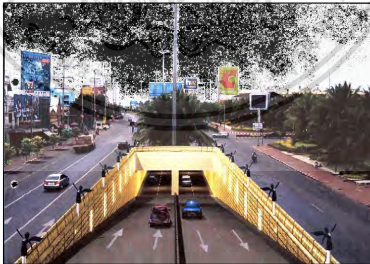
รูปที่ 2.17 ทางแยกต่างระดับแบบทางลอดผ่าน (Underpass) (Wongrawd : 2003)
