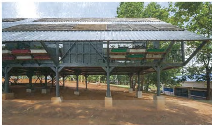
ภาพที่ 4.57 แสดงพื้นที่กึ่งสาธารณะ (Semi-outdoor) บริเวณใต้ถุนอาคาร ที่มา : http://www.forfur.com/media/idea/5483/5483_14569909692073714343
