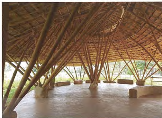
ภาพที่ 4.41 แสดงโครงสร้างไม้ไผ่ที่ตั้งอยู่บนฐานรากหิน
