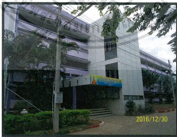
รูปที่ ก.6 อาคาร 2
