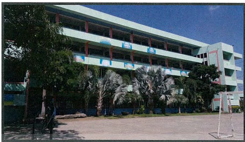
รูปที่ ก.4 อาคาร 5
