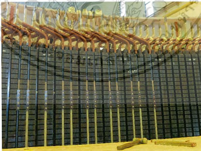
รูปที่ 2.4 ขดลวดสเตเตอร์ของเครื่องกำเนิดไฟฟ้าเชื่อมวชิราลงกรณ จ.กาญจนบุรี
