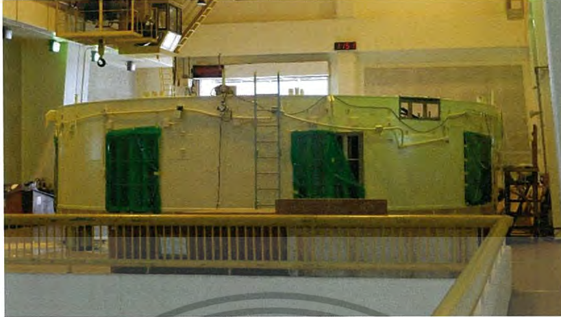
รูปที่ 2.3 โครงสเตเตอร์ของเครื่องกำเนิดไฟฟ้าเชื่อมวชิราลงกรณ จ.กาญจนบุรี
