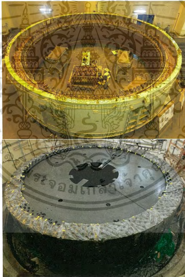
รูปที่ 2.1 เครื่องกำเนิดไฟฟ้าเขื่อนวชิราลงกรณ จ.กาญจนบุรี (ก) สเตเตอร์ (ข) โรเตอร์
