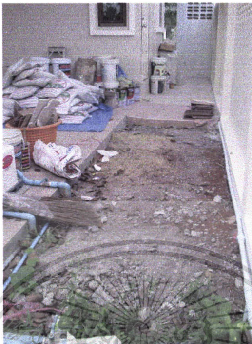
ภาพที่ 12 บริเวณหน้าบ้านด้านขวา (ส่วน A) ทิศตะวันออก ก่อนการปรับปรุงภูมิทัศน์ เดิมเป็นพื้นที่ว่างขนาดเล็ก
