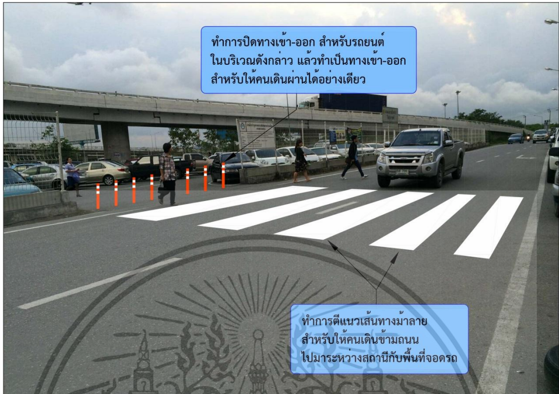
รูปที่ 4.39 แสดงลักษณะการปรับปรุงพื้นที่จอดรถบริเวณพื้นที่จอดรถที่ 1 ในบริเวณ Detail 1
