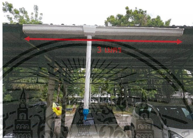
รูปที่ 4.45 หลังคาที่มีพื้นที่รองรับน้ำฝนขนาด 9 ตารางเมตร
