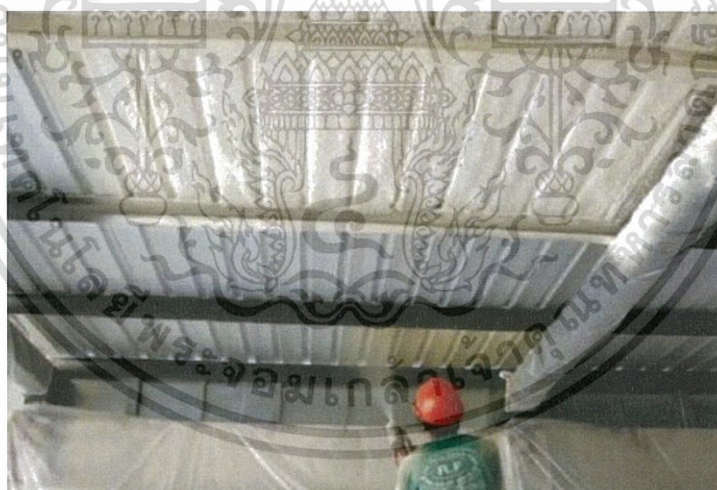
รูปที่ 2.13 การฉีดสารโพลียูรีเทนโฟมที่ผิววัสดุหลังคา
