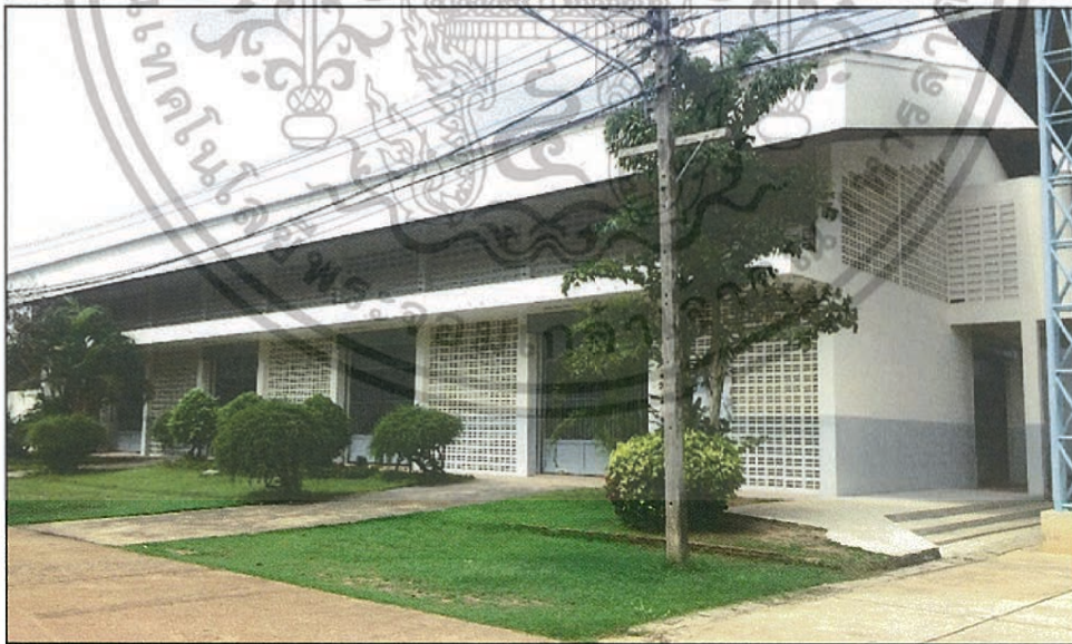
รูปที่ ก.8 อาคารอเนกประสงค์ (หอประชุม)
