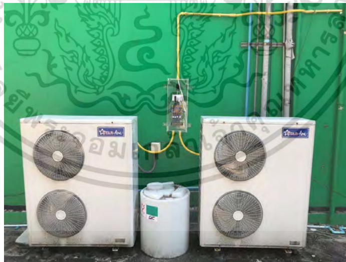
รูปที่ 4.5 การติดตั้งระบบควบคุมเครื่องปรับอากาศ
