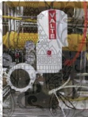
รูปที่ 2.7 Control Valve
