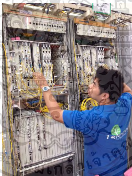
รูปที่ 2.4 อุปกรณ์โครงข่าย DWDM ที่ใช้งานอยู่ในปัจจุบัน
