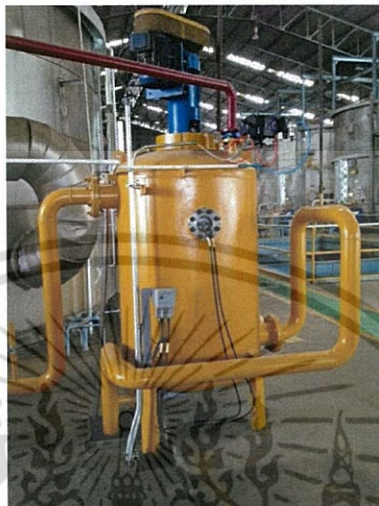
รูปที่ 2.24 Molasses diluter tank
