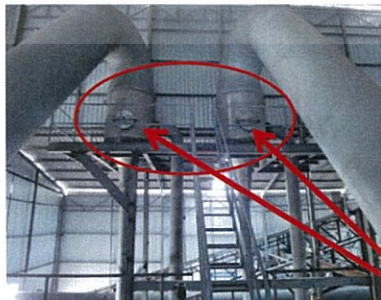
รูปที่ 2.40 การติดตั้ง Jet condenser ของหม้อเคี้ยววนอน
