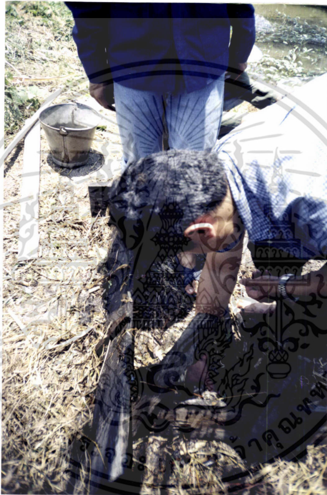
ภาพที่ 7 การนำฝักตบชวาหรือฟางข้าวใส่ลงในแบบไม้ โดยเรียงฝักตบชวาหรือฟางข้าวตามความยาวของแบบไม้ โดยให้แต่ละชั้นหนาประมาณ 10 เซนติเมตร แล้วกดหรือย่ำให้แน่น
