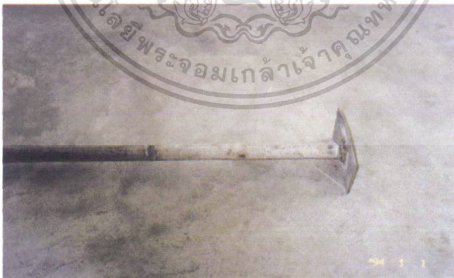
รูปที่ 76 แสดงเสายึดท่อร้อยสายไฟ
