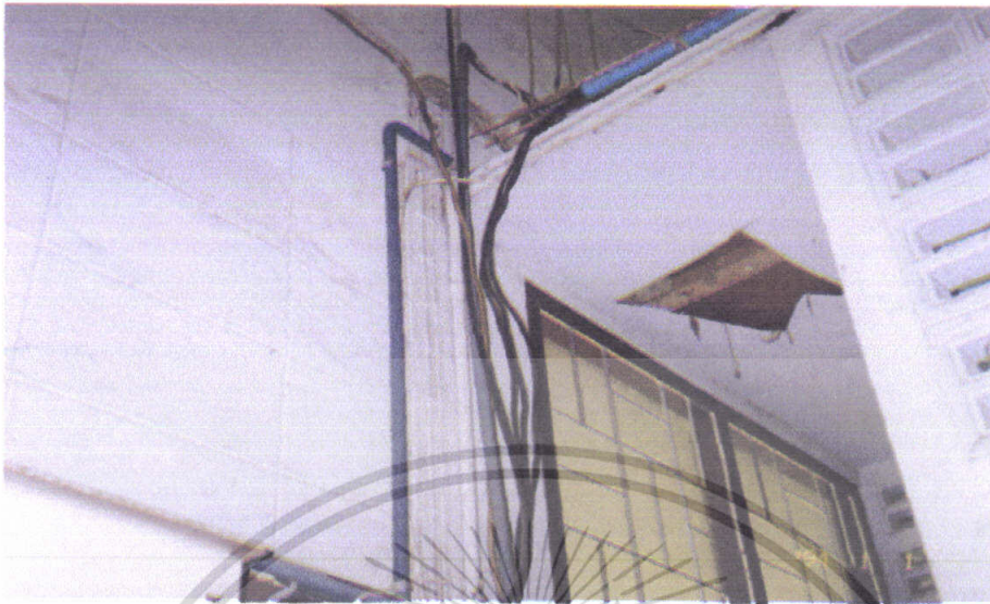
รูปที่ 73 ก่อนทำการเดินสายไฟ
