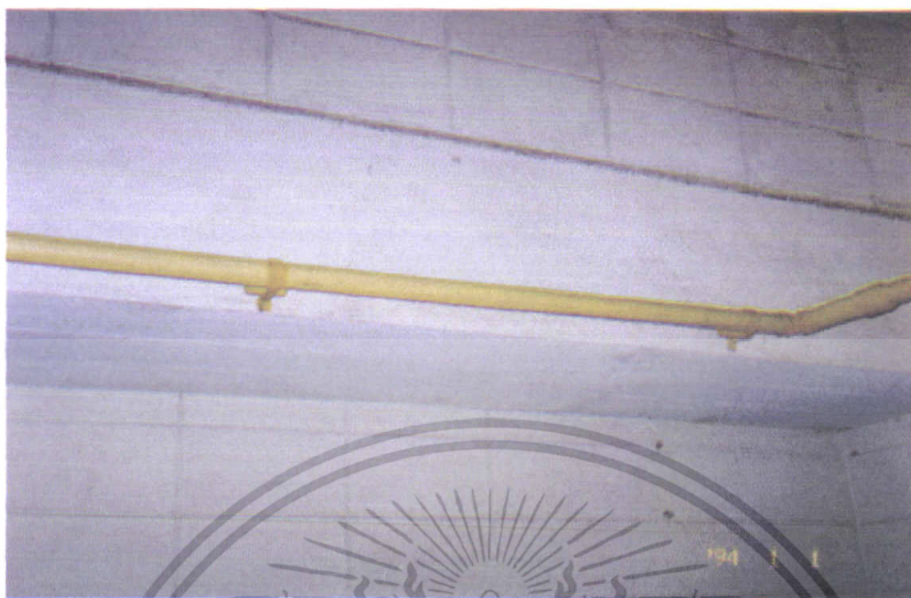
รูปที่ 79 แสดงการยึดท่อกับผนัง
