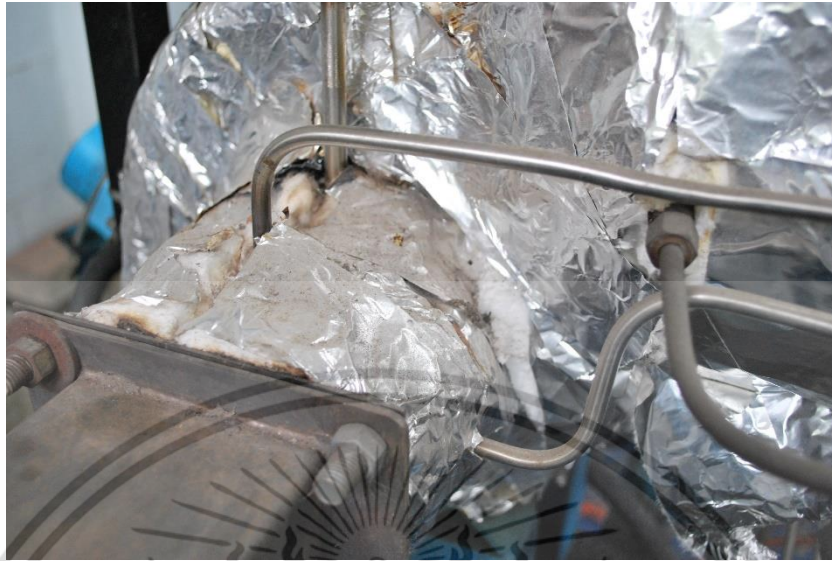
รูปที่ 4.22 ตำแหน่งวัดความดันทางออกเทอร์ไบน์
