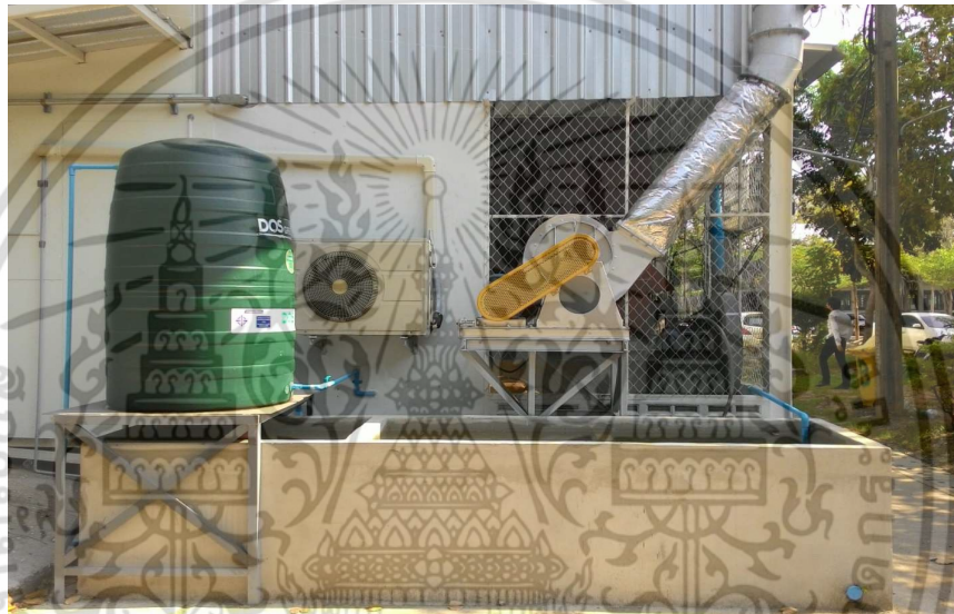
รูปที่ 5.18 บ่อดักตะกอน และพัดลมดูดไอเสีย
