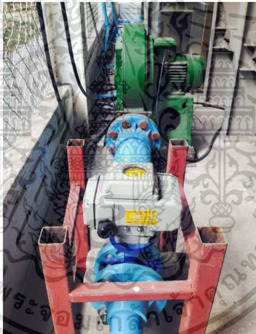
รูปที่ 5.9 โบลเวอร์ และวาล์วปรับอัตราการไหลอากาศส่วนที่หนึ่ง (primary air)
