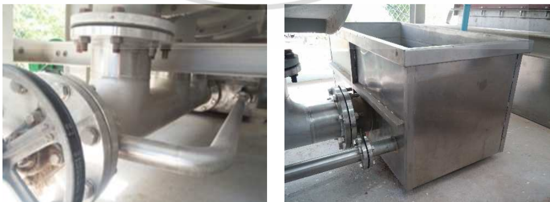
รูปที่ 5.14 สกรูระบายไถ่หนัก และถังพักไถ่หนัก
