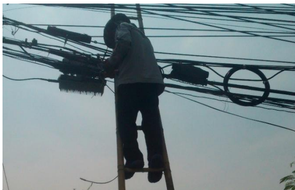
รูปที่ 4.9 การแก้ไขสายโคแอกเชียลที่ผิดพลาดที่ต่อเข้ากับอุปกรณ์
