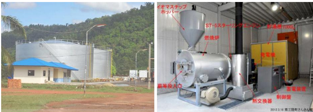
รูปที่ 1.5 โรงไฟฟ้าพลังงานชีวมวลโดยใช้เครื่องยนต์ของ ST-5 ที่จังหวัดพนมเปญ ประเทศกัมพูชา โดยความร่วมมือของบริษัทจากประเทศญี่ปุ่นและบริษัทจากประเทศสหรัฐอเมริกา แหล่งภาพ : http://www.pro-materials.com/en/international_cooperation/01.html
