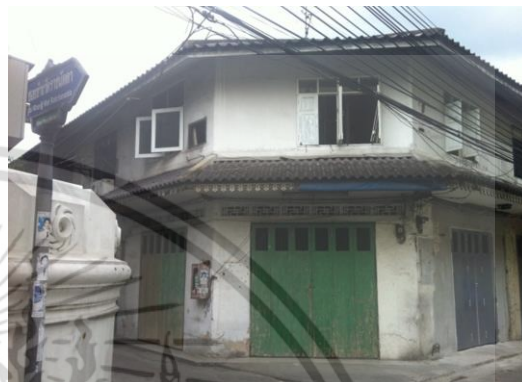
(2) การปรับปรุงประตูไม้และการเปิดช่องลม (*)
