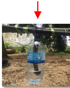
ประกอบสายส่งท่อ พร้อมติดตั้งชุดปรับแรงดัน
