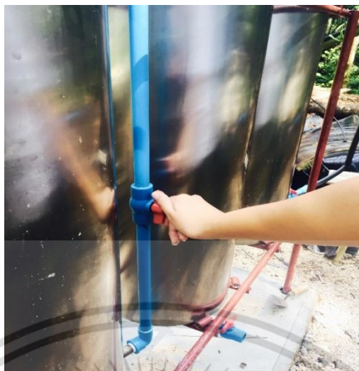
รูปที่ 3.21 การเปิดวาล์วทางเข้า-ออก และระหว่างตัวกรองทุกตัว
