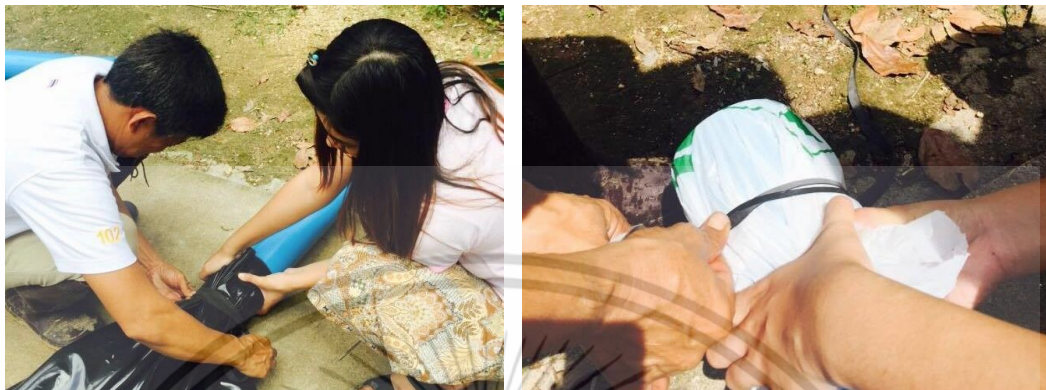
รูปที่ 3.6 การผูกท่อพีวีซี ที่ปลายทั้งสองข้างของถุง
