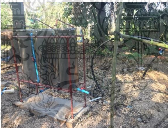
รูปที่ 3.16 การประกอบระบบกรองก๊าซชีวภาพ
