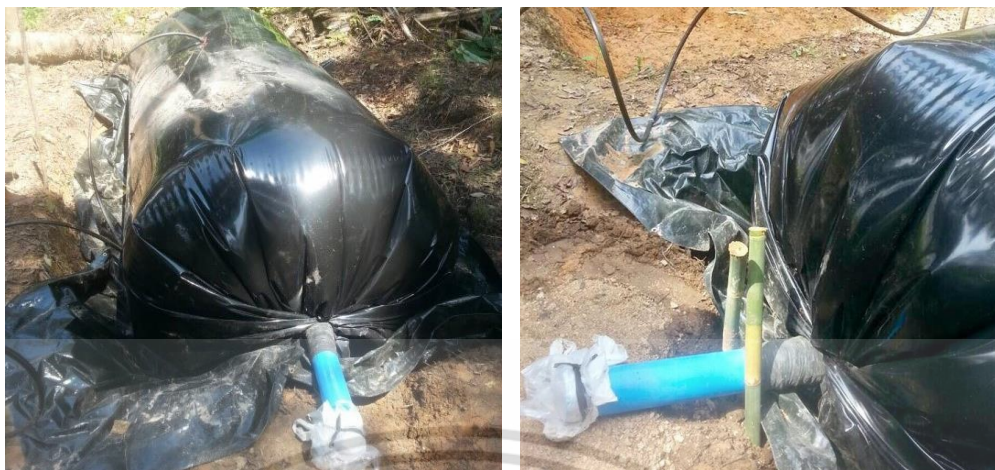
รูปที่ 3.8 การนำถุงลงหลุมและจัดวางถุงให้ดี
