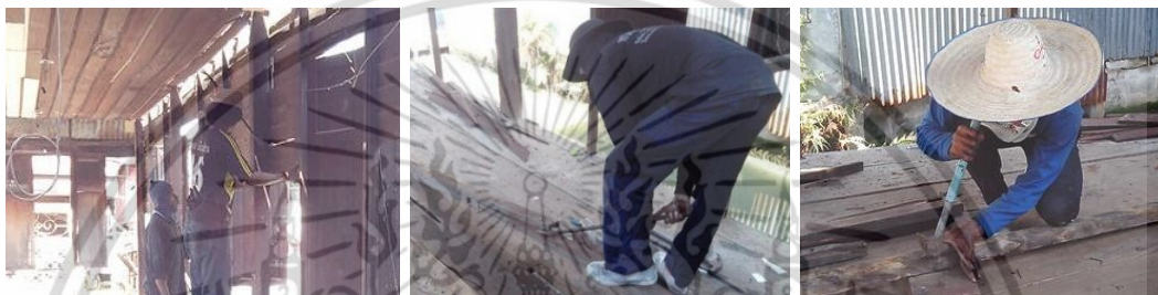
ใช้ชะแลงจัดคร่าออกจากฝาผนัง และถอนตะปูออกจากไม้
