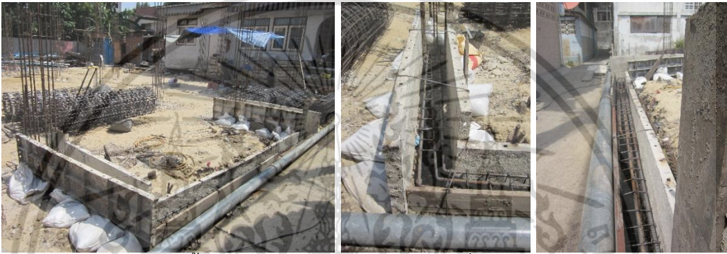
เข้าแบบหล่อคานพื้นและยึดแบบโดยตอกยึดสลักและเชื่อมเหล็กแบบหล่อให้ติดกัน
