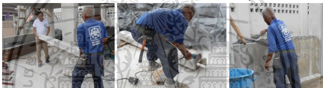
วัดขนาดความยาวตามหน้างานจริง และตัดด้วยหินเจียรไฟฟ้า ใช้เกรียงก่อปูนกาวตามแนวที่จะติดตั้ง
