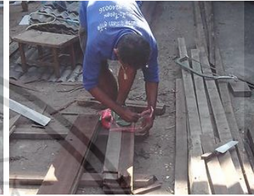
ตัดไม้ปลายไม้ด้วยเลื่อยคันทันธู ถอนตะปูออก แล้วมัดคองไม้รวมรวมด้วยเชือก
