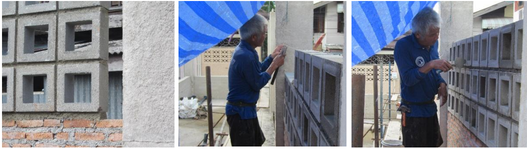
แนวก่อบล็อกช่องลม เหลือช่องไว้สำหรับก่ออิฐมอญอดแนวข้างเสา เสาร่องแนวก่อให้เรียบร้อย
