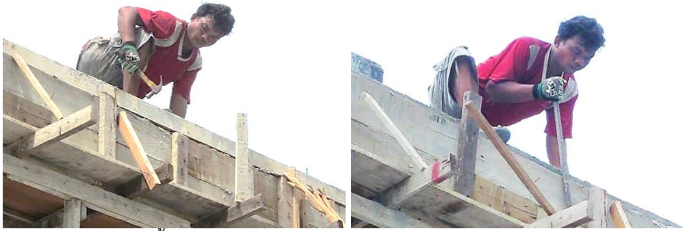
ใช้ค้อนตอกให้ไม้ค้ำแบบหลุดออกจากแบบ ใช้ชะแลงจัดแบบหล่อให้หลุดออกจากคาน
