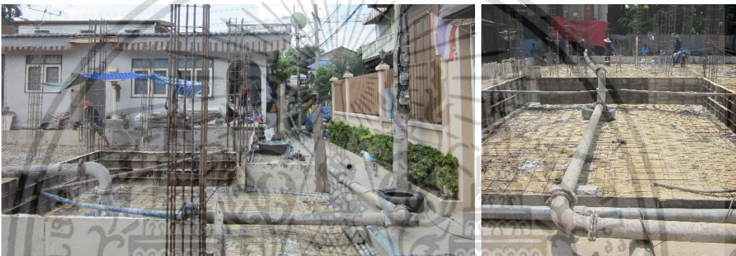
ต่อท่อกล้าในชั้นสำหรับเทคอนกรีตจากรถผสมคอนกรีตสำเร็จรูปที่ปั๊มคอนกรีตมายังภายในพื้นที่เทพื้น
