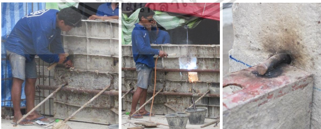
ใช้ค้อนปอนด์ตอกสลักยึดแบบ เชื่อมเหล็กค้ำกับแบบเหล็กหล่อแนวบนและที่บริเวณข้างเสา
