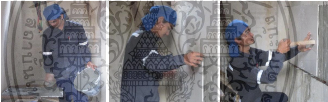
ใช้เกรียงตักปูนขาวที่ผสมแล้วปาดลงบนกระเบื้อง ยกขึ้นติดกับผนังแล้วใช้ด้ามค้อนเคาะให้ยึดแน่น
