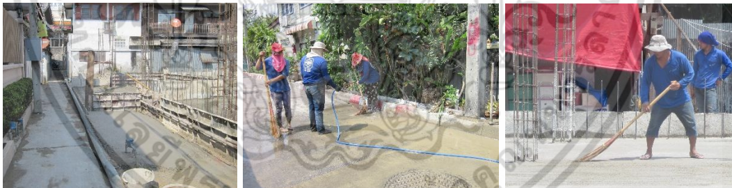
ใช้ไม้กวาดทางมะพร้าวทำความสะอาดเศษปูนบนพื้น และปิดเพิ่มผิวสัมผัสให้พื้นคอนกรีต
