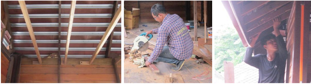
ตัดไม้โครงไม้ไผ่ค้ำยันคาน ฝ้าและวางตำแหน่งให้ได้ระยะพอติดระหว่างอะเสกับเชิงชาย
