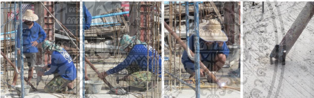
ใช้สว่านไฟฟ้าเจาะรูที่พื้นคอนกรีต ใช้ค้อนปอนด์ตอกเหล็กเส้นลงในรู และเชื่อมติดกับเหล็กค้ำแบบ
