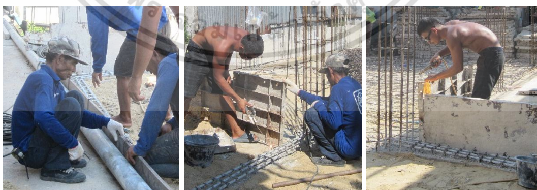
เข้าแบบหล่อพื้นบริเวณคานพื้นด้านหน้า และเชื่อมยึดแบบเหล็กหล่อพื้น คสล.
