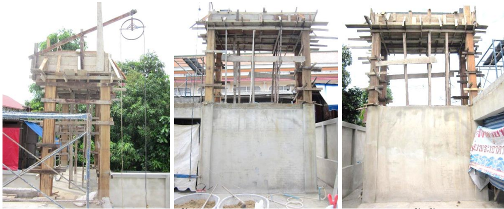
ด้านหน้า และด้านข้างทั้งสองด้านของแบบหล่อคาน-หลังคา ห้องน้ำชั้น 2
