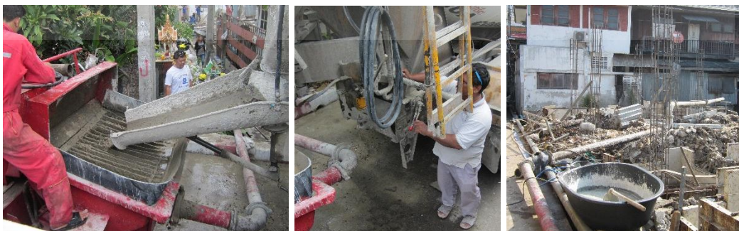
เทคอนกรีตลงกะบะบนรถปั๊ม และเปิดสวิตช์ปั๊มให้คอนกรีตส่งผ่านท่อกล้าวาไนซ์เข้าไปยังหลุมฐานราก
