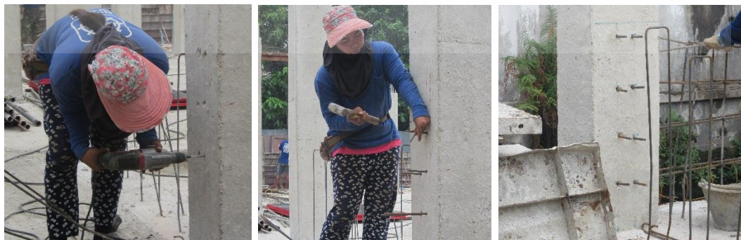
วัดระยะก่อนซึ่งสายเอ็นแนวขอบบนผนัง ใช้ส่วนไฟฟ้าเจาะรู และใช้ค้อนปอนด์ตอกเหล็กเสริมใส่ในรู
