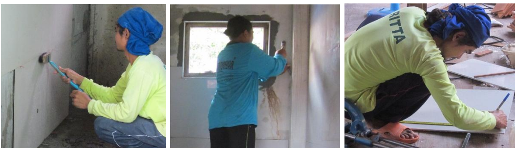
ใช้สว่านเจาะสกัดเศษปูนตามของเสารอก ปูกระเบื้องผนังแล้วใช้แผ่นพลาสติกเสียบคั่นระหว่างแผ่น
