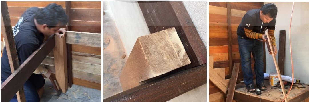
วัดระยะและตัดไม้ปิดแนวตงพื้นชั้น2
