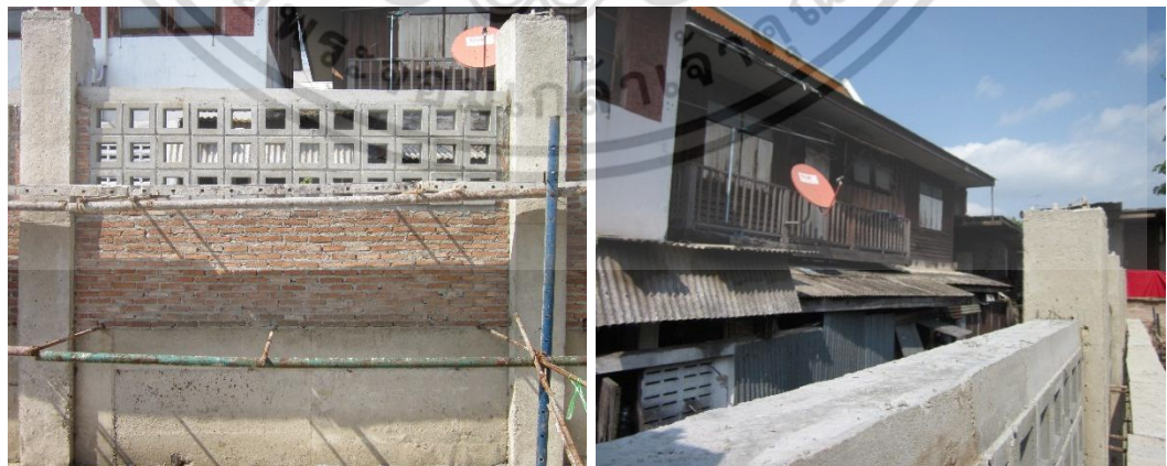
ถอดแบบหล่อทับหลังออก รอทำการจับเซ็ยและฉาบผนังภายนอกและในต่อไป
