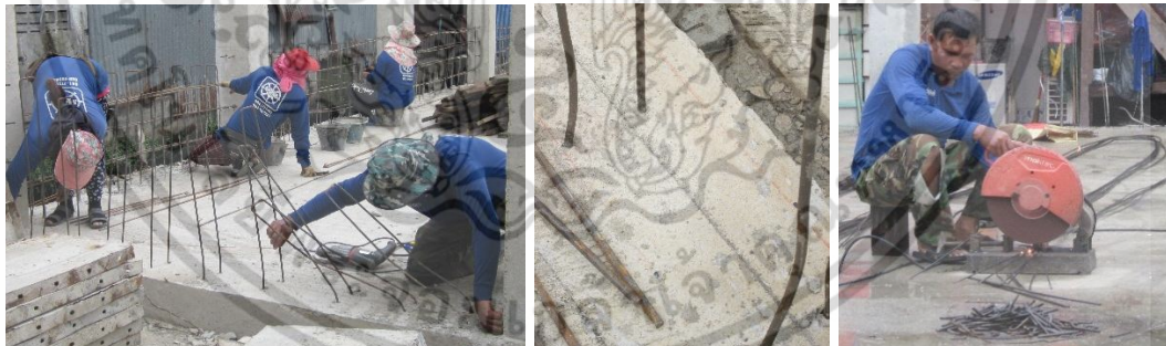
วัดระยะและใช้เต่าตีเส้นแนวผนังที่จะทำการเข้าแบบเหล็กหล่อ พร้อมตัดเหล็กเสริมรอบผนัง
