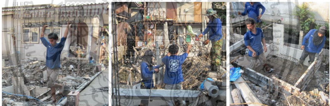
ยกเหล็กเสริมฐานรากเข้ามายังหลุมฐานรากและปรับตำแหน่งให้ตรงกับศูนย์กลางเสาตามแบบ
