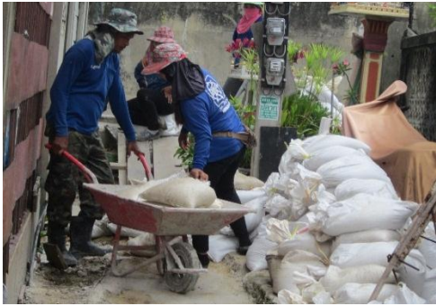
ขนทรายและซีเมนต์เพื่อนำมาผสมในกะบะผสมด้วยจอบจนส่วนผสมเข้ากัน
