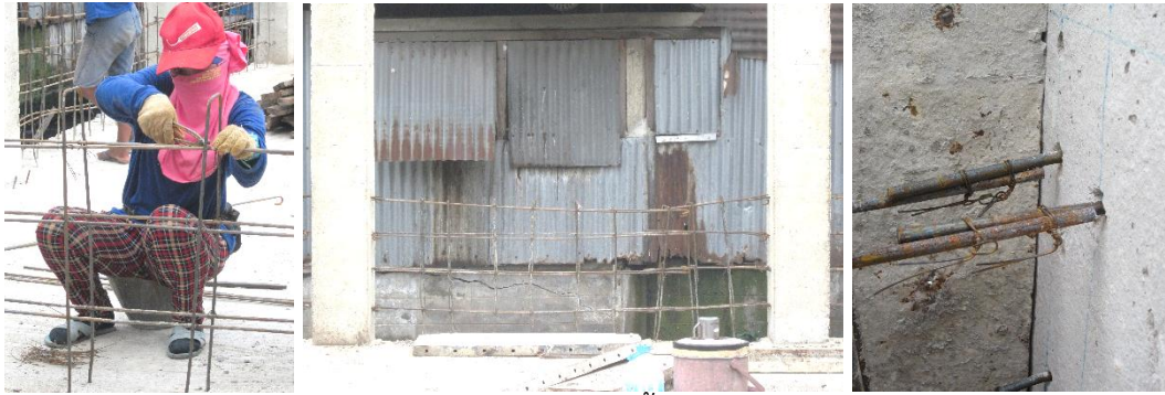
ใช้คีมผูกลวดยึดเหล็กเสริมแนวตั้งและนอนเข้าด้วยกัน
