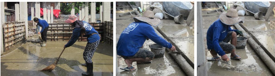
กวาดพื้นด้วยไม้กวาดทางมะพร้าว และใช้เกรียงปาดและตักเศษคอนกรีตที่ตกตามพื้น
