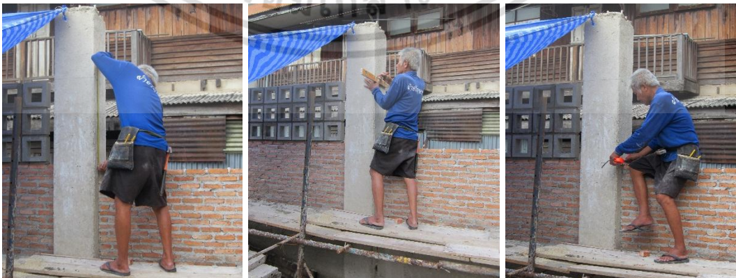
ใช้ตลับเมตรวัดระยะตำแหน่งที่จะทำแนวยึดเอ็นชิ่งกับตะปู และกำหนดตำแหน่งด้วยดินสอปากแบน
