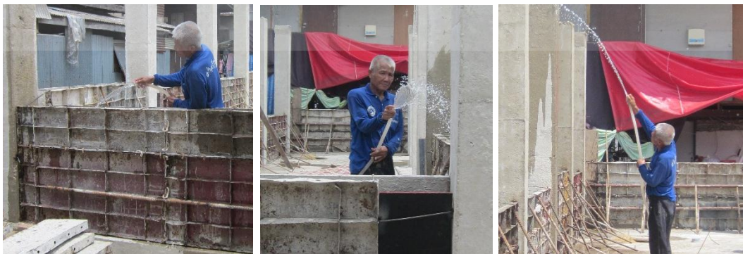
ใช้น้ำฉีดรดตามเสาและแบบเหล็กหล่อผนัง
