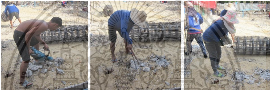
ใช้เครื่องสกัดเจาะเสา คสล. ที่โผล่พื้นระดับดินออก ตัดเหล็กเสริมและขนย้ายออกจากพื้นที่
