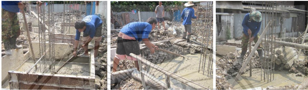
ใช้จอบเกลี่ยคอนกรีตและไม้ปาดฉาบคอนกรีตปรับระดับสม่ำเสมอ
