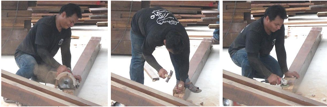
วัดระยะและใช้เลื่อยวงเดือนบากหัวเสา ใช้ค้อนตอกลิ้มให้ไม้หลุด แล้วใช้หินเจียรไฟฟ้าขัดให้เรียบ
