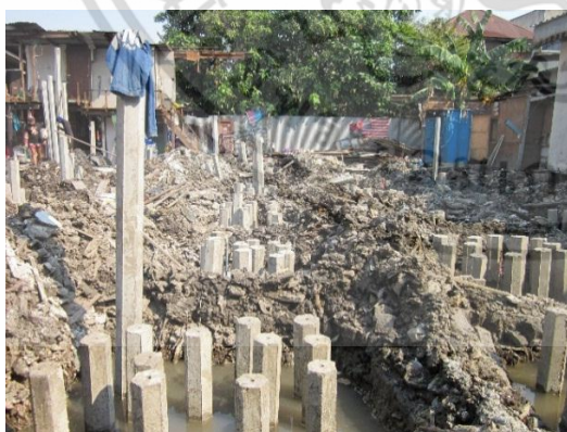
เสาเข็มที่ถูกตอกลงในหลุมเสาเข็มแล้ว
