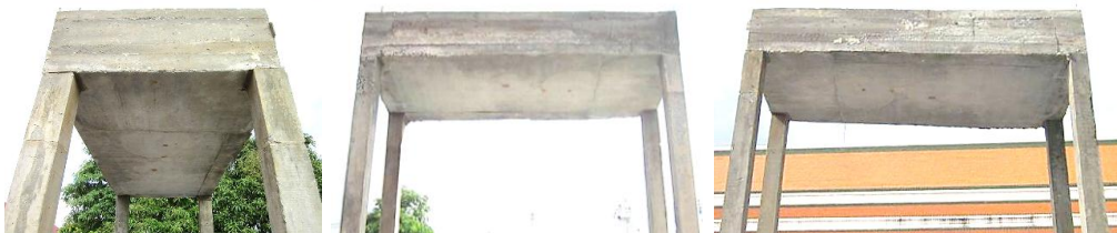
รูปขยายคาน-หลังคาที่ถอดแบบเสร็จแล้ว
