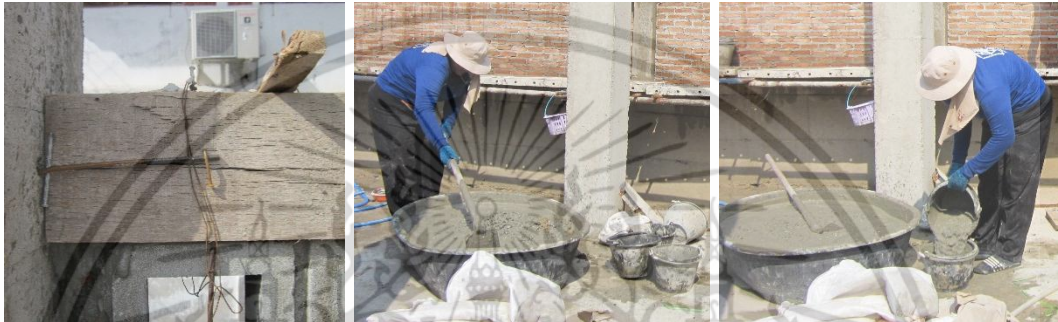
ยึดเหล็กเสริมที่เสากับไม้แบบด้านในและผูกลวดให้แน่น ผสมคอนกรีตในกระบะผสมและตักใส่ถัง
