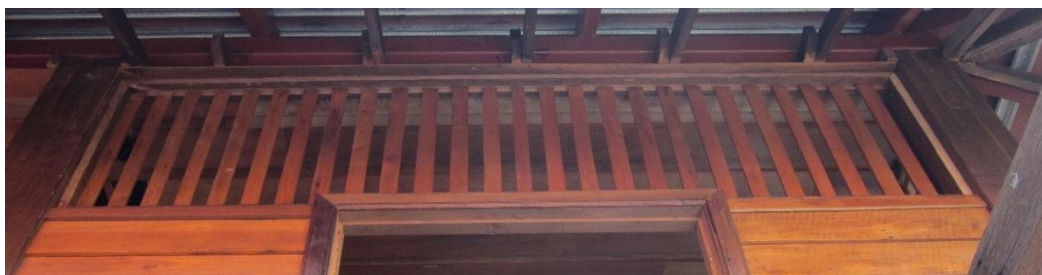
ไม้ระแนงช่องแสงที่ติดตั้งเสร็จแล้ว
