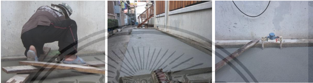
เทคอนกรีตปรับผิวพื้น และใช้เกรียงฉาบผิวปรับให้เรียบ
