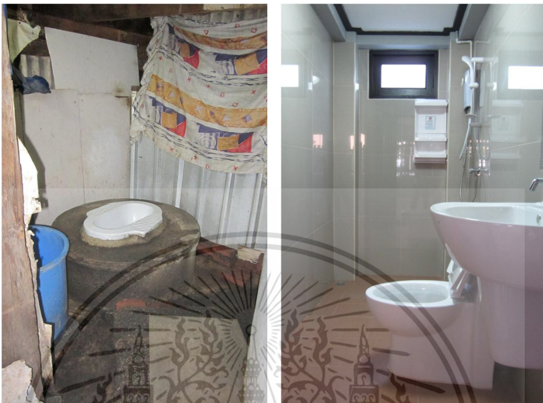
พื้นที่ห้องน้ำ ก่อนและหลังซ่อมแซม
