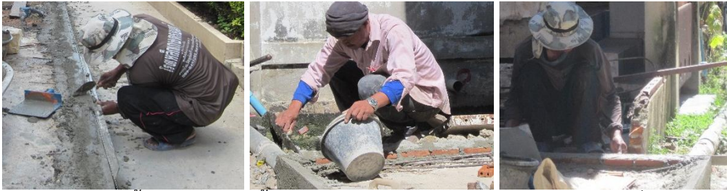
วัดระยะ จับเชี่ยมและก่อขอบพื้นคอนกรีตโดยใช้เกรียงก่อ เกรียงฉาบและสามเหลี่ยมปาด
