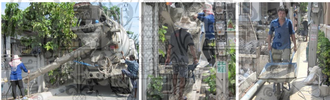
เทคอนกรีตจากรถผสมคอนกรีตสำเร็จใส่รถเข็นแล้วเข็นเข้าไปยังบริเวณที่จะเทพ้องกันดิน
