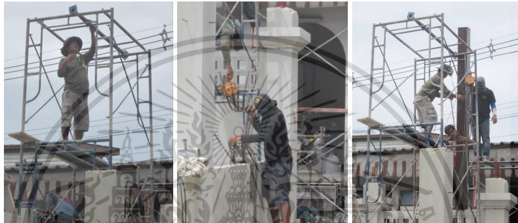
ตั้งนั่งร้านและโครงสำหรับติดตั้งรอกโซ่เหล็ก ดึงรอกยกไม้เสาขึ้นบนให้ตั้งฉาก
