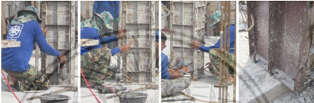
ใช้สว่านไฟฟ้าเจาะรูที่พื้นคอนกรีต ใช้ค้อนปอนด์ตอกเหล็กเส้นลงในรูที่เจาะและเชื่อมติดกับแบบ
