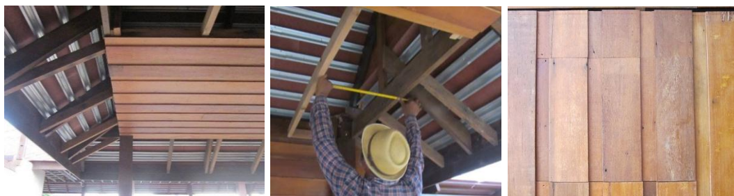
หลังจากกำหนดดีเต้าแล้ว ใช้ปืนยิงตะปูลมยึดแผ่นไม้ฝ้ากับโครงคานโดยแผ่นยึดหน้า 2” ก่อนหน้า 4” ซ้อนทับ โดยเริ่มจากไม้ตรงกลางก่อนไล่ไปจนสุดขอบของทั้งสองฝั่ง
