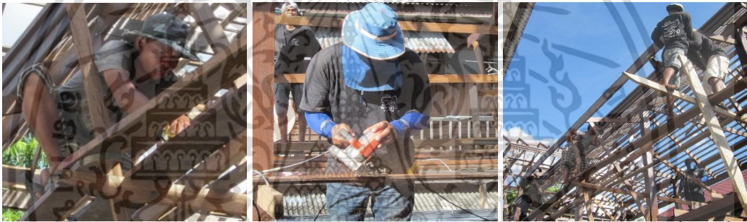
ใช้ตลับเมตรวัดระยะไม้ปิดแนว ใช้เลื่อยวงเดือนตัดปลายไม้ในแนวทะแยง 45° ก่อนยกขึ้นติดตั้ง
