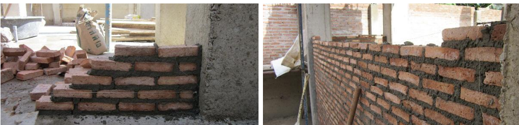
ซึ่งแนวยึดตะปูเอ็นด้วยค้อนและก่อให้ไต่ระดับ งานก่อผนังอิฐมอญห้องน้ำ ระหว่างก่อ
