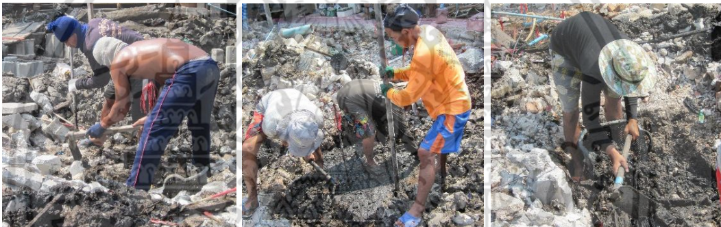
ใช้จอบขุดหลุม และเก็บเศษดินและคอนกรีตรอบๆ หลุมออก
