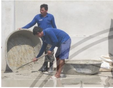
ยกกะบะเทคอนกรีต ใช้จอบเกลี่ยคอนกรีตลงบนพื้นที่ที่กั้นแบบไว้ ใช้เกรียงปาดปริมาณคอนกรีตให้ระดับเสมอกัน แล้วจึงใช้สามเหลี่ยมปาดฉาบผิวคอนกรีตอีกครั้ง
