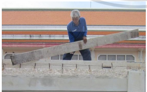
วางไม้แบบข้างด้านนอก วัดและตัดไม้แบบตามขนาดช่วงเสา
