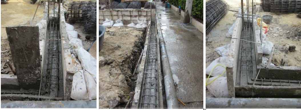
หลังจากเทคอนกรีตลงในแบบหล่อคานพื้นแล้ว
