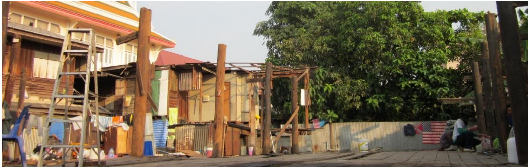
หลังหรือโครงสร้างหลังคาทั้งหมดลงจากหัวเสาเรียบร้อยแล้ว พร้อมทำความสะอาดพื้นแล้ว
