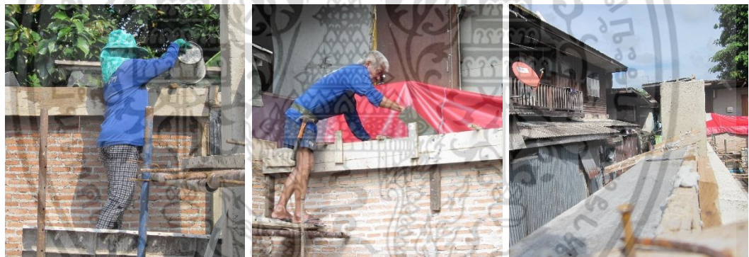
เทคอนกรีตลงในแบบหล่อทับหลัง ใช้เกรียงปาดฉาบระดับให้เรียบได้ระดับเสมอกัน
