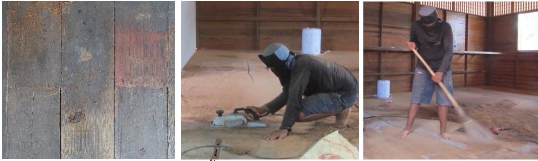
ใช้กบไฟฟ้าไสปรับระดับและผิวไม้พื้นให้เรียบเสมอกัน กวาดเศษไม้ด้วยไม้กวาดทางมะพร้าว
