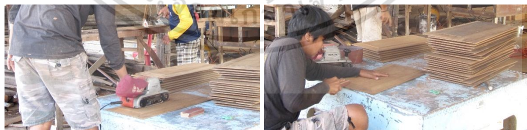
นำลูกฟักไม้ที่ถอดออกมาแล้วมาขัดผิวด้วยเครื่องขัดผิวไม้ไฟฟ้าและกระดาษทราย
