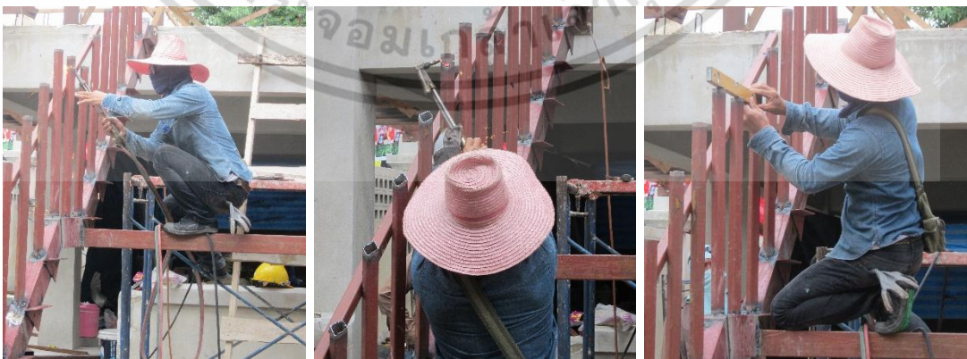
ตัดราวกันตกตามแนวที่ขีดไว้ด้วยแก๊สตัดเหล็ก ตรวจสอบให้ได้ฉากก่อนเชื่อมยึดกับราวจับ
