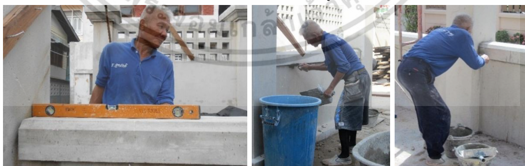
ตรวจสอบระดับหลังบัวใช้ปลายค้อนเคาะด้านบนและด้านข้างให้ได้ฉากและได้ระดับตามแบบ
