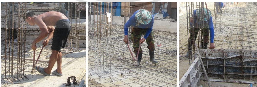
ตัดตะแกรงเหล็กเสริมที่ยื่นพื้นเหล็กท่อกลมออก ตัดตะแกรงเหล็กเสริมชั้น 2
