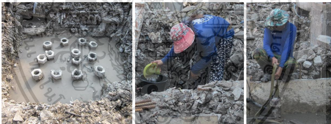
หลุมฐานรากหลังจากตัดหัวเสาเข็ม ใช้ขันตักน้ำที่มีอยู่ในหลุม(น้อย) ใช้ปั๊มไฟฟ้าดูดน้ำออก(มาก)
