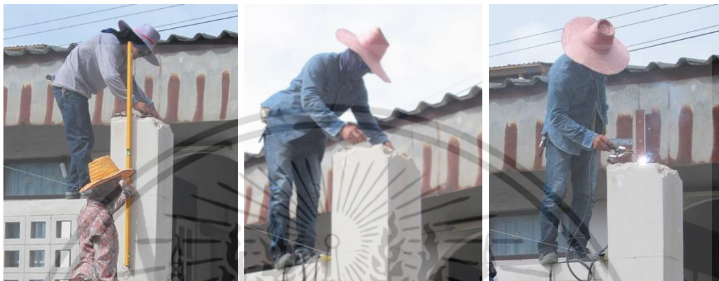
ใช้ระดับน้ำวัดตั้งของเสาคสล. และแป้นเพลทเหล็ก ใช้ซออล์กซีตระยะแล้วเชื่อมยึดกับเพลทเหล็ก
