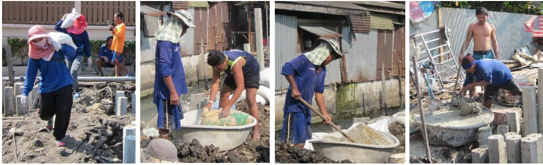
แบกกระสอบซีเมนต์ หินและทรายเข้ามาเพื่อผสมคอนกรีตในกระบะ อัตราส่วนเท่ากับ 1:2:3
