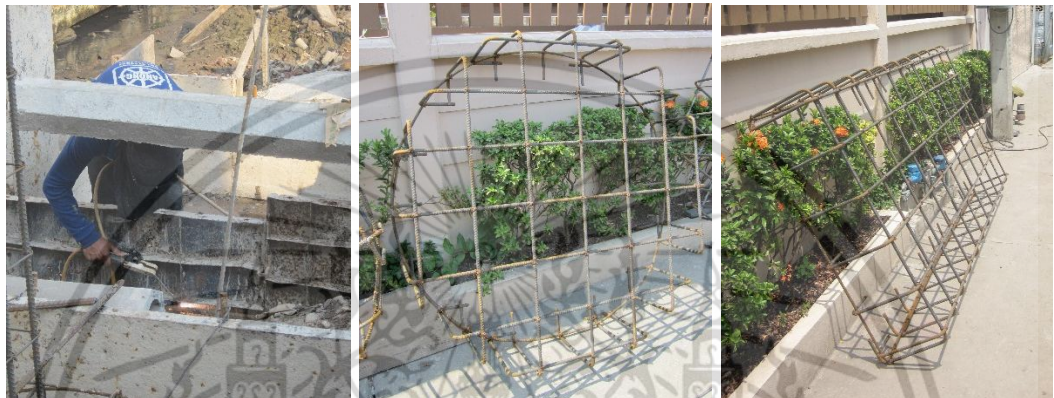
เชื่อมแบบเหล็กหล่อให้ติดกับหมุดเหล็ก เหล็กเสริมฐานรากที่ผูกสำเร็จแล้วมาจากโรงงาน
