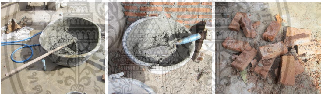
ใช้จอบผสมซีเมนต์กับทรายและน้ำในกะบะผสม ตักใส่ถังสำหรับก่อผนังอิฐมอญห้องน้ำ
