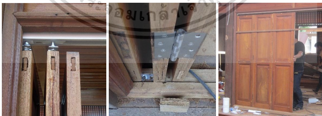
ใช้สว่านไฟฟ้าไขสกรูยึดบานพับเข้ากับประตูบานเฟี้ยมและเพลทียึดบานประตูเริ่มต้น
