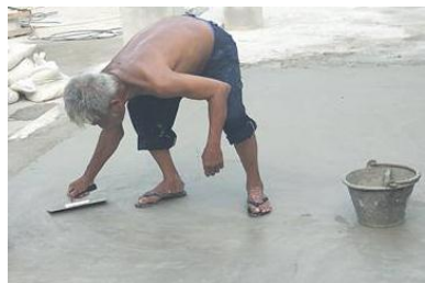
รอให้คอนกรีตแข็งตัว ใช้เกรียงเหล็กขัดที่ผิวพื้นให้ทั่วพื้นที่ เสร็จแล้วจึงถอดแบบข้างออก เอกสารนี้เป็นเอกสารที่สงวนไว้สำหรับการใช้งานเพื่อการศึกษาเท่านั้น เมื่อนุญตเห็นาไปใช้ประโยชน์ด้านการค้าไม่ว่ากรณีใดๆ ทั้งสิ้น อีกทั้งห้ามมิให้ตัดแปลงเนื้อหา และต้องอ้างอิงถึงเจ้าของเอกสารทุกครั้งที่มีการนำไปใช้
