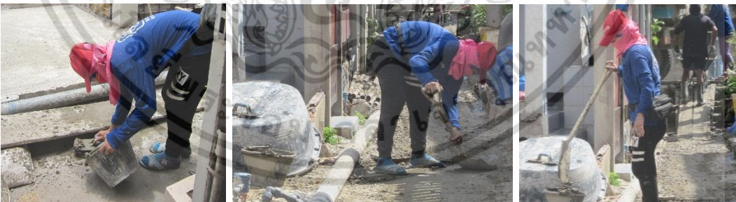
ใช้เกรียงและพลั่วตักเศษคอนกรีตที่ตกตามพื้นใส่ถังเพื่อทำความสะอาดพื้นที่
