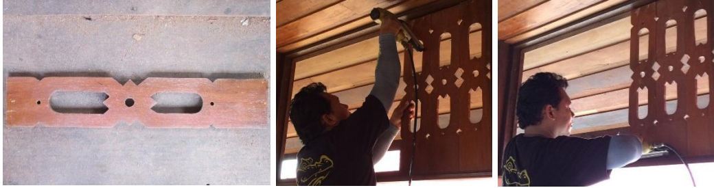
ยึดไม้ช่องแสงฉลุลายกับังกบด้วยปืนยิงตะปูลมให้แน่น
