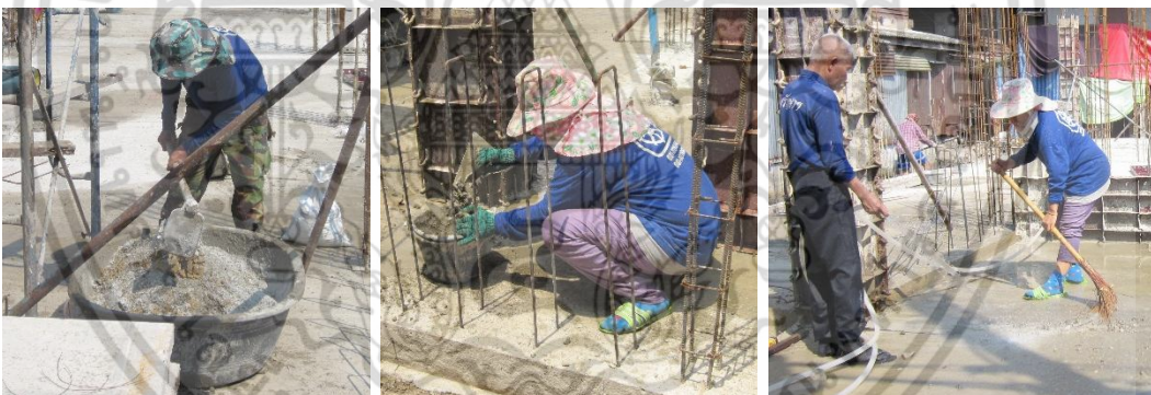
ผสมคอนกรีตลงในกะบะผสมสำหรับเติมในกรณีคอนกรีตจากรถผสมสำเร็จไม่เพียงพอ และทำความสะอาดเศษคอนกรีตในพื้นที่โดยรอบให้เรียบร้อย
