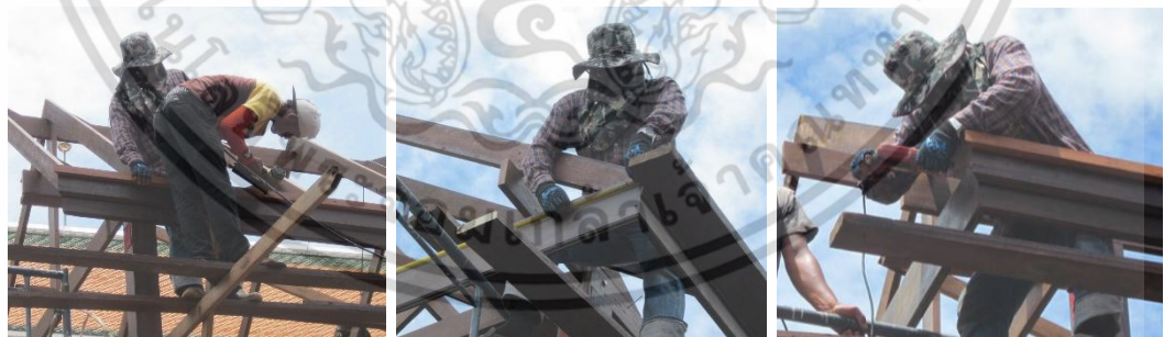
ใช้เครื่องยิงตะปูลมยึดไม้ปิดได้ลอน วัดระยะก่อนตัดส่วนที่เกินออก และใช้สว่านไฟฟ้ายึดสกรูให้แน่น
