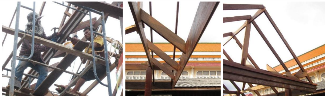
ใช้เครื่องยิงตะปูลมยึดไม้ปิดได้ลอน วัดระยะก่อนตัดส่วนที่เกินออก และใช้สว่านไฟฟ้ายึดสกรูให้แน่น
