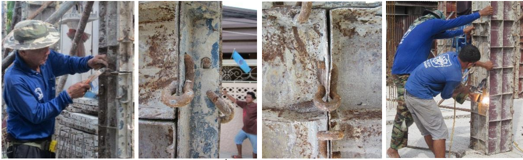
ใช้ค้อนหงอนตอกยึดสลัก และเชื่อมยึดแบบเหล็กหล่อคอนกรีตสำหรับหล่อเสา
