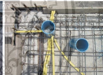
เหล็กเสริมพื้น คสล. บริเวณห้องน้ำ และตำแหน่งท่อระบายน้ำบริเวณชานกลางบ้าน
