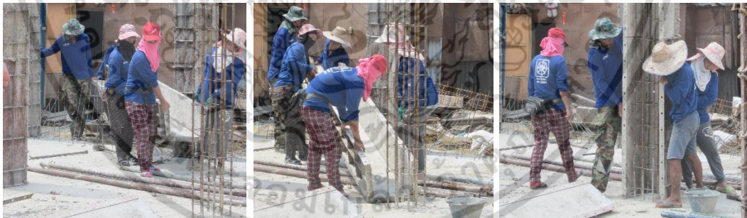
ยกประกอบแบบเหล็กหล่อสำหรับหล่อเสาและยกมาเข้าแบบตามระยะและตำแหน่งเหล็กเสริม
