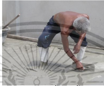
ยกกะบะเทคอนกรีต ใช้จอบเกลี่ยคอนกรีตลงบนพื้นที่ที่กั้นแบบไว้ ใช้เกรียงปาดปริมาณคอนกรีตให้ระดับเสมอกัน แล้วจึงใช้สามเหลี่ยมปาดฉาบผิวคอนกรีตอีกครั้ง
