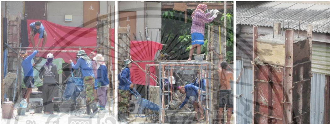
เทคอนกรีตจากรถเข็นลงกะบะใส่คอนกรีต แล้วใช้ถังตักก่อนส่งขึ้นไปเทยังด้านบนของแบบหล่อเสา
