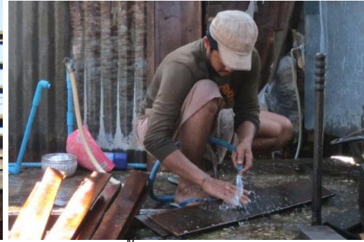
จัดโครงคร่าว์ออกจากแผ่นไม้ฝ้าด้วยชะแลง และฉีดน้ำล้างไม้ฝ้าให้สะอาด
