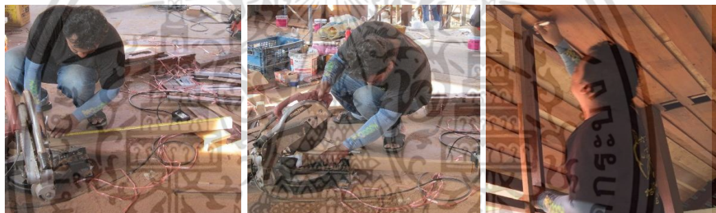
วัดระยะไม้ซอวยวงกบ ตัดด้วยแท่นตัดไฟเบอร์ แล้วทำสัญลักษณ์บากที่วงกบช่องแสง
