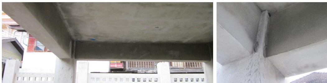
คานด้านในและท้องพื้นด้านในอาคารที่ฉาบผิวเสร็จแล้ว
