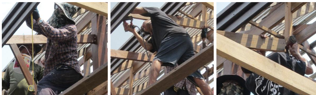
ใช้เครื่องยิงตะปูลมยึดจันทันกับไม้ปิดแนวและแป้นไม้รับจันทัน
