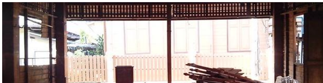
ผนังด้านติดทางเดินที่รื้อฝาผนังไม้ออกแล้ว
