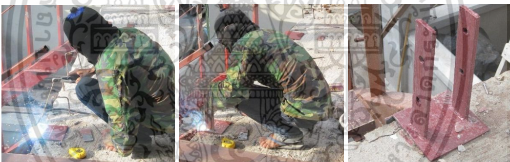
วัตถุประสงค์ระหว่างเสาก่อนเชื่อมยึดแป้นรับและเพลาเหล็กยึดเสาไม้ซุ้มทางเข้าพร้อมทาสีกันสนิม
