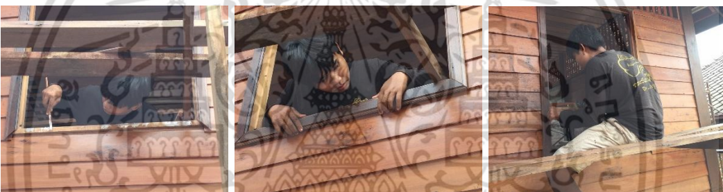
หากาวที่วงกบหน้าต่างก่อนยึดไม้ขอบวงกบด้วยปืนยิงตะปูลมให้แน่นอีกครั้ง
