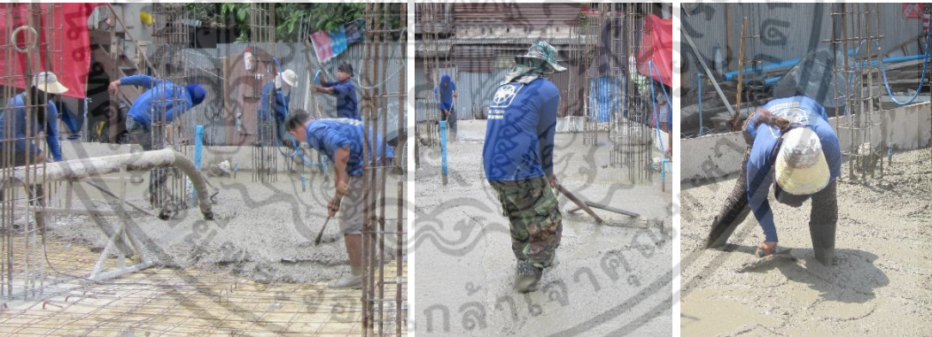
เทคอนกรีตและใช้จอบและไม้ปาดเกลี่ยปริมาณคอนกรีตให้กระจายตัวสม่ำเสมอและทั่วพื้นที่
