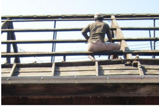
จัดโครงคร่าว์ออกจากแผ่นไม้ฝ้าด้วยชะแลง และฉีดน้ำล้างไม้ฝ้าให้สะอาด
