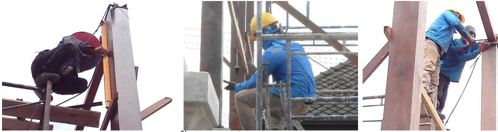
ตรวจสอบตั้งเสาโดยใช้ระดับน้ำและลูกตั้ง วัดระยะห่างของเสา และยึดแคลมป์ล็อกให้แน่น
