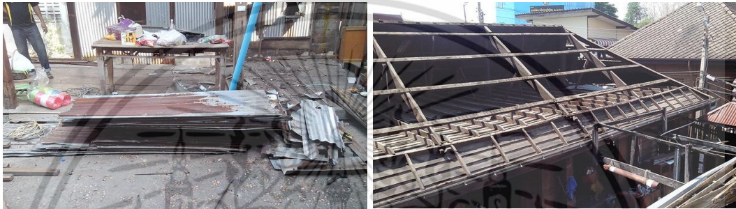
รื้อแผ่นสังกะสีจนครบด้านหนึ่งแล้วจึงรื้อด้านที่เหลือต่อไปจนหมด
