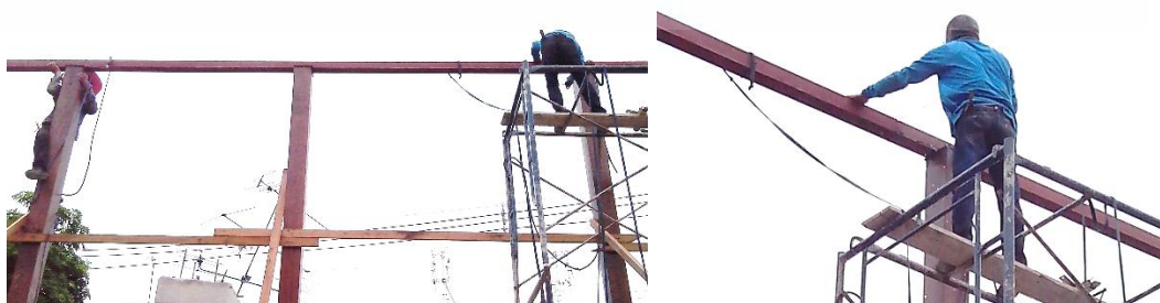
จัดวางระยะให้ได้ตามกำหนด เชื่อมยึดกับเหล็กกล่องอะเสที่ได้ติดตั้งไว้ก่อนหน้านี้แล้ว
