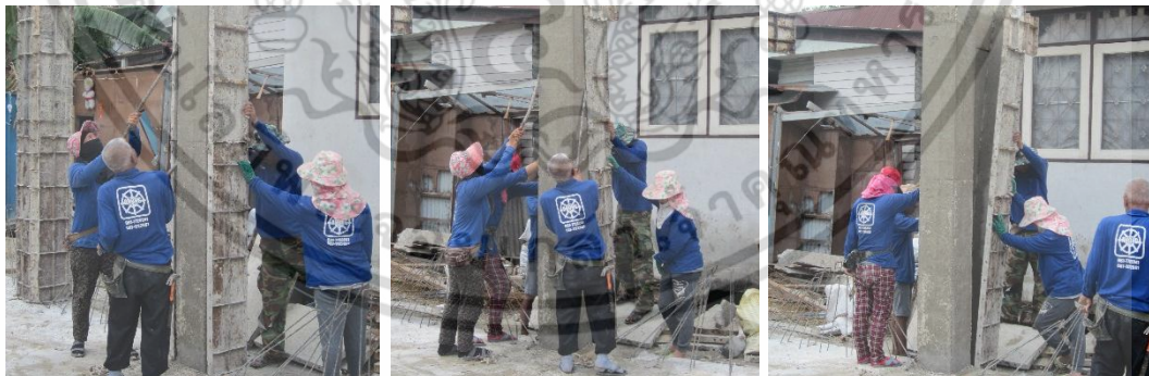
ใช้ชะแลงจัดแบบหล่อด้านข้างให้หลุดออก ถอดสลักยึดแบบ และใช้แก๊สตัดเหล็กที่เชื่อมแบบหล่อออก
