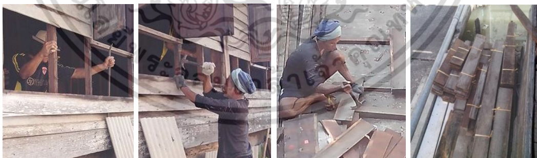
ใช้ชะแลงจัดฝาผนังไม้ภายในให้ตะปูหลุดจากคร่า แยกไม้และถอนตะปูออก มัดด้วยเชือกขนย้าย
