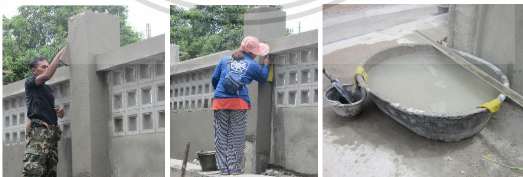
ใช้ฟองน้ำเช็ดถูที่ผิวปูนฉาบเพื่อทำความสะอาดอีกครั้ง แล้วล้างอุปกรณ์ที่ใช้เสร็จแล้วให้สะอาด
