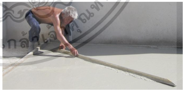
ใช้สายยางฉีดน้ำลงบนพื้นที่โรยผงซีเมนต์แล้วใช้สามเหลี่ยมปาดฉาบผิวพื้นให้เรียบเสมอกันอีกครั้ง
