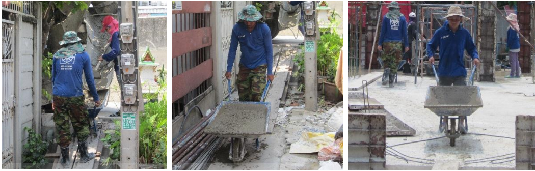
เทคอนกรีตจากรถผสมคอนกรีตสำเร็จใส่รถเข็นแล้วเข็นเข้าไปยังบริเวณที่จะเทเสา
