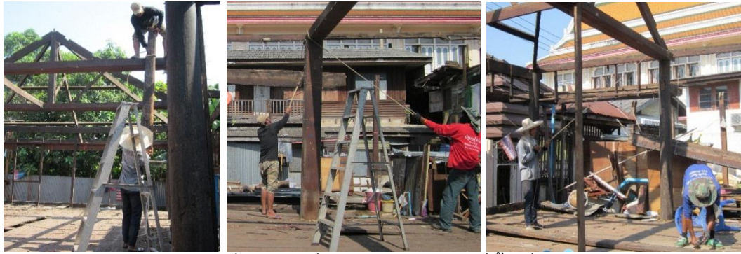
ผูกเชือกกับเชิงชายเพื่อพาดกับชื่อก่อนหย่อนเชือกลงที่พื้นเพื่อเอาเชิงชายลงมา
