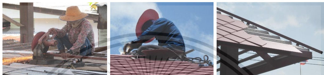
วัดระยะและตัดเหล็กตะเข้เส้นด้วยเลื่อยไฟฟ้า ก่อนยึดเหล็กตะเข้เส้นด้วยรูปเชื่อมและเครื่องเชื่อมไฟฟ้า
