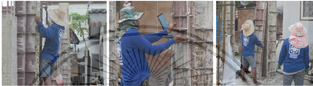
ใช้ค้อนหงอนตอกสลักยึดแบบเหล็กหล่อออก
