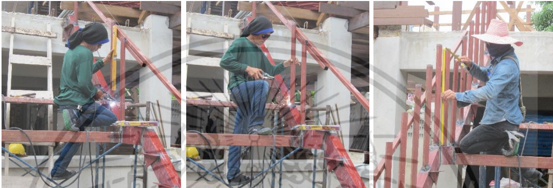
ใช้ระดับน้ำวัดให้ได้ฉากก่อนเชื่อมยึดราวกันตกกับแม่บันได ตรวจสอบความสูงด้วยตลับเมตรอีกครั้ง
