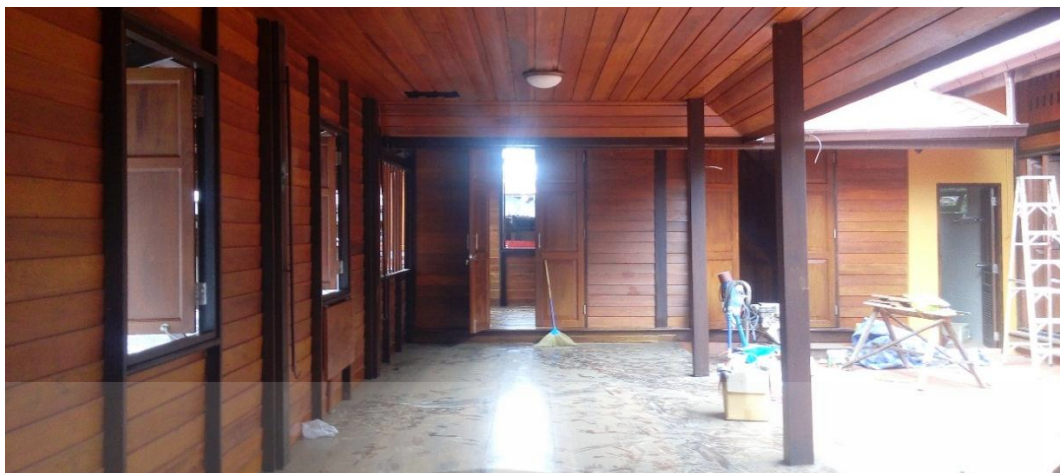
เก็บผิวและทำสีงานผนังไม้ต้นนอนซ้อนเกล็ดทั้งภายนอกและภายใน
