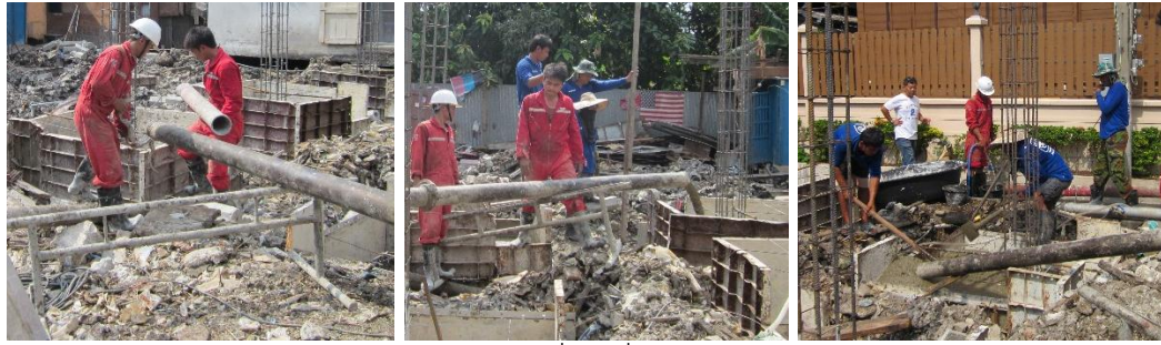
ตัดต่อท่อส่งคอนกรีตเมื่อเปลี่ยนไปเที่ยงหลุมต่างๆ
