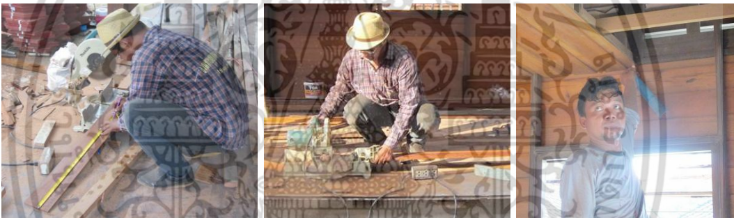
วัดความยาวแผ่นไม้ฝ้าด้วยตลับเมตร และตัดโดยใช้แท่นตัดไฟเบอร์ ดีเต้ากำหนดแนวยึดแผ่นไม้ฝ้า
