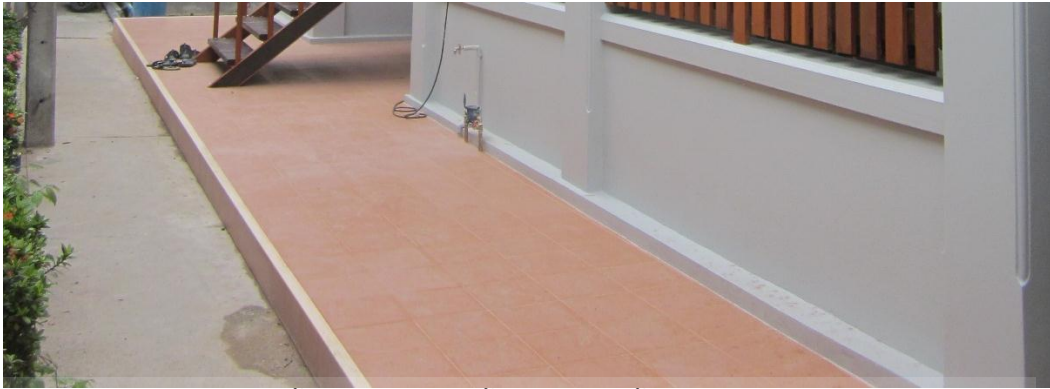
พื้นทางเข้าอาคารชั้น1 ที่ปูกระเบื้องเสร็จแล้ว
