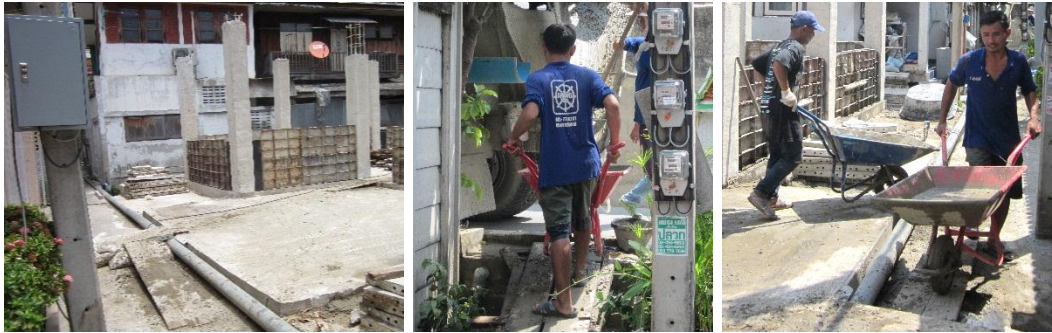
เทคอนกรีตจากรถผสมคอนกรีตสำเร็จใส่รถเข็นแล้วเข็นเข้าไปยังบริเวณที่จะเทผนัง
