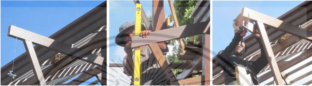
ใช้สายเอ็นซึ่งตั้งแนวตัดบริเวณปลายจันทัน ใช้ระดับน้ำวัดให้ได้ดิ่งและใช้เลื่อยวงเดือนตัดส่วนเกินออก
