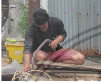
ตัดไม้ปลายไม้ด้วยเลื่อยคันทันธู ถอนตะปูออก แล้วมัดคองไม้รวมรวมด้วยเชือก
