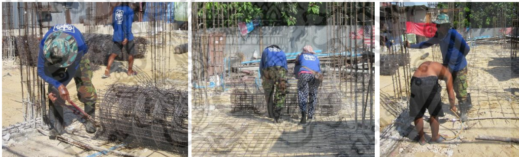
ใช้กรรไกรตัดเหล็กเสริมตัดลวดยึดตะแกรงเหล็กเสริมออก ม้วนคลี่ตะแกรงเหล็กเสริมยาวตลอดแนว และเชื่อมยึดแนวกับเหล็กท่อกลมไว้กับพื้น
