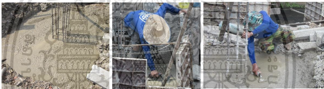
ผิวคอนกรีตฐานรากที่ปรับระดับแล้ว ใช้เกรียงปาดฉาบผิวให้เรียบสม่ำเสมอ
