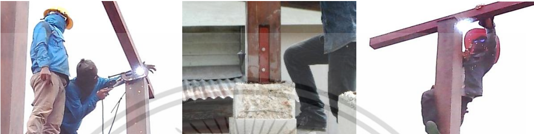
เชื่อมยึดอะเสกับเพลาเหล็กบนหัวเสา ตรวจสอบตั้งของเสาต้นถัดไปก่อนเชื่อมยึดอะเสกับหัวเสา
