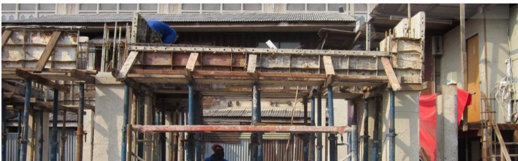
ติดตั้งแบบหล่อคาน คสล. เรียบร้อยรอเทคอนกรีตต่อไป
