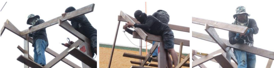
ใช้สว่านยึดสกรูไม้จันทันกับไม้สามเหลี่ยมที่ตั้งไว้แล้ว ซึ่งสายเอ็นเพื่อระบุแนวตัดบริเวณปลายจันทัน เอกสารนี้เป็นเอกสารวิเทศสงวนลิขสิทธิ์ไว้บริการเชิงนิเทศเพื่อการศึกษาเท่านั้น เมื่อนำไปเผยแพร่ในสื่อออนไลน์ หรือทำซ้ำไม่ว่ากรณีใดๆ ทั้งสิ้น อีกทั้งห้ามมิให้ตัดแปลงเนื้อหา และต้องอ้างอิงถึงเจ้าของเอกสารทุกครั้งที่มีการนำไปใช้
