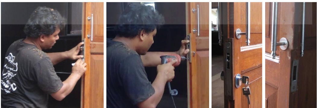
ระบุดูเจาะยึดลูกบิดประตูด้วยปากกา ใช้ส่วนไฟฟ้าขันสกรูยึดให้แน่น
