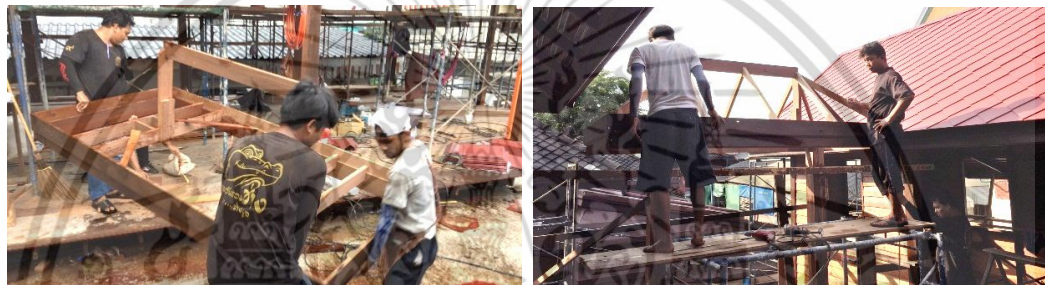
ยกโครงสร้างหลังคาไม้ขึ้นไปติดตั้งบนหัวเสาไม้ พร้อมยึดสกรูด้วยสว่านไฟฟ้า
