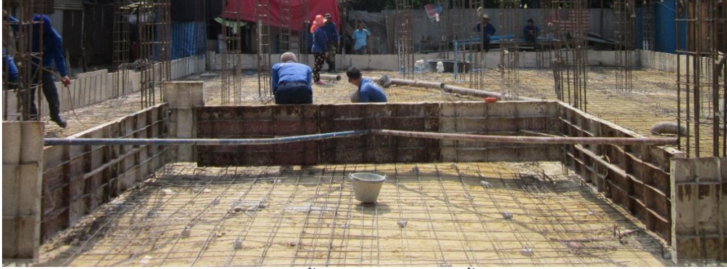
เชื่อมยึดเหล็กค้ำกับแบบเหล็กหล่อพื้น คสล.
