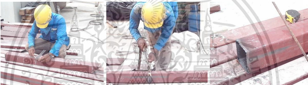
วัดระยะเสาเหล็กเสริมบนคานหลังคา คสล. ใช้แก๊สตัดเหล็กให้ขาดออกจากกัน
