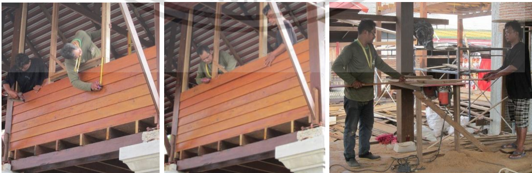
ใช้ลับเมตรวัดระยะบากไม้ฝาขึ้นขอบใต้วงกบ ชีตระยะตัด และใช้โต๊ะเลื่อยวงเดือนตัดบากออก
