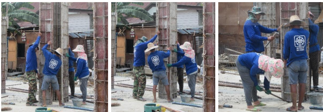
ยกประกอบแบบเหล็กหล่อสำหรับหล่อเสาและยกมาเข้าแบบตามระยะและตำแหน่งเหล็กเสริม
