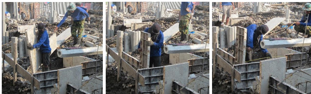
นำแบบเหล็กหล่อมาเข้าแบบตามขนาดที่กำหนด โดยทำการวัดระยะด้วยตลับเมตรก่อนยึดแบบต่อไป
