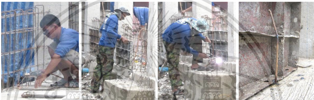
เชื่อมเหล็กเสริมที่บริเวณฐานด้านล่างของเหล็กเสริมเพื่อใช้ยึดแบบเหล็กหล่อให้อยู่ในแนวที่กำหนดไว้
