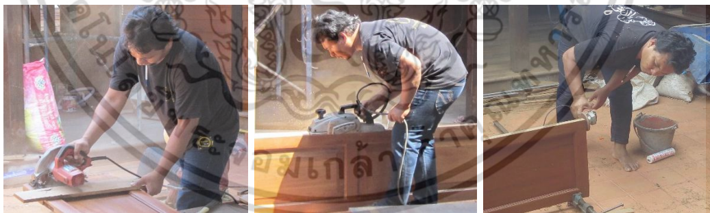
วัดระยะความสูงบานหน้าต่างเทียบกับวงกบ ใช้เลื่อยวงเดือนตัดบานส่วนที่เกินออก ใช้กบไฟฟ้าไสไม้ปรับให้ได้ระยะ และใช้เครื่องเจียรไฟฟ้าขัดให้เรียบอีกครั้ง
