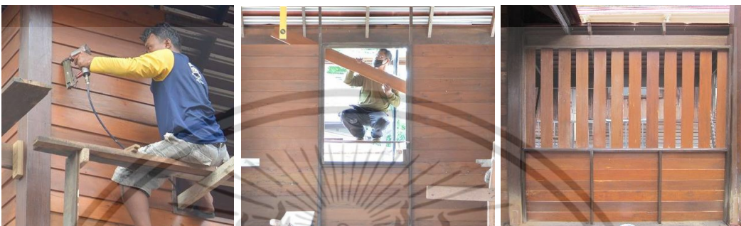
ยึดกับโครงและไม้ฝาแผ่นอื่นๆ ขึ้นไปเรื่อยๆจนเต็มแนวผนัง ทั้งผนังทึบและผนังไม้ระแนงเว้นร่อง
