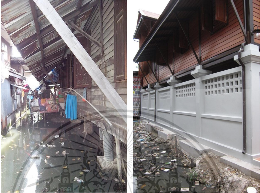
บริเวณคลองระบายน้ำด้านซ้ายของอาคารก่อนและหลังซ่อมแซม
