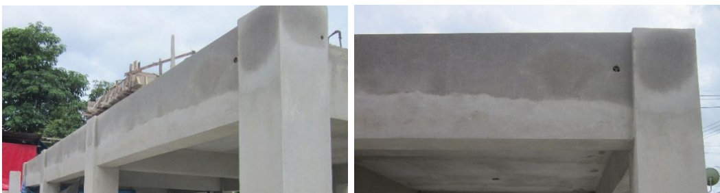
คานด้านนอกและขอบพื้นชานชั้น 2 ที่ฉาบผิวเสร็จแล้ว
