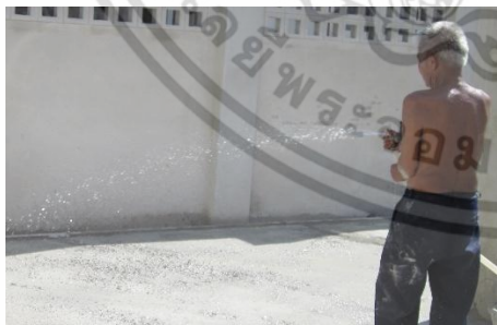
ใช้สายยางฉีดน้ำลงบนพื้นที่โรยผงซีเมนต์แล้วใช้สามเหลี่ยมปาดฉาบผิวพื้นให้เรียบเสมอกันอีกครั้ง
