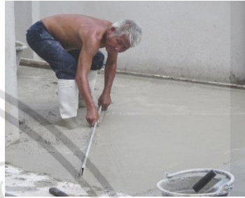
ยกกะบะเทคอนกรีต ใช้จอบเกลี่ยคอนกรีตลงบนพื้นที่ที่กั้นแบบไว้ ใช้เกรียงปาดปริมาณคอนกรีตให้ระดับเสมอกัน แล้วจึงใช้สามเหลี่ยมปาดฉาบผิวคอนกรีตอีกครั้ง
