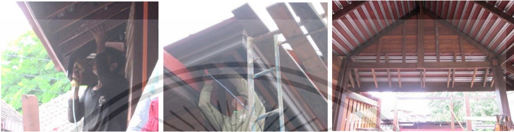
ใช้ปืนยิงตะปูลมยึดโครงไม้ไผ่ค้ำยันคานโดยรอบ
