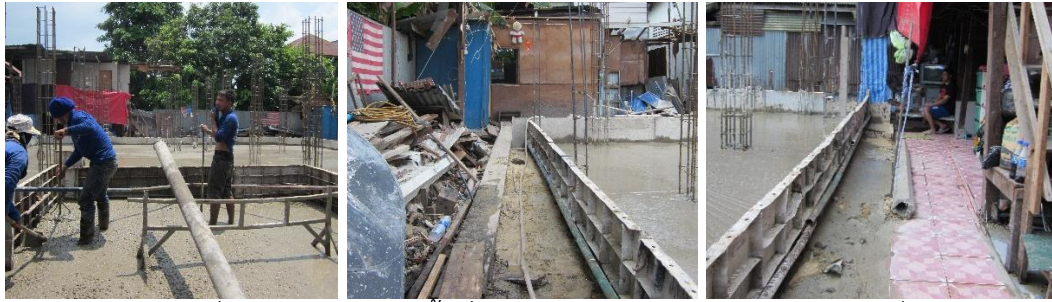
เทคอนกรีตจนทั่วและถึงยังบริเวณพื้นที่ด้านนอกสุดพร้อมปรับระดับให้เรียบสม่ำเสมอ และตรวจสอบการรั่วไหลของคอนกรีตที่มีต่อแบบหล่อพื้นโดยรอบ
