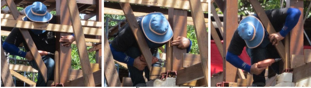
ใช้สว่านไฟฟ้ายึดสกรูแป้นไม้รับค้ำยัน และยึดไม้ค้ำยันเข้ากับแป้นที่ยึดไว้แล้ว
