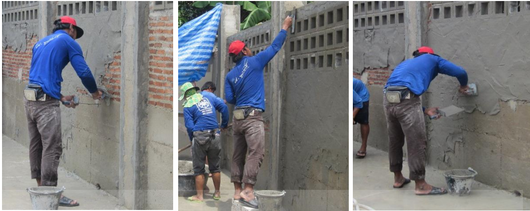
ใช้เกรียงตักปูนจากกระบะถือปูนปาดลงที่บริเวณผนัง โดยไล่ฉาบจากบริเวณด้านบนลงสู่ด้านล่าง
