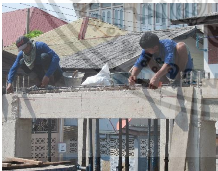
ตีเต้าเพื่อกำหนดแนวในการยึดแบบหล่อพื้น คสล. ด้านข้าง ใช้ค้อนตอกตะปูยึดแบบด้านข้างโดยรอบ
