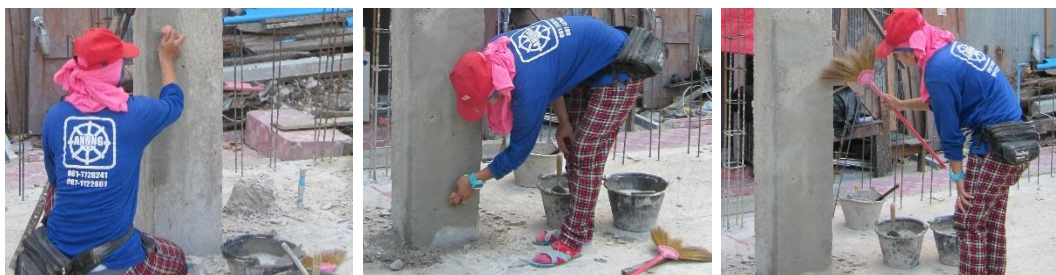
ใช้ชะแลงจัดแบบหล่อด้านข้างให้หลุดออก ถอดสลักยึดแบบ และใช้แก๊สตัดเหล็กที่เชื่อมแบบหล่อออก
