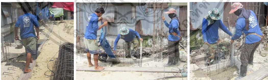
เทคอนกรีตจากรถเข็นลงสู่แนวผนังกันดิน และใช้เครื่องสั่นคอนกรีตจี้ให้คอนกรีตกระจายตัว
