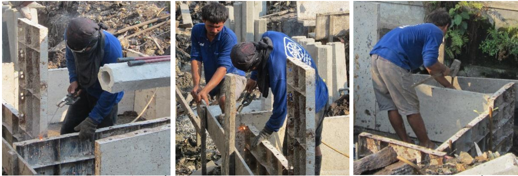
เชื่อมแบบเหล็กหล่อให้ติดกันทั้งบริเวณเข้ามุม และด้านหลังแบบ ตอกหมุดเหล็กยึดและค้ำแบบ
