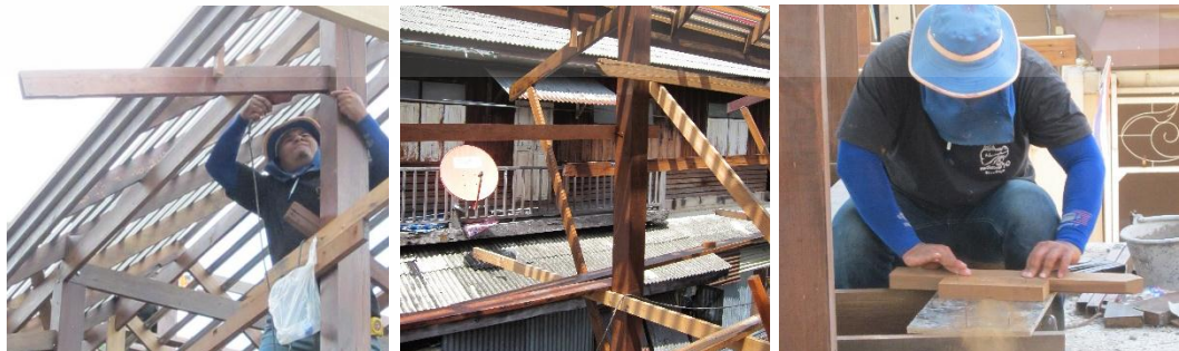
ใช้สว่านยึดสกรูไม้ชายคาอัดทะแยงบริเวณเดือยที่เสียบไว้แล้ว วัดขนาดแป้นไม้รับค้ำยัน
