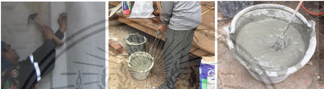
ยึดแนวสายเอ็นเพื่อกำหนดแนวปูกระเบื้องผนัง ผสมปูนขาว และน้ำให้เข้ากันด้วยสว่านดอกปั่นปูน
