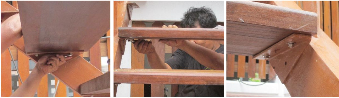
ใช้ประแจปากตายขันยึดน็อตกับสลักเหล็กให้แน่น
