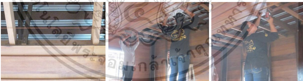
หลังจากกำหนดดีเต้าแล้ว ใช้ปืนยิงตะปูลมยึดแผ่นไม้ฝ้ากับโครงคานโดยแผ่นยึดหน้า 2” ก่อนหน้า 4” ซ้อนทับ โดยเริ่มจากไม้ตรงกลางก่อนไล่ไปจนสุดขอบของทั้งสองฝั่ง
