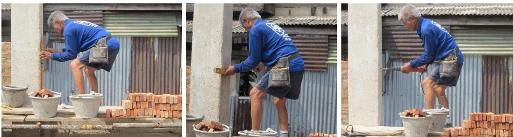
ใช้ระดับน้ำวัดระดับและระยะตำแหน่งที่จะเจาะรูฝังเหล็กหมวดกึ่ง
