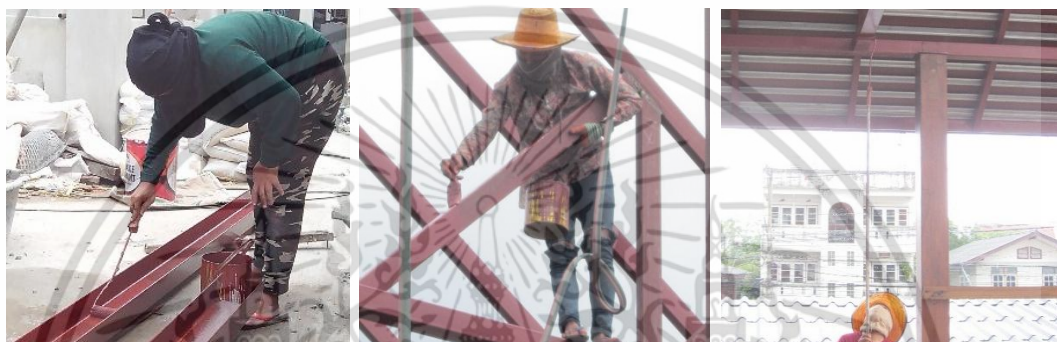
เชื่อมเก็บรอยต่อโครงสร้างหลังคาทุกจุด ขัดเจียรบริเวณรอยต่อด้วยเครื่องเจียรไฟฟ้า พร้อมทาสีด้วยแปรงและลูกกลิ้งทับเหล็กโครงสร้างและจุดต่อทุกจุด
