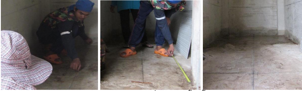
วัดระยะและตีเต้าบอกแนวที่จะปูกระเบื้องพื้นและผนัง
