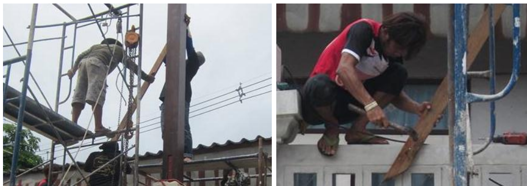
ใช้ค้อนหงอนตอกตะปูยึดไม้ค้ำเข้ากับเสาไม้และผนังรื้ออาคารเพื่อค้ำไม่ให้เสาล้มลง
