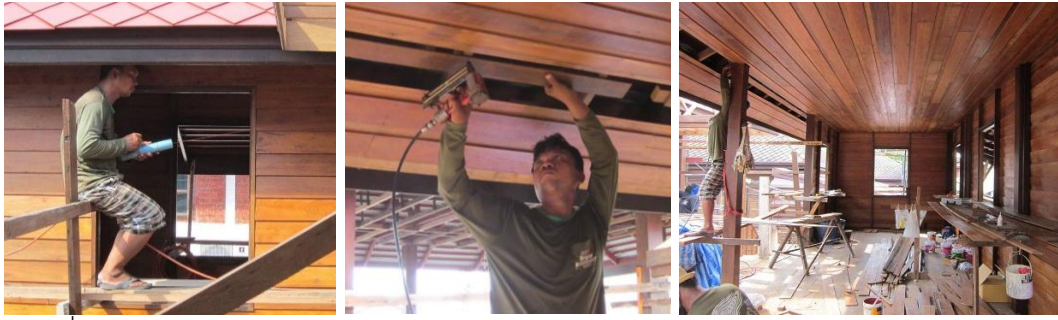
ตีเต้าเพื่อทำแนวยึดแผ่นไม้ฝ้ากับโครงไม้ฝ้าโดยใช้ปืนยิงตะปูลมยึดแผ่นไม้ฝ้ากับโครงไม้ฝ้าโดยใช้โครงไม้ฝ้าตีเต้า
