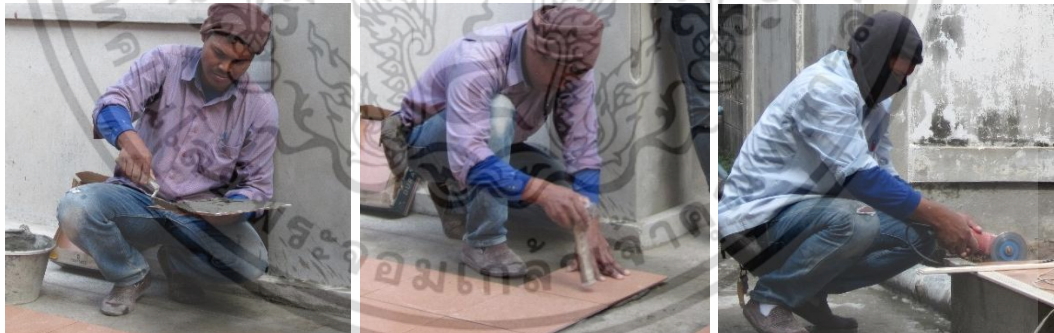
ใช้เกรียงก่อตัดปูนกาวที่ผสมแล้วลงบนแผ่นกระเบื้อง วางแผ่นลงบนพื้นแล้วใช้ด้ามค้อนเคาะให้ปูนกาวยึดแน่น วัดระยะและตีเต้าก่อนใช้เครื่องเจียรไฟฟ้าตัดแนวคอนกรีตที่เกินระยะออก
