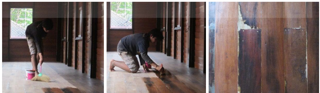
ใช้ไม้กวาดดอกหญ้ากวาดเศษฝุ่นออก ใช้แปรงจุ่มสีย้อมไม้แล้วทาลงบนพื้นไม้ก่อนทาเคลือบเงาอีกครั้ง
