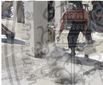
รอให้คอนกรีตแข็งตัวประมาณ 10 นาที ตักซีเมนต์ผงใส่ถัง ใช้มือจับโรยและเทผงซีเมนต์ลงบนพื้นคอนกรีตให้ทั่วพื้นที่ที่จะทำการขัดมัน
