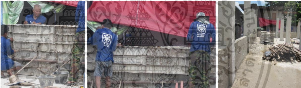
ใช้ค้อนปอนด์ตอกสลักยึดแบบเหล็กหล่อออก และยกแบบเหล็กหล่อออกจากผนัง
