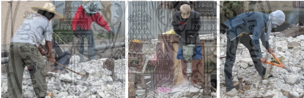
ทุบคอนกรีตด้วยค้อนปอนด์ และเครื่องสกัดไฟฟ้า ตัดเหล็กเสริมด้วยกรรไกรตัดเหล็ก
