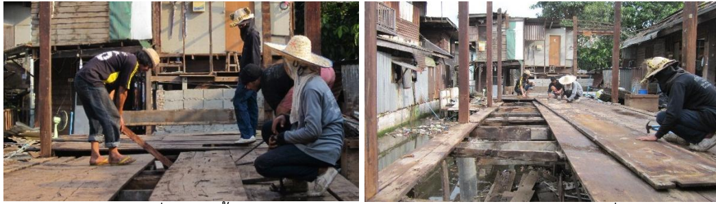
ใช้ไม้ท่อนยาวจัดช่วยเพื่อให้จัดพื้นด้วยชะแลง พลิกแผ่นไม้กลับด้านวางลงบนตงไม้เพื่อถอนตะปูออก
