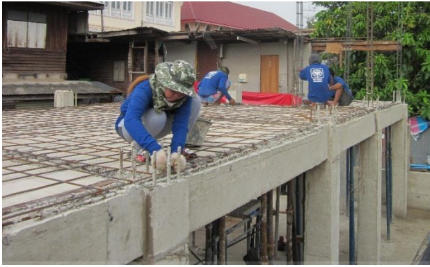
ใช้คีมผูกมัดยึดเหล็กเสริมเข้าด้วยกัน รองระยะใต้เหล็กเสริมด้วยลูกปูน
