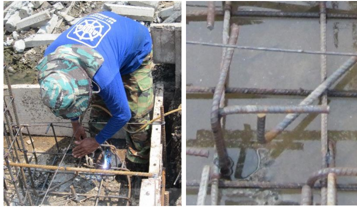
เชื่อมเหล็กยึดหัวเสา (Dowel) เข้ากับหัวเสาเข็มฐานราก
