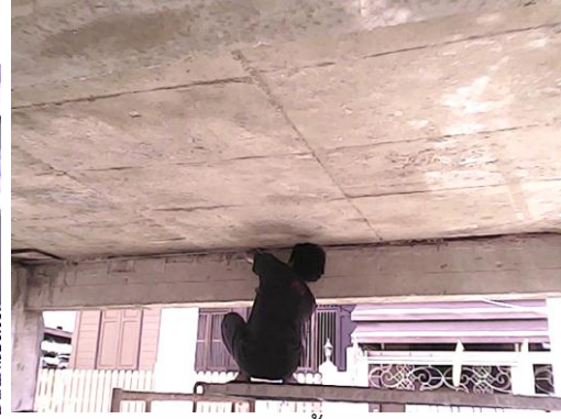
ตั้งนั่งร้านแล้วใช้ชะแลงจัดแบบเหล็กหล่อและไม้แบบล่างพื้นออก
