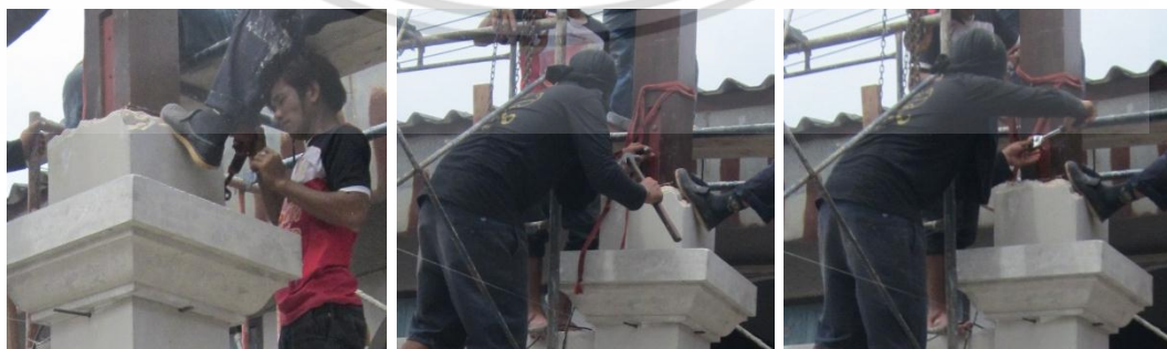
ใช้สว่านเจาะรูเสาไม้นำร่องก่อน ใช้ค้อนหงอนตอกสกรูเหล็กใส่ในรูแล้วใช้ประแจลูกบล็อกรอกโซ่ให้แน่น
