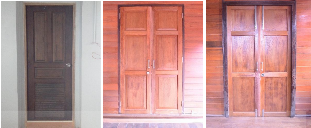
ประตูห้องน้ำชั้น1และ2 ประตูเข้าเรือนเก็บของภายนอกและภายใน
