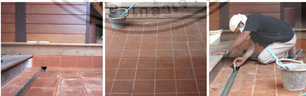
ใช้เกรียงตัดคอนกรีตลงร่องระบายน้ำเพื่อฉาบปรับระดับและเก็บผิวให้เรียบร้อย
