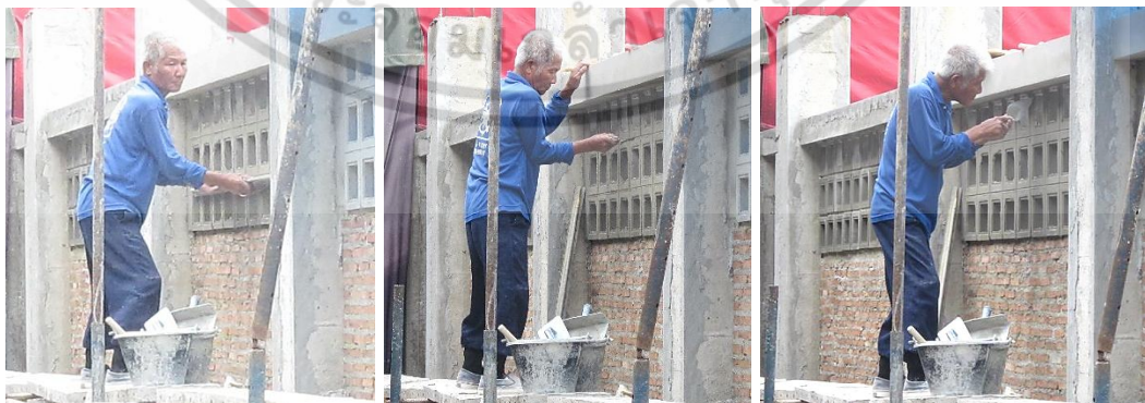
ใช้เกรียงปาดปูนฉาบผิวที่ผนังบริเวณบล็อกช่องลม ใช้สามเหลี่ยมปาดฉาบให้ระดับเสมอกัน ใช้เหล็กเส้น 6 มม. ชีตแนวเส้นซหาร่องระหว่างบล็อก แล้วปาดเก็บเศษปูนฉาบที่เข้าไปในร่องช่องลมออก
