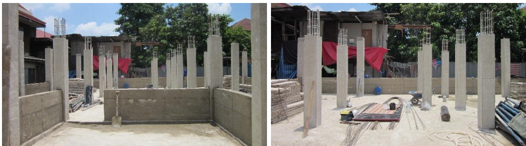
ผนังที่ถูกถอดแบบเหล็กหล่อออกแล้ว
