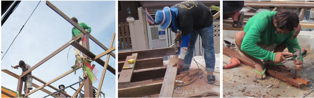
วัดระยะห่างหัวเสาและโคนเสาให้เท่ากัน ใช้ค้อนตอกตะปูยึดไม้ตงกับหัวเสาที่บากไว้ วัดตำแหน่งบากไม้เสาดั้ง ตัดไม้ด้วยเลื่อยวงเดือน และใช้ค้อนตอกลิ่มสกัดแต่งรอยบากให้ได้ขนาดความกว้างเท่าอกไก่
