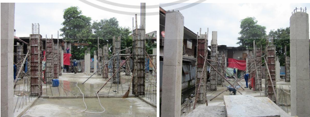
ทำความสะอาดเศษคอนกรีตในพื้นที่โดยรอบให้เรียบร้อย
