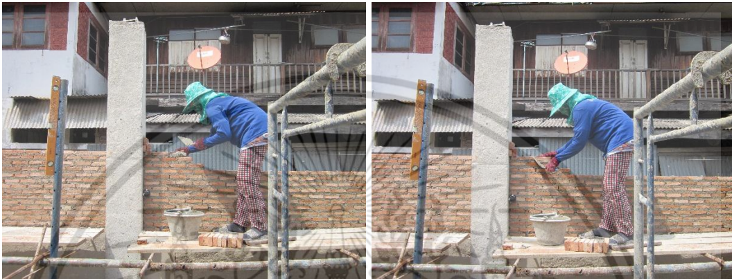
ใช้เกรียงก่อตักปูนก่อที่ผสมแล้วลงบนแนวที่จะก่อ วางอิฐมอดูลลง ปาดส่วนที่ล้นออกด้านข้างทั้งสอง
