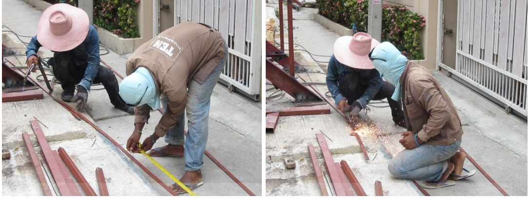
วัดความยาวของเหล็กแผ่นขนาด กว้าง 2” สำหรับทำราวจับด้วยตลับเมตร และตัดด้วยแก๊สตัดเหล็ก
