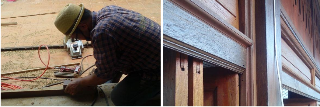
ใช้ราเวอร์เตอร์ทำลวดลายไม้บังราง ใช้กบบังไปไสขอบบนไม้บังรางให้ได้ระยะตามกำหนด และยึดไม้บังรางกับวงกบประตูให้แน่นด้วยปืนยิงตะปูลม
