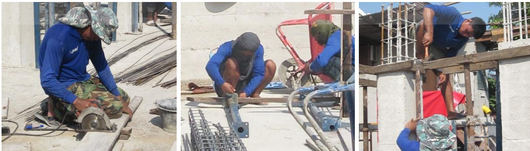
ใช้คีมผูกยึดลวดกับเหล็กเสริมระยะตามแบบ
