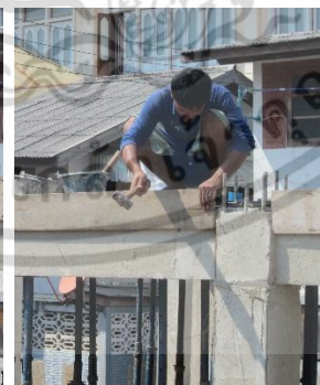
ตีเต้าเพื่อกำหนดแนวในการยึดแบบหล่อพื้น คสล. ด้านข้าง ใช้ค้อนตอกตะปูยึดแบบด้านข้างโดยรอบ
