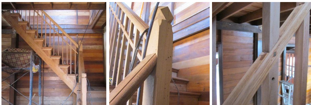
ยึดราวจับและราวกันตกไม้ด้วยปืนยิงตะปูลมให้แน่น
