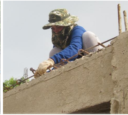
ใช้คีมผูกมัดยึดเหล็กเสริมเข้าด้วยกัน รองระยะใต้เหล็กเสริมด้วยลูกปูน
