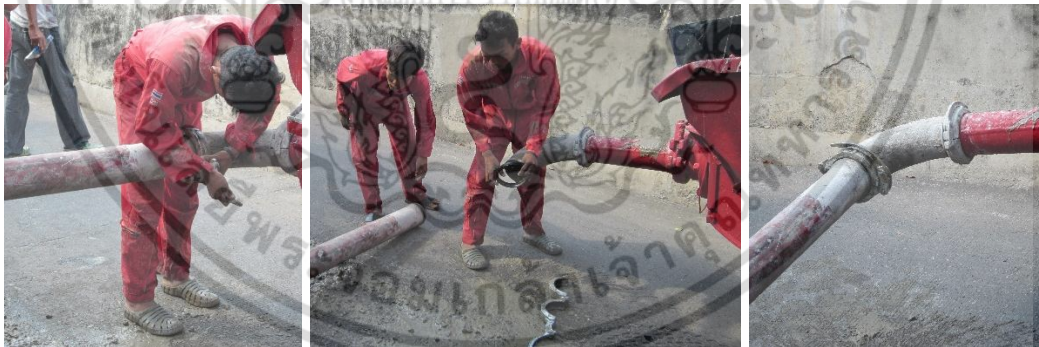
ต่อท่อกล้าวาไนซ์จากรถปั๊มเพื่อส่งคอนกรีตเข้าไปยังภายในพื้นที่ที่จะเทคอนกรีต
