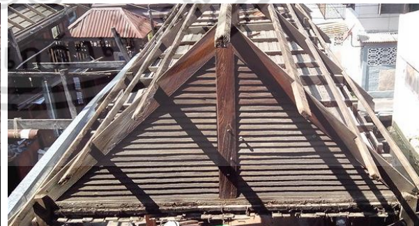
รื้อถอนโครงสร้างหลังคาพื้นที่เชื่อมต่ออาคาร และรื้อถอนแผ่นสังกะสี
