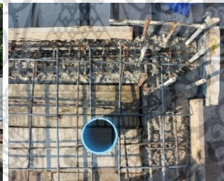
เหล็กเสริมพื้น คสล. บริเวณห้องน้ำ และตำแหน่งท่อระบายน้ำบริเวณชานกลางบ้าน
