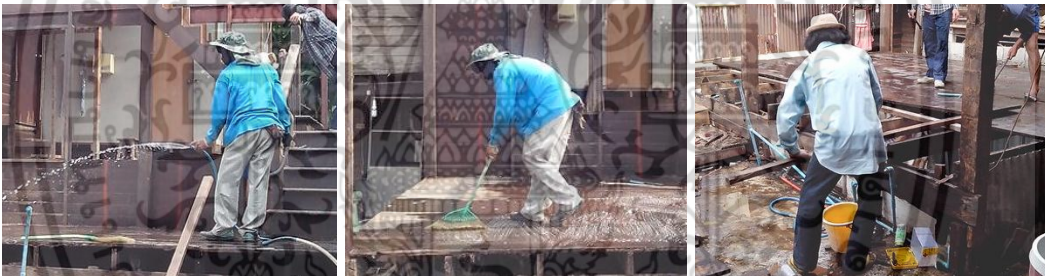
ฉีดน้ำบนพื้นไม้เพื่อลดฝุ่น กวาดฝุ่นและชั้นกออก จัดพื้นไม้ชั้น1 ออกด้วยชะแลงและไม้ท่อนยาว
