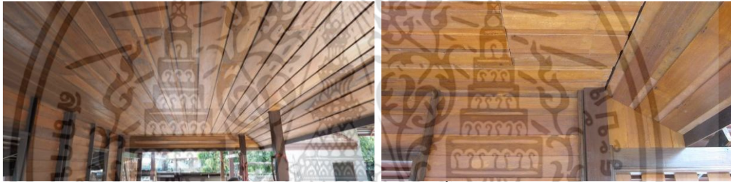
แผ่นไม้ฝ้าและช่องเซอร์วิสที่ติดตั้งเสร็จแล้ว
