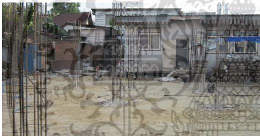
ปรับระดับดินและอัดทรายรองพื้น
