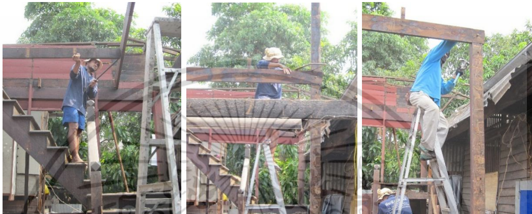
จัดคานและตงพื้นด้วยชะแลง ตัดเสาชั้น 2 ด้วยเลื่อยคันทัน ใช้ประแจเลื่อนไขคลายน็อตสลักยึด แล้วใช้ค้อนหงอนตอกย้อนเหล็กสลักเดือยออกจากไม้คานและเสา
