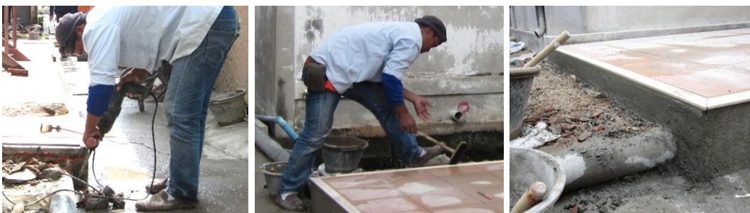
ใช้เกรียงก่อตัดปูนกาวที่ผสมแล้วลงบนแผ่นกระเบื้อง วางแผ่นลงบนพื้นแล้วใช้ด้ามค้อนเคาะให้ปูนกาวยึดแน่น วัดระยะและตีเต้าก่อนใช้เครื่องเจียรไฟฟ้าตัดแนวคอนกรีตที่เกินระยะออก
