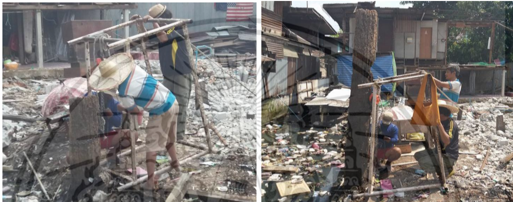
ใช้โซ่มัดเสาไม้อาคารเดิมไว้กับบรอกและโครงเหล็ก และใช้รอกดึงเสาไม้อาคารเดิมขึ้นจากหลุมดิน
