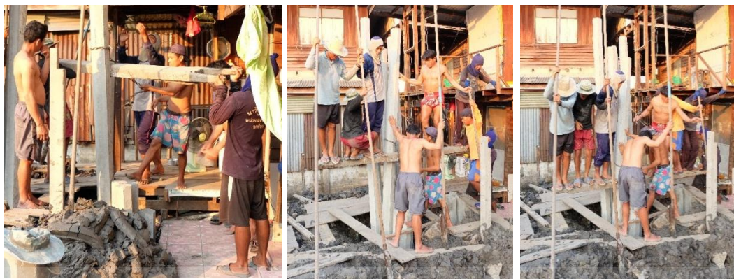
ใช้เสียมด้ามยาวค้ำพื้นแล้วกระโดดยกตัวขึ้นไปบนไม้ข่ม ให้สัญญาณก่อนจึงเริ่มข่มพร้อมกัน
