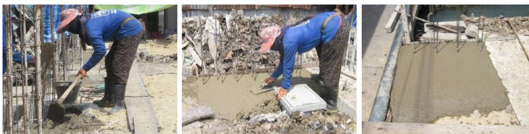
ใช้จอบเกลี่ยคอนกรีตให้ระดับสม่ำเสมอ และใช้เกรียงปาดฉาบผิวให้เรียบ
