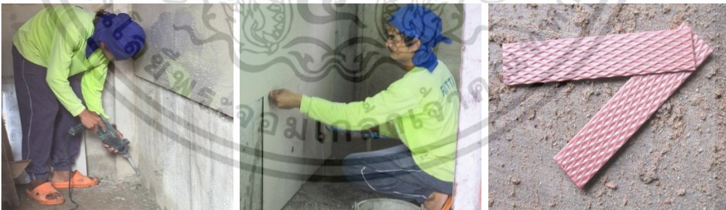
ใช้สว่านเจาะสกัดเศษปูนตามของเสารอก ปูกระเบื้องผนังแล้วใช้แผ่นพลาสติกเสียบคั่นระหว่างแผ่น
