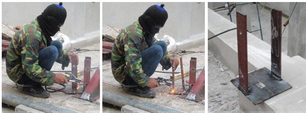
เชื่อมยึดแป้นเพลทเหล็กและเพลทเหล็กยึดเสาเข้าด้วยกัน
