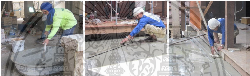
ผสมคอนกรีตปรับพื้นในกระบะผสมด้วยจอบ ตักใส่ถังแล้วยกขึ้นมาเทที่พื้นชั้น2 ก่อนใช้เกรียงฉาบและสามเหลี่ยมปาดปรับผิวให้เรียบเสมอกันและตามระดับที่ตั้งไว้
