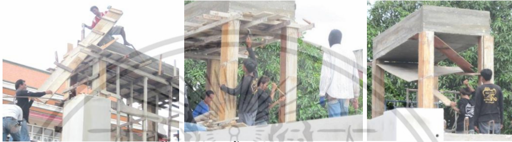
ยกไม้แบบหล่อด้านข้างลงมาที่ชั้น2 จัดโครงค้ำแบบใต้หลังคาออก จัดแผ่นไม้อัดและใช้มือดึงลงมา
