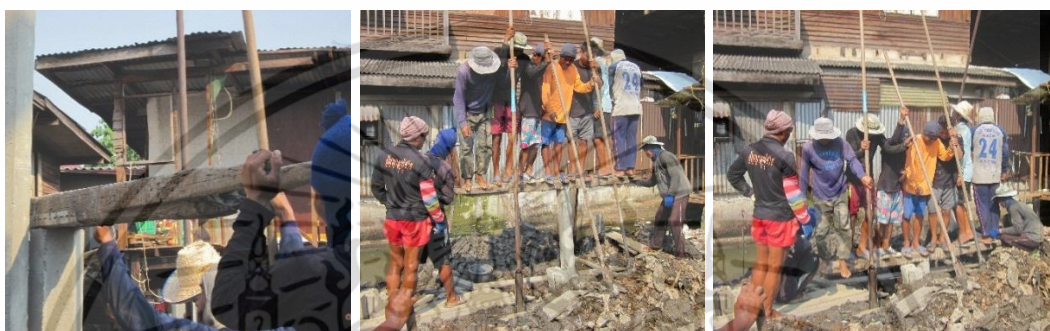
เมื่อข่มจบเสาเข็มลงมาเหลือความสูงประมาณ 1.50 เมตร จับด้ามที่ปลายไม้ข่มยกขึ้น แล้วหย่อนเหล็กเสริมบริเวณตรงกลางด้านล่างไม้ข่มลงในตำแหน่งรูตรงกลางเสาเข็ม ใช้เสียมด้ามยาวค้ำพื้นแล้วกระโดดยกตัวขึ้นไปบนไม้ข่ม ให้สัญญาณก่อนจึงเริ่มข่มจนถึงระดับที่กำหนด
