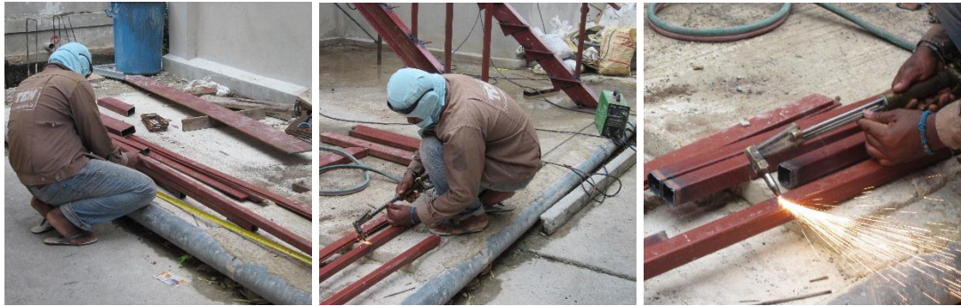
วัดความยาวของเหล็กกล่องเพื่อทำราวกันตก ขนาด 1 ½” x 1 ½” และตัดด้วยแก๊สตัดเหล็ก
