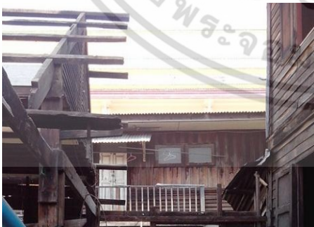
รื้อถอนโครงสร้างหลังคาพื้นที่เชื่อมต่ออาคาร และรื้อถอนแผ่นสังกะสี
