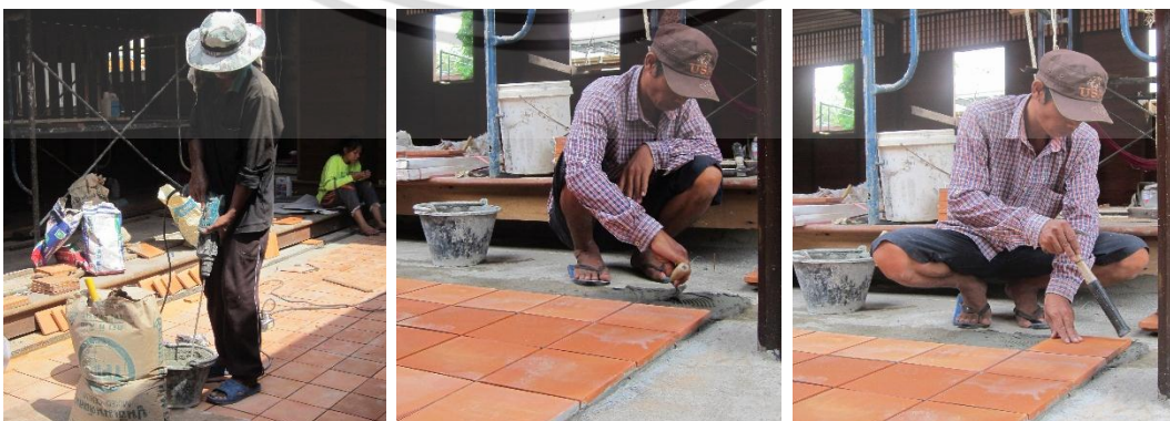
ผสมปูนกาว และน้ำให้เข้ากันด้วยสว่านดอกปั่นปูน ใช้เกรียงตักปูนกาวลงบนพื้น
