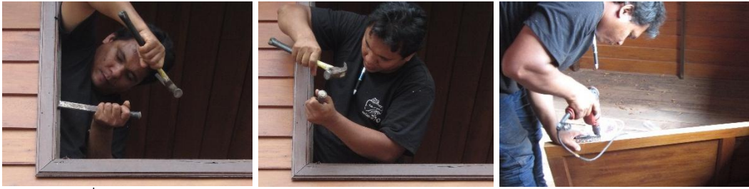
ใช้ค้อนตอกส่วสกัดเซาะร่องวงกบสำหรับยึดบานเปิดหน้าต่าง ใช้ส่วานยึดสกรูบานเปิดและหน้าต่าง
