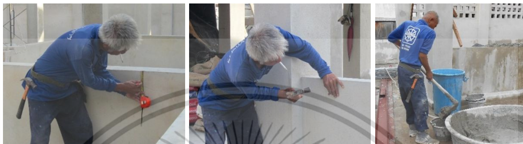
วัดระยะด้วยตลับเมตรแล้วใช้ดินสอขีดระดับที่กำหนดก่อนการติดตั้ง ตักปูนกาวที่ผสมแล้วใส่ถึง
