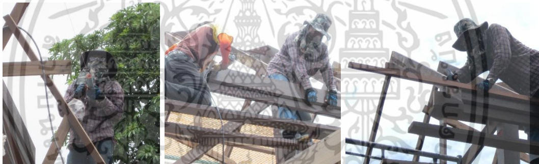
ดิ่งเต็าระบุแนวยึดไม้เชิงชายและใช้เครื่องยิงตะปูลมยึดไม้เชิงชาย วัดระยะก่อนตัดส่วนเกินออก
