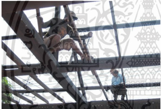
จัดโครงคร่าว์ฝ้าออกด้วยชะแลง นำคร่าว์ฝ้าลงมาและถอนตะปูออก
