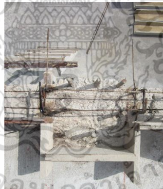
เข้าแบบข้างด้านในขอบพื้นชานชั้น 2 เชื่อมเหล็กเสริมยึดต่อกันตามแบบ และเชื่อมแถมเหล็กยึดแบบ
