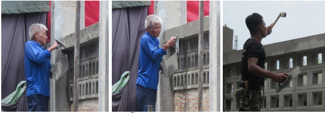
ใช้เกรียงปาดปูนฉาบบนทับหลังทั้งด้านข้างและด้านบน ฉาบปรับให้ได้ระดับเสมอกัน รอให้ปูนฉาบเริ่มแข็งอยู่ตัวพอประมาณจึงใช้แปรงจุ่มน้ำแล้วพรมลงบนทับหลัง
