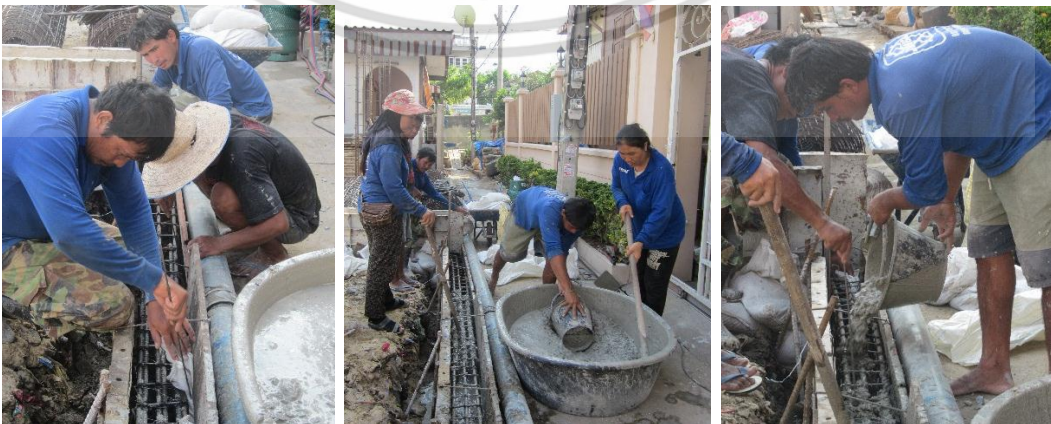
เทคอนกรีตที่เหลือจากรถคอนกรีตผสมสำเร็จลงแบบหล่อ และผสมคอนกรีตในกะบะเพื่อเทคานพื้น
