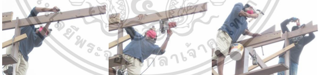
ยกไม้อกไก่ขึ้นไปติดตั้งบนร่องที่บากไว้บนเสาดั้ง ใช้ตลับเมตรวัดระยะยื่นของไม้อกไก่ วัดระยะแนวตัดให้ได้ฉากและใช้เลื่อยวงเดือนไฟฟ้าตัดไม้อกไก่ที่ยื่นเกินออก วัดระยะติดตั้งไม้จันทัน แล้วใช้ค้อนหงอนตอกตะปูยึดไม้สามเหลี่ยมสำหรับยึดไม้จันทัน ทั้งบนไม้อะเสและไม้อกไก่
