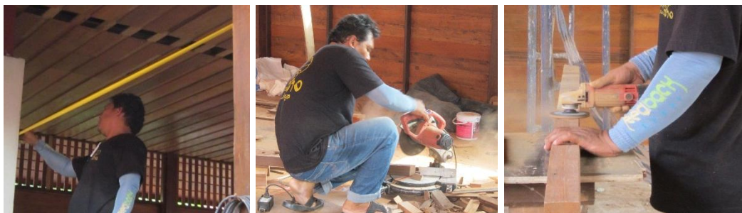
วัดระยะความยาวช่องแสง ตัดไม้วงกบช่องแสงด้วยแท่นตัดไฟเบอร์ แล้วขีดด้วยเครื่องเจียรไฟฟ้า
