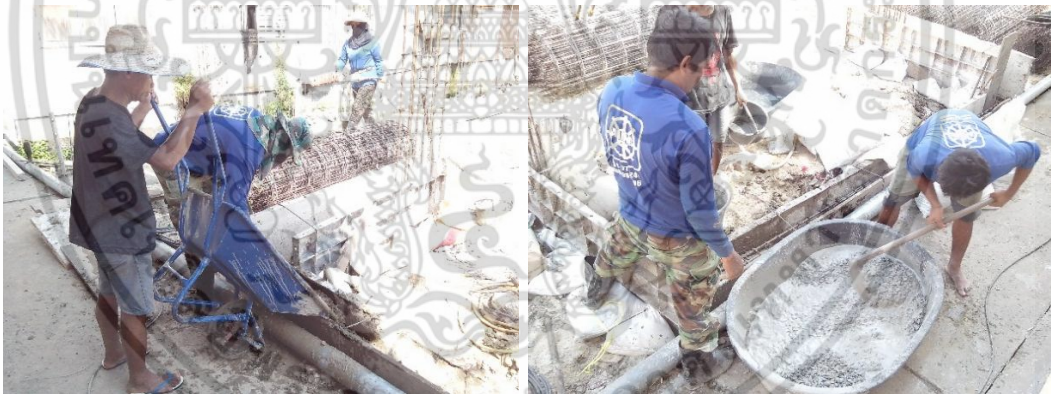
เทคอนกรีตที่เหลือจากรถคอนกรีตผสมสำเร็จลงแบบหล่อ และผสมคอนกรีตในกะบะเพื่อเทคานพื้น
