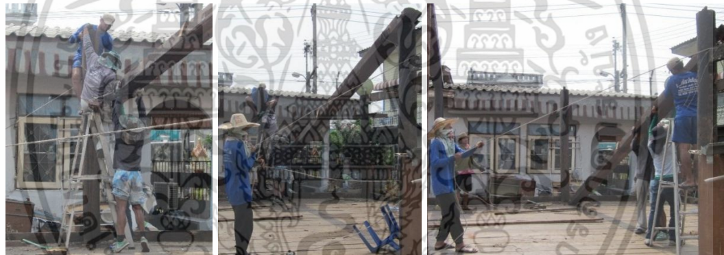
ยกชื่อที่หัวเสาหนึ่งลงพร้อมดึงเชือกไว้ทั้งสองข้าง และค่อยๆ ผ่อนเชือกที่ผูกไว้กับชื่อลงทีละฝั่ง
