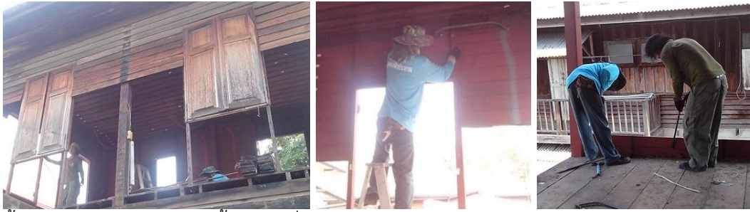
รื้อถอนผนังไม้และหน้าต่างชั้น 2 ใช้เลื่อยคั้นธนูตัดเคร่ายึดผนังออก จัดไม้ฝ้าผนังออกด้วยชะแลง
