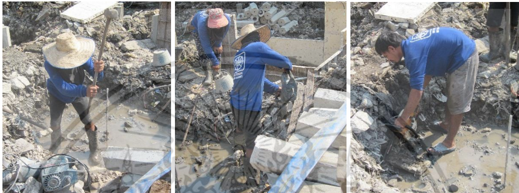
ใช้ค้อนปอนด์ทุบเสาคอนกรีตที่ฝังอยู่ในดินให้แตก หากไม่ออกจึงใช้เครื่องสกัดเจาะคอนกรีตออก ใช้เลื่อยโซ่ไฟฟ้าตัดเศษไม้ที่ฝังอยู่ในดินออก
