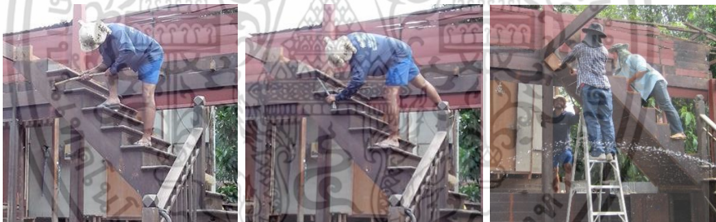
ตอกย้อนไม้พื้นบันไดด้วยค้อนปอนด์ จัดไม้พื้นบันไดและไม้ท่อนบันไดออกด้วยชะแลง
