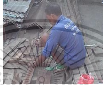
ตัดไม้ปลายไม้ด้วยเลื่อยคันทันธู ถอนตะปูออก แล้วมัดคองไม้รวมรวมด้วยเชือก
