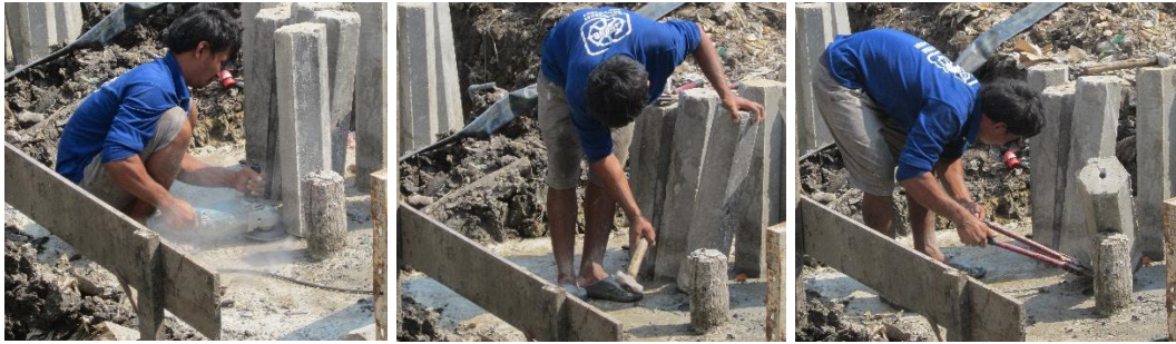
ใช้เครื่องเจียรไฟฟ้าตัดโคนเสาเข็ม ใช้ค้อนปอนด์ตอกที่โคน และใช้กรรไกรตัดเหล็กเส้นให้ขาด
