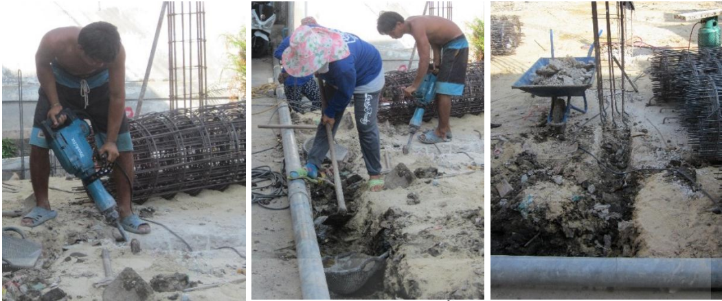
ใช้เครื่องสกัดเจาะฐานราก คสล. ใช้จอบขุดดินแนวคานพื้น แนวคานที่ถูกขุดแล้ว
