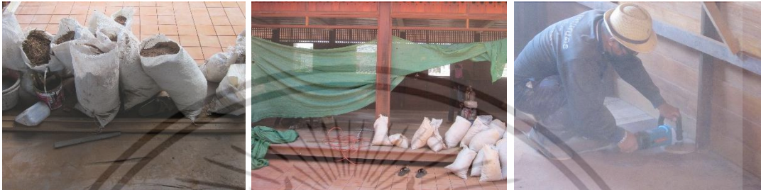
ตักเศษไม้ใส่กระสอบ ตัดผ้าใบกันฝุ่นกระจายออกภายนอก ใช้เครื่องเจียรไฟฟ้าขัดผิวไม้ส่วนมุมห้อง
