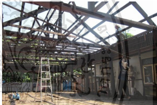
จัดโครงคร่าว์ฝ้าออกด้วยชะแลง นำคร่าว์ฝ้าลงมาและถอนตะปูออก
