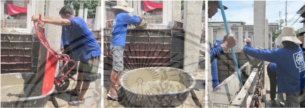
เทคอนกรีตจากรถเข็นลงกะบะใส่คอนกรีต แล้วใช้ถังตักก่อนเทบนแบบหล่อผนัง
