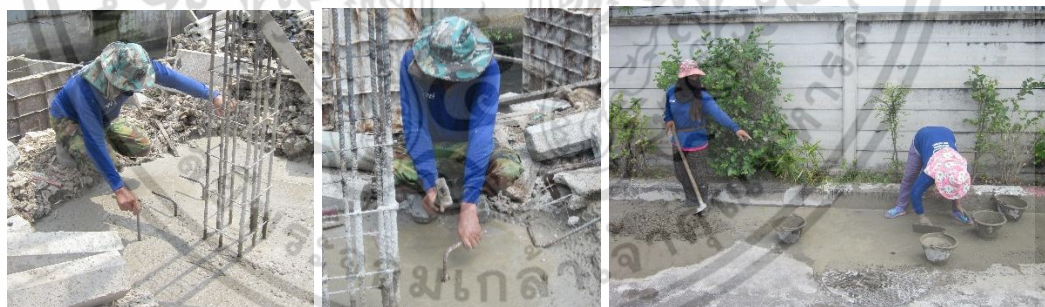
ปิดหมดเหล็กยึดพื้นกับฐานรากเมื่อคอนกรีตเริ่มแข็งตัว ใช้จอบและเกรียงตักเศษคอนกรีตใส่ถัง
