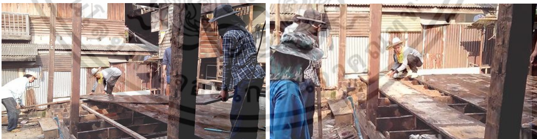
ถอนตะปูออก จัดพื้นไม้แผ่นต่อไปออกแล้วพลิกแผ่นไม้กลับด้านวางลงบนตงไม้เพื่อยึดไม้แผ่นต่อไป
