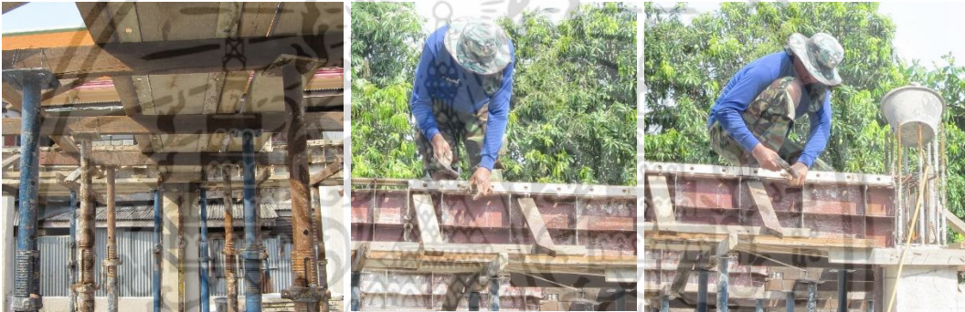
ติดตั้งแบบเหล็กข้างหล่อคาน คสล. ใช้ค้อนตอกสลักยึดแบบเข้าด้วยกัน
