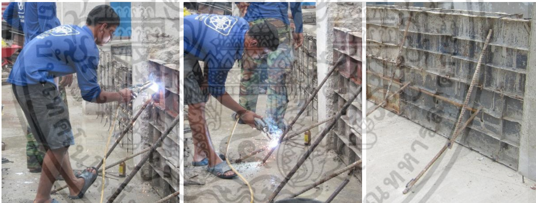
เชื่อมเหล็กค้ำกับแบบเหล็กหล่อผนัง
