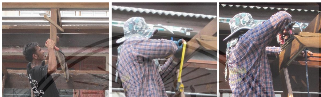
ใช้สว่านยึดสกรูกับจันทันและแป้นไม้รับจันทันอีกครั้ง วัตถุประสงค์ก่อนติดตั้งไม้ระแนงยึดแผ่นกระเบื้อง
