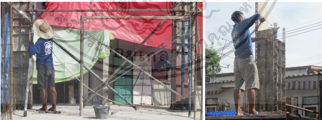
เชื่อมติดเหล็กค้ำแบบและแบบหล่อเหล็กหล่อคอนกรีตสำหรับหล่อเสา
