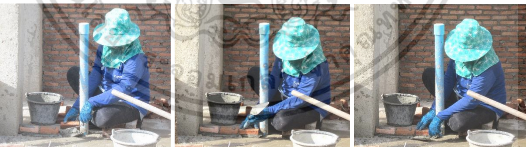
ใช้เกรียงก่อตักปูนก่อลงบนแนวที่จะก่อ วางอิฐมอญลงและปาดส่วนที่ล้นออกด้านข้างทั้งสอง
