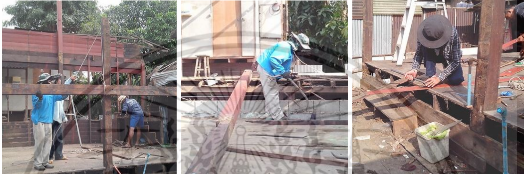
ลดเชือกลงเพื่อให้คานพื้นลงมา ใช้เลื่อยตัดเสาชั้น1 ออก และงัดตะปูออกจากไม้ด้วยค้อนหงอน
