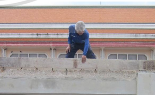
วางไม้แบบข้างด้านนอก วัดและตัดไม้แบบตามขนาดช่วงเสา
