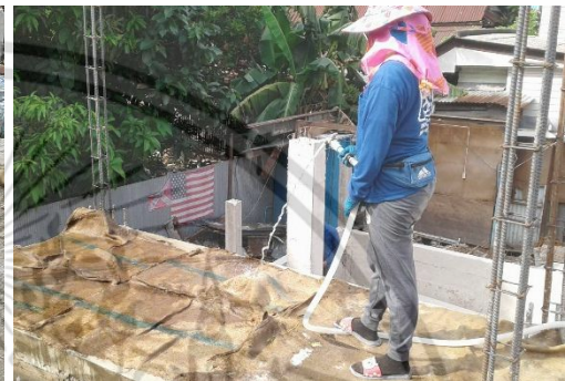
วางกระสอบลงปิดผิวพื้น คสล. ที่แกะแบบหล่อแล้ว ฉีดน้ำบนกระสอบให้ความชื้นขณะบ่มคอนกรีต
