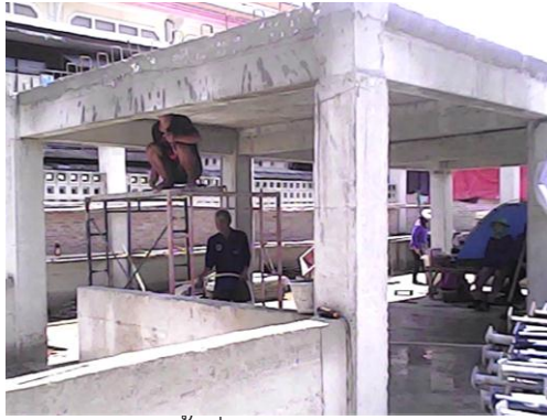
ตั้งนั่งร้านแล้วใช้ชะแลงจัดแบบเหล็กหล่อและไม้แบบล่างพื้นออก
