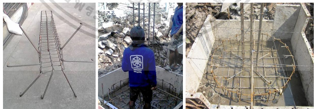
ยกเหล็กเสริมเสาเข้ามาตั้งที่หลุมฐานราก และยึดตำแหน่งโดยเชื่อมเหล็กเส้น กับแบบหล่อฐานราก อิงระยะศูนย์กลางตามแบบ
