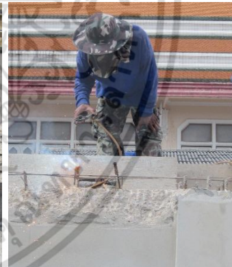
เข้าแบบข้างด้านในขอบพื้นชานชั้น 2 เชื่อมเหล็กเสริมยึดต่อกันตามแบบ และเชื่อมแถมเหล็กยึดแบบ
