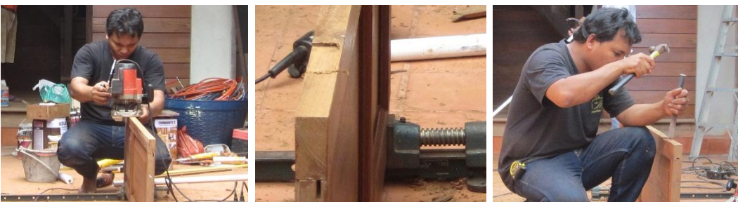
วัดระยะความสูงบานหน้าต่างเทียบกับวงกบ ใช้เลื่อยวงเดือนตัดบานส่วนที่เกินออก ใช้กบไฟฟ้าไสไม้ปรับให้ได้ระยะ และใช้เครื่องเจียรไฟฟ้าขัดให้เรียบอีกครั้ง
