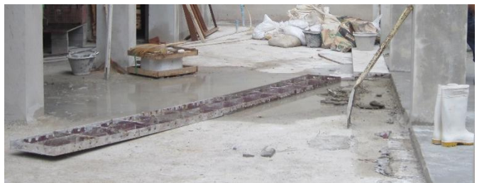
รอให้คอนกรีตแข็งตัว ใช้เกรียงเหล็กขัดที่ผิวพื้นให้ทั่วพื้นที่ เสร็จแล้วจึงถอดแบบข้างออก เอกสารนี้เป็นเอกสารที่สงวนไว้สำหรับการใช้งานเพื่อการศึกษาเท่านั้น เมื่อนุญตเห็นาไปใช้ประโยชน์ด้านการค้าไม่ว่ากรณีใดๆ ทั้งสิ้น อีกทั้งห้ามมิให้ตัดแปลงเนื้อหา และต้องอ้างอิงถึงเจ้าของเอกสารทุกครั้งที่มีการนำไปใช้
