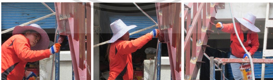
ใช้แปรงทาสีกันสนิมทับให้ทั่วทั้งหมดของโครงสร้างบันได
