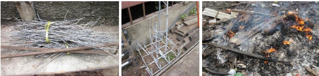
มัดเหล็กเสริมด้วยเชือก แยกเหล็กเสริมฐานรากออก เผาเศษไม้และขยะที่อยู่ในไซต์ด้วยไฟ
