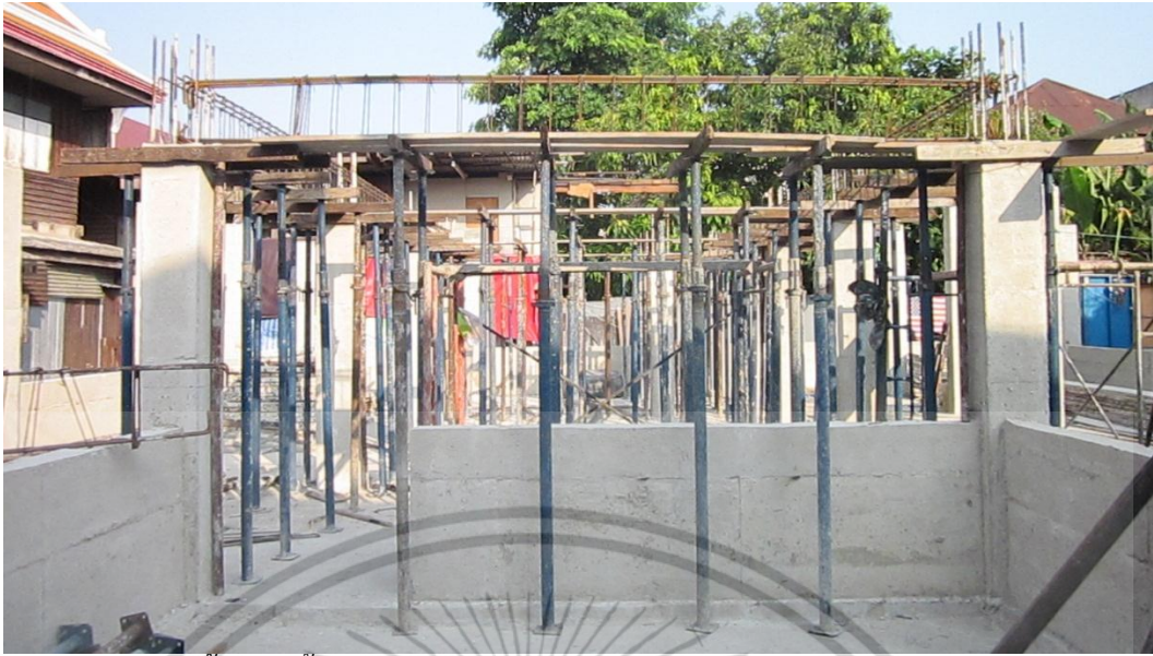
ติดตั้งเหล็กค้ำแบบหล่อคาน คสล. เรียบร้อย รอเข้าแบบด้านข้างต่อไป
