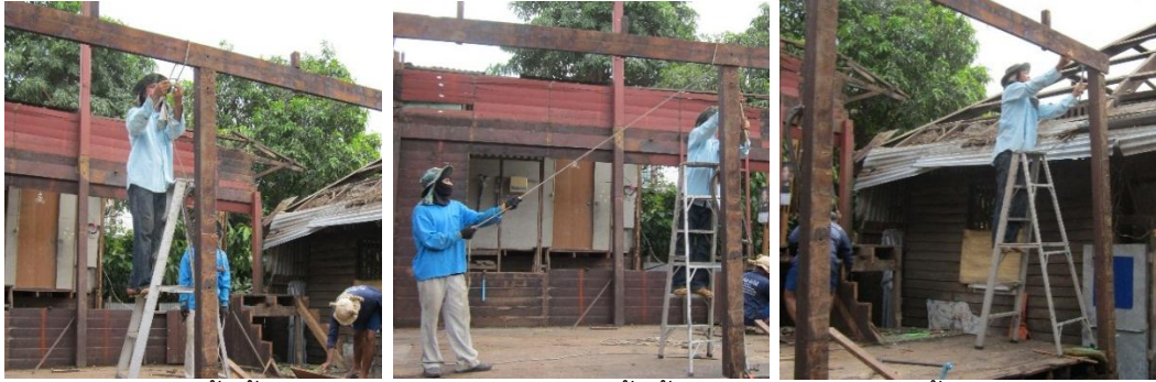
ผูกเชือกกับคานพื้นชั้นสอง ดึงเชือกไว้ก่อนเอาคานพื้นชั้น2 ลง และตอกคานพื้นให้หลุดด้วยค้อน
