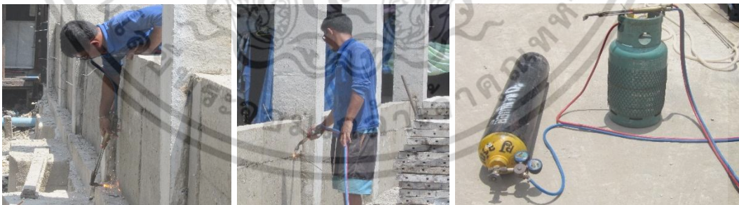
ใช้แจ๊คตัดเหล็กที่ฝังอยู่ในผนังหล่อออก
