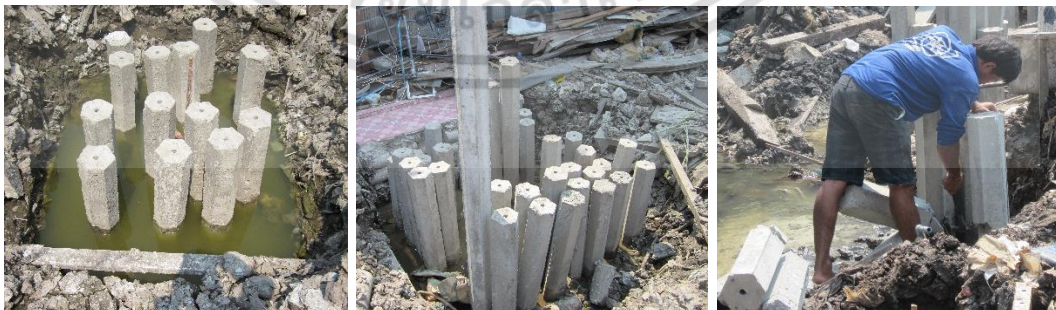
หลุมเสาเข็มที่ถูกเทพื้นลื่นคอนกรีตแล้ว ใช้ค้อนหงอนตอกบริเวณโคนเสาเข็มให้แตก
