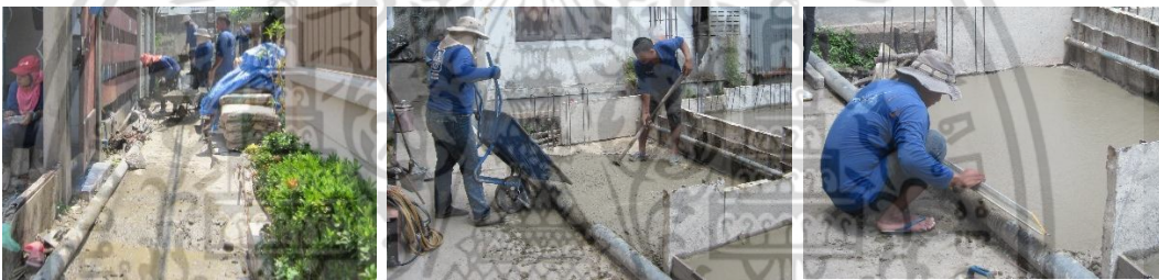
ทำความสะอาดเศษคอนกรีต เทคอนกรีตที่เหลือลงบนพื้นที่ด้านข้างที่เหลืออยู่และฉาบปรับระดับผิว
