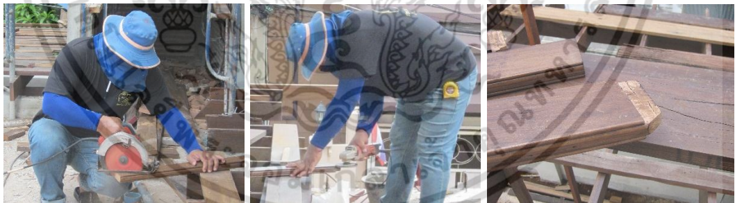
ใช้เลื่อยวงเดือนไฟฟ้าตัดปลายไม้ปาดเอียงและบากปลายเดือยอีกข้าง ใช้หินเจียรขัดผิวให้เรียบร้อย
