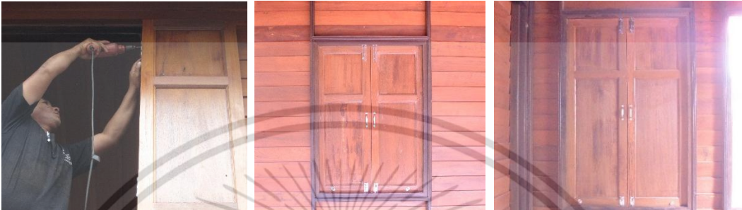
ใช้ส่วานยึดสกรูบานเปิดและวงกบเข้าด้วยกัน
