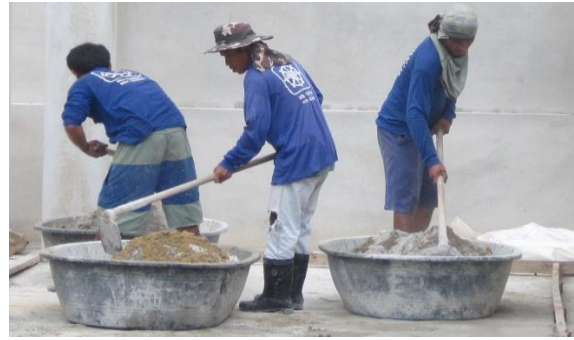
ขนทรายและซีเมนต์เพื่อนำมาผสมในกะบะผสมด้วยจอบจนส่วนผสมเข้ากัน
