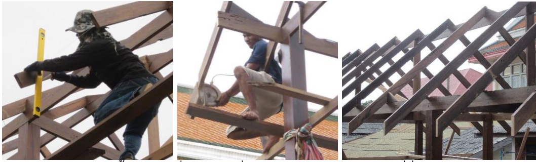
ใช้ระดับน้ำวัดให้ได้ดิ่ง และใช้เลื่อยวงเดือนไฟฟ้าตัดไม้เอกไก่อที่ยื่นเกินออก
