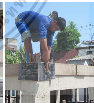
ตีเต้าเพื่อกำหนดแนวในการยึดแบบหล่อพื้น คสล. ด้านข้าง ใช้ค้อนตอกตะปูยึดแบบด้านข้างโดยรอบ
