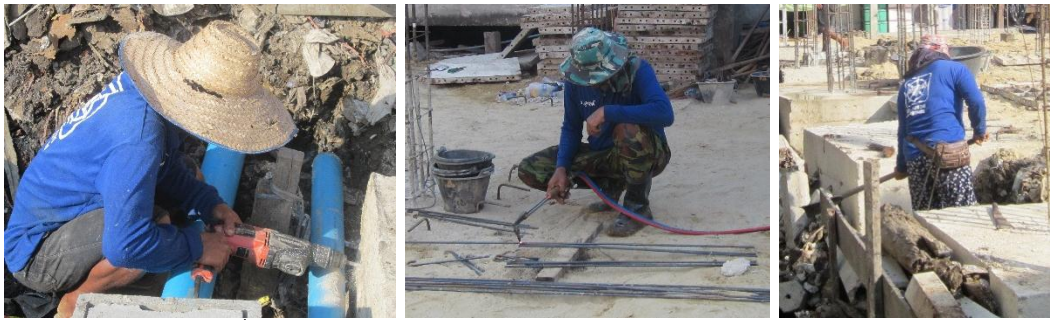
ใช้สว่านเจาะฐานรากเพื่อฝังเหล็กเสริม ใช้แก๊สตัดเหล็กเสริม ใช้เสียมขุดดินรอบแนวผนังกันดินออก
