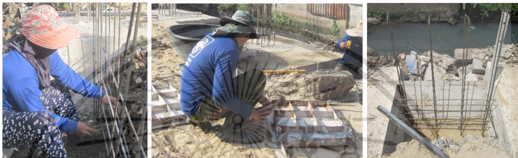
ผูกเหล็กเสริมผนังกันดินด้วยคีมมัดลวด ตอกสลักยึดแบบหล่อผนังกันดิน ติดตั้งแบบหล่อผนังกันดิน
