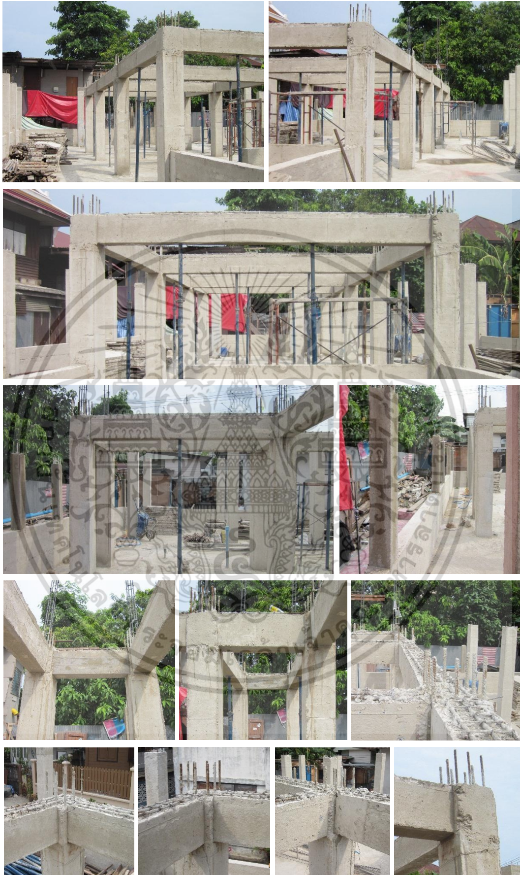
คาน คสล. และเสาเข็มที่แกะแบบแล้ว
