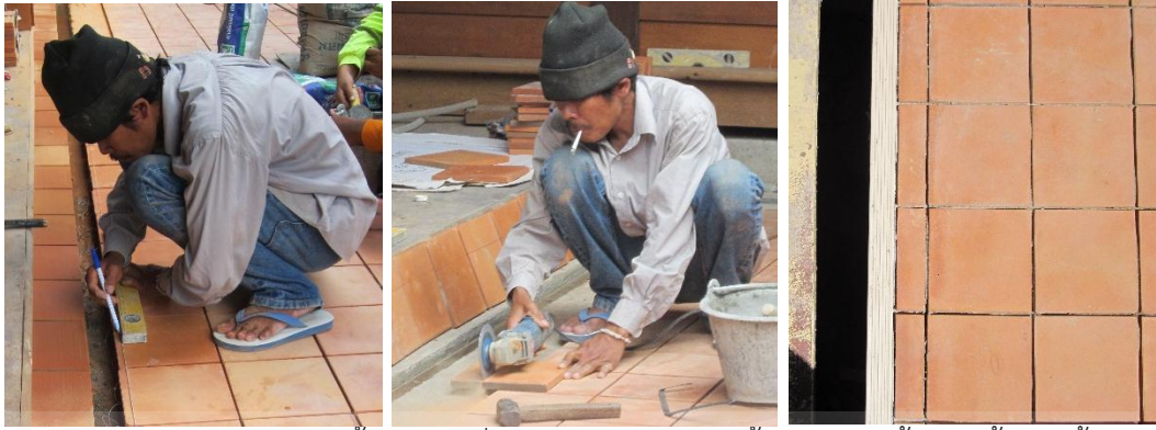
วัดระยะ ชีตแนว และตัดกระเบื้องด้วยเครื่องเจียรไฟฟ้า ปูกระเบื้อง และติดคิ้วขอบพื้นทางขึ้นบันได
