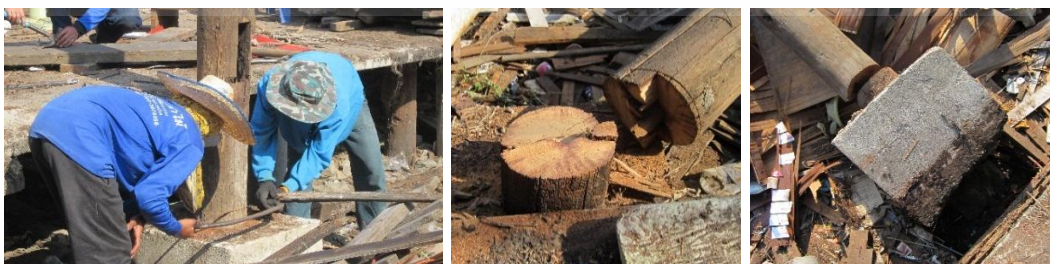
เลื่อยเสาไม้อาคาร 3 ออกจากฐานราก คสล. เสาไม้อาคาร 3 ฐานรากอาคาร3
