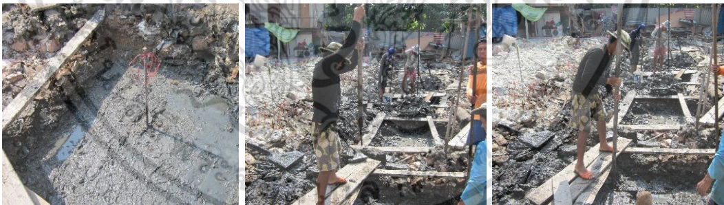
ใช้จอบขุดหลุม และเก็บเศษดินและคอนกรีตรอบๆ หลุมออก
