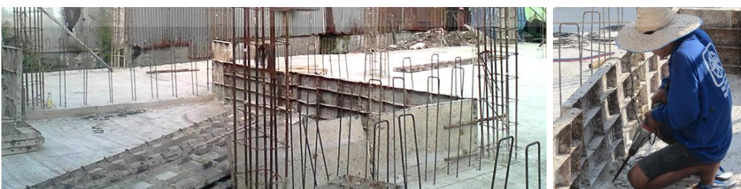
ถอดสลักยึดแบบเหล็กหล่อออก ใช้แก๊สตัดเหล็กที่เชื่อมแบบเหล็กหล่อออก ใช้เครื่องสกัดไฟฟ้าสกัด
