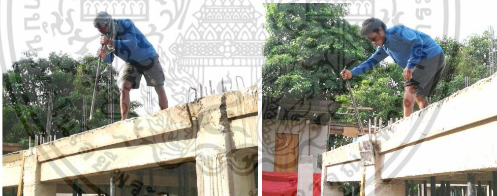
ถอดเหล็กค้ำแบบออก และใช้ชะแลงจัดไม้แบบข้างหล่อพื้น คสล. ออก
