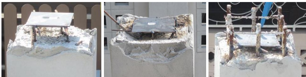
เชื่อมยึดแป้นเพลทเหล็กกับเหล็กเส้นที่โผล่บนหัวเสาด้วยรูปเชื่อมและเครื่องเชื่อมไฟฟ้า
