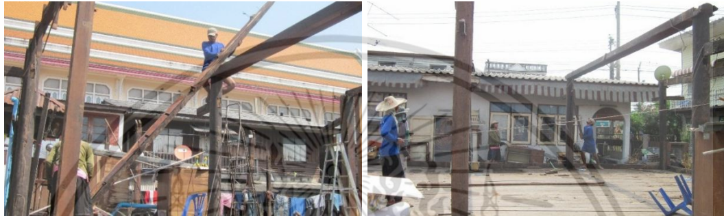
รื้ออะเสลงจากหัวเสาด้วยชะแลง ผูกเชือกกับชื่อทั้งสองฝั่งแล้วมัดกับเสาก่อนยกหัวชื่อลง
