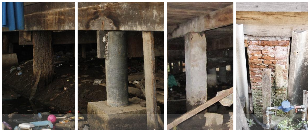
ภาพที่ 1.4 สภาพก่อนการปรับปรุงขององค์ประกอบอาคารที่แตกต่างกันของบ้านพาทย์โกศล ( ที่มา : ผู้วิจัย ถ่ายเมื่อ 20 ธันวาคม 2559 )
