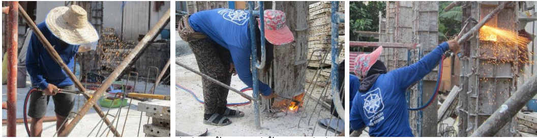
ใช้แก๊สตัดเหล็กที่เชื่อมค้ำแบบที่พื้นและที่เชื่อมแบบเหล็กหล่อออก
