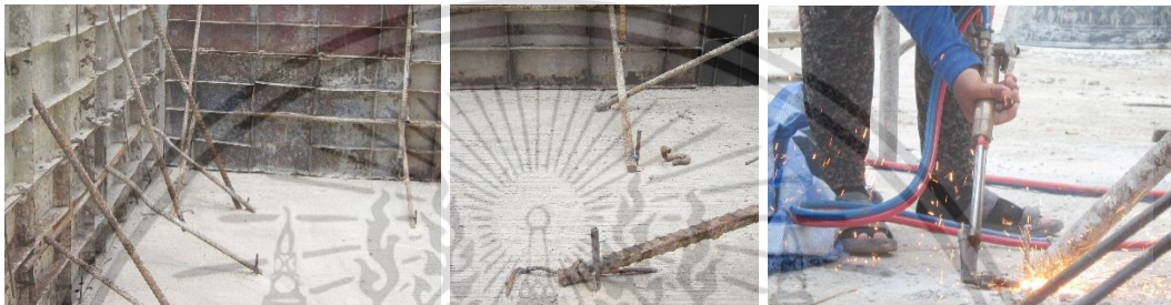
ใช้แจ๊คตัดเหล็กที่เชื่อมค้ำแบบเหล็กหล่อผนังออก
