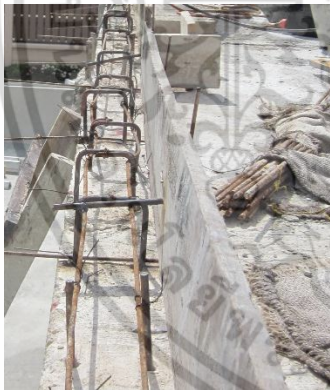
เข้าแบบข้างด้านในขอบพื้นชานชั้น 2 เชื่อมเหล็กเสริมยึดต่อกันตามแบบ และเชื่อมแถมเหล็กยึดแบบ
