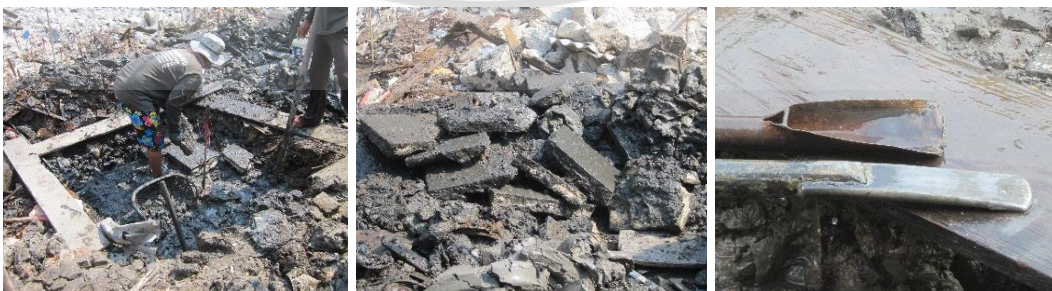
หยีบเศษพื้นคอนกรีตเดิมขึ้นจากหลุม เครื่องมือที่ใช้ในการเจาะพื้นและหลุมเสาเข็ม
