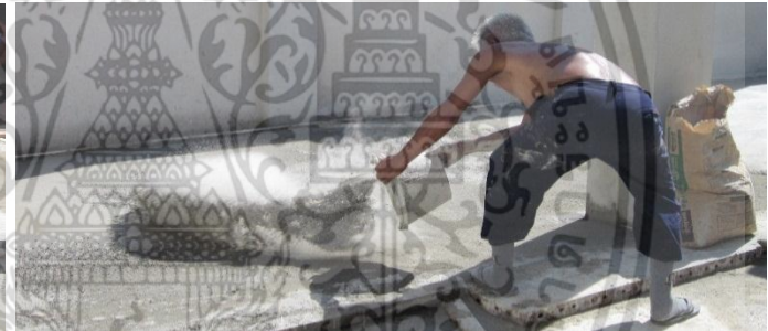
รอให้คอนกรีตแข็งตัวประมาณ 10 นาที ตักซีเมนต์ผงใส่ถัง ใช้มือจับโรยและเทผงซีเมนต์ลงบนพื้นคอนกรีตให้ทั่วพื้นที่ที่จะทำการขัดมัน
