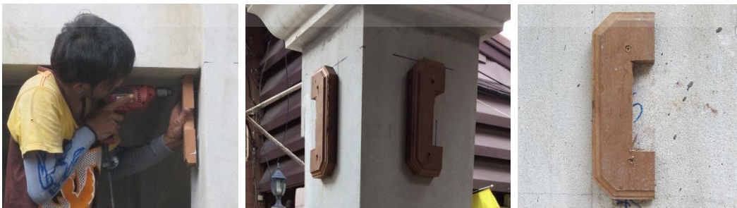
วัดระยะและกำหนดตำแหน่งยึดแป้นไม้รับเคร้านอนด้วยตลับเมตร เจาะรูเสา คสล. ด้วยสว่านไฟฟ้า
