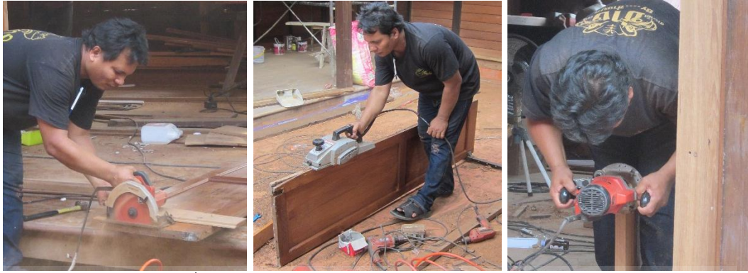
ใช้เลื่อยวงเดือนตัดกรอบบานออก ไขกบไฟฟ้าใส่ปรับไม้
