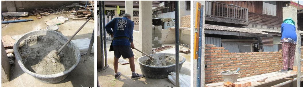
ผสมซีเมนต์ ทรายและน้ำให้เข้ากันสำหรับก่อผนังรื้อ พร้อมทำแนวโดยยึดเอ็นชิ่งกับตะปู
