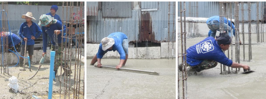
เทคอนกรีตและใช้จอบและไม้ปาดเกลี่ยปริมาณคอนกรีตให้กระจายตัวสม่ำเสมอและทั่วพื้นที่
