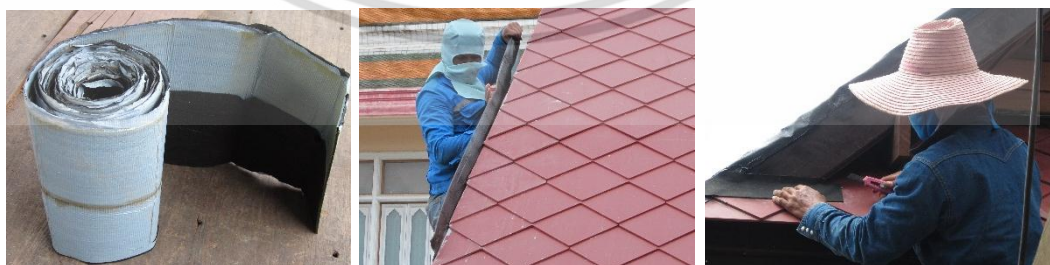
ใช้แผ่นกาวยางกันซึมแปะทับบริเวณสันหลังคา ใช้คัตเตอร์ตัดแต่งขนาดที่ใช้ตามความเหมาะสม
