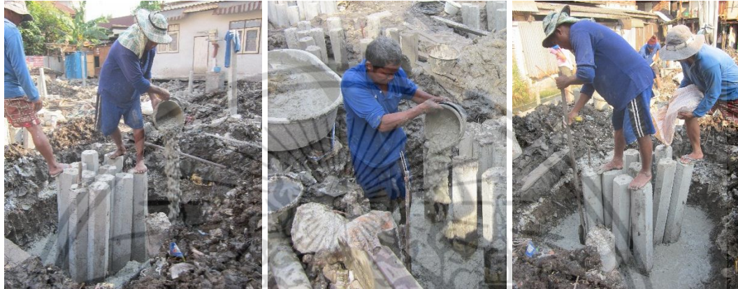
ใช้ถังตักและเทคอนกรีตลงหลุมฐานราก ใช้เสียมเกลี่ยปริมาณและปรับระดับคอนกรีต
