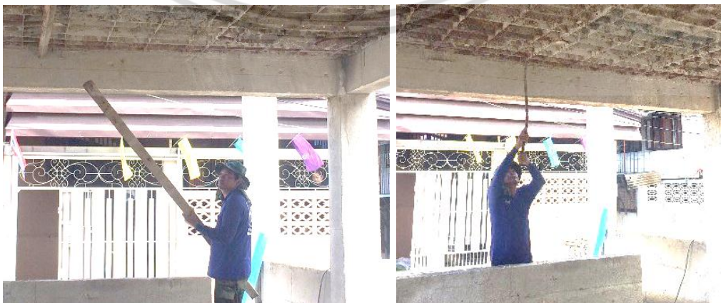
ถอดเหล็กค้ำแบบออก และใช้ชะแลงจัดไม้แบบข้างหล่อพื้น คสล. ออก
