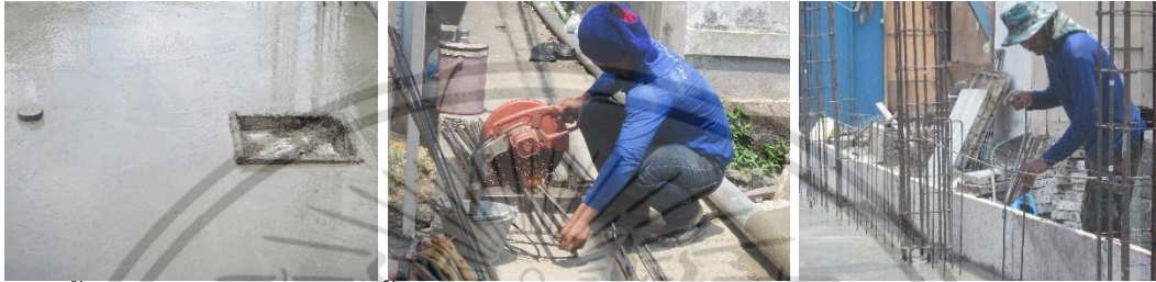
บริเวณพื้นที่ส่วนบ่อส้วมและบ่อพักน้ำ ใช้แท่นตัดไฟเบอร์ตัดเหล็กเสริม และปักลงบนแนวผนัง
