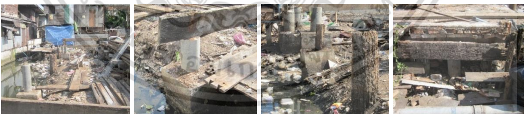
รื้อถอนโครงสร้างพื้น ตง คาน บันได และซุ้มประตูทางเข้าอาคาร
