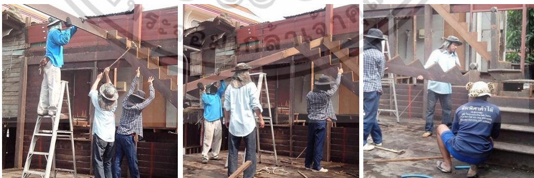
ตอกตงรับบันไดออกด้วยค้อนปอนด์ จ้างตงรับบันไดชั้น 2 ลงมาด้วยมือ จัดแม่บันไดออกด้วยชะแลง
