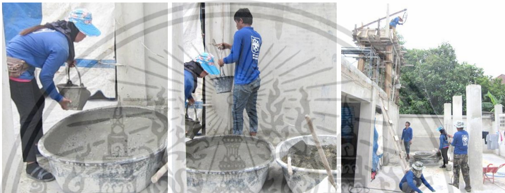
ตักคอนกรีตที่ผสมในกะบะใส่ถัง เกี่ยวกับตะขอที่ผูกกับเชือกกรอกไว้ แล้วดึงเชือกขึ้นด้านบน
