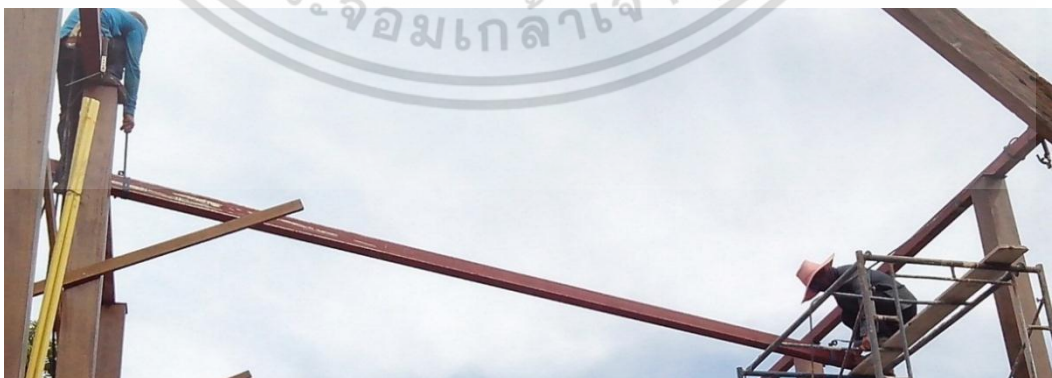
ผูกเชือกกับเหล็กข้อ ขนาด 6"x6" และยกขึ้นเพื่อวางบนเพลาเหล็กหัวเสา
