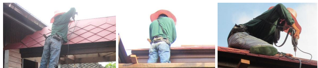
ติดตั้งแผ่นกระเบื้องหลังคาด้านที่เหลือและครอบสันหลังคาจนครบทุกด้าน
