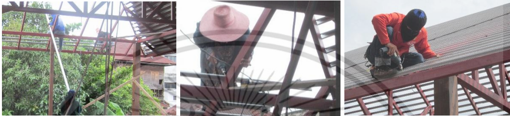
ยกแผลสำเร็จรูปขึ้นวางบนโครงสร้างหลังคา วัดระยะห่างระหว่างแป ใช้สว่านยึดสกรูเข้ากับจันทัน
