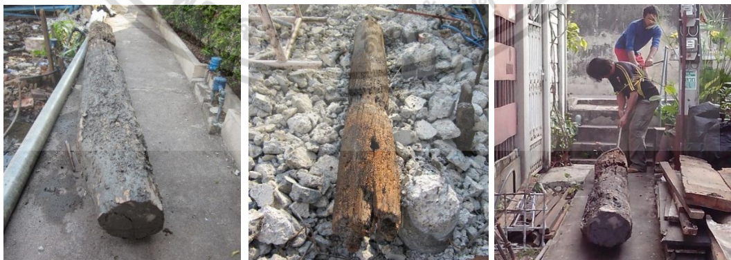
เสาไม้อาคารเดิม
