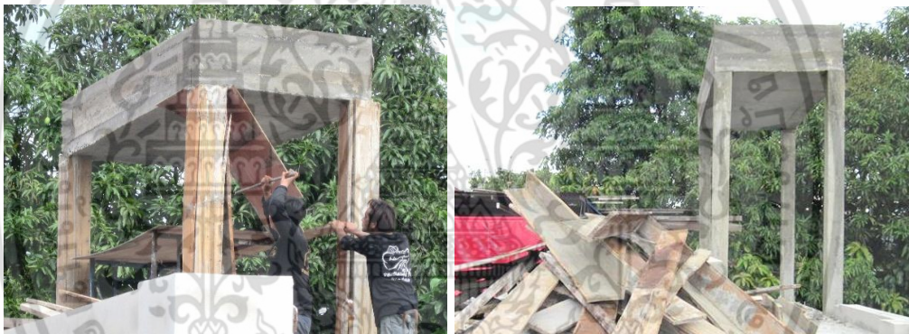
จัดแบบหล่อเสาและแผ่นไม้อัดหลุดออก ถอดแบบเสาออก ถอนตะปูออกก่อนนำไม้ไปใช้งานอื่นต่อไป
