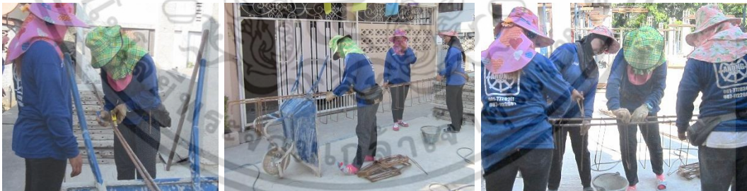
ใช้คีมผูกยึดลวดกับเหล็กเสริมระยะตามแบบ
