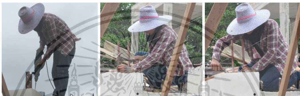
ใช้ส่วนเจาะรูที่หัวเสาบริเวณพื้นชั้น2 ใช้ค้อนตอกทุกเหล็กลงในรู แล้วใช้ประแจปากตายขันให้แน่น
