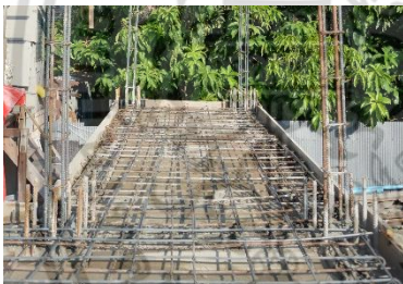
เหล็กเสริมพื้น คสล. บริเวณห้องน้ำ และตำแหน่งท่อระบายน้ำบริเวณชานกลางบ้าน
