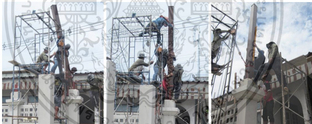
เมื่อตั้งขึ้นสวมลงบนแป้นเพลทเหล็กและเพลทเหล็กยึดเสาได้แล้ว ใช้ระดับน้ำวัดให้ได้ตั้งและฉาก
