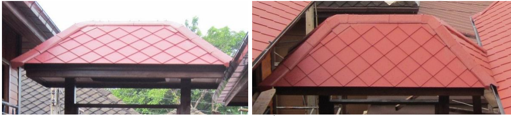
หลังคาซุ้มทางเข้าที่ยึดเสร็จแล้ว
