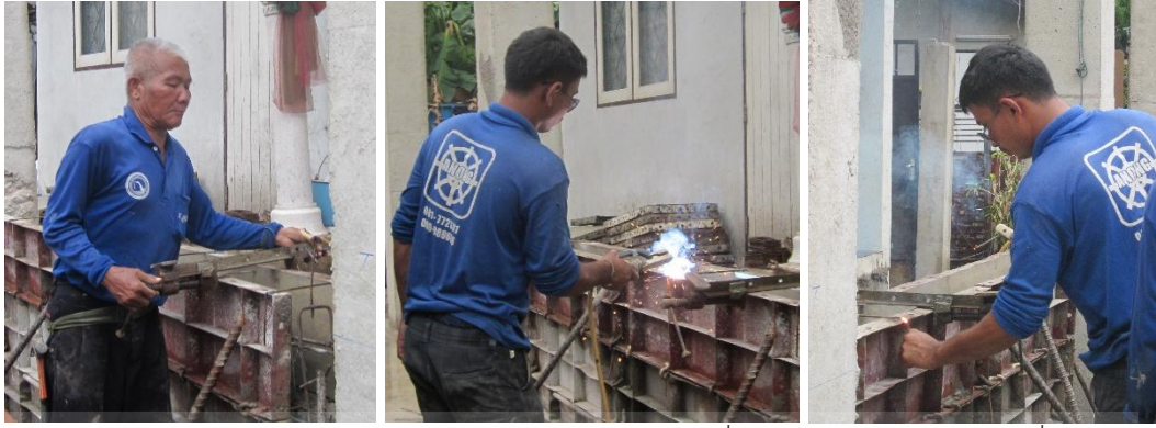
ใช้แคลมป์ยึดแบบหล่อตามระยะห่างของแบบเหล็กหล่อผนัง เชื่อมเหล็กเสริมและตัดลงเพื่อลื้อกระยะ
