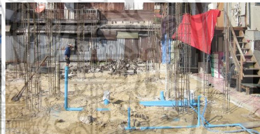
เดินท่อประปา-บ่อพัก-ระบายน้ำภายในห้องน้ำ
