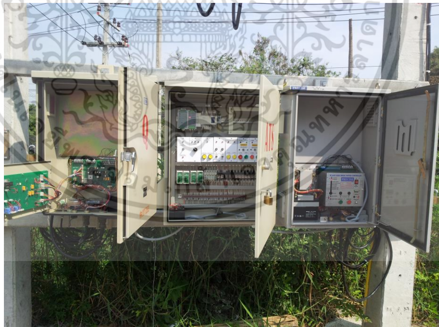
รูปที่ 3.22 การติดตั้งทดสอบเครื่องควบคุมแบบตรรกะที่โปรแกรมได้
