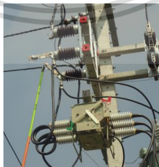
รูปที่ 4.6 การทดสอบโดยการปลด Drop Fuse แรงสูง
