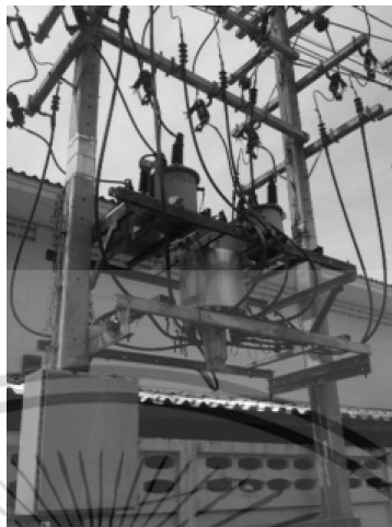
รูปที่ 3.4 ระบบถ่ายโอนแหล่งจ่ายอัตโนมัติแรงสูง
