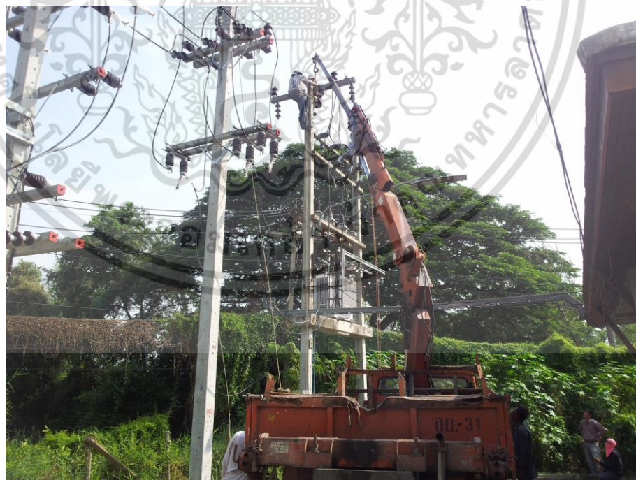
รูปที่ 3.20 การติดตั้งระบบตัดตอนแรงดันต้นสูง
