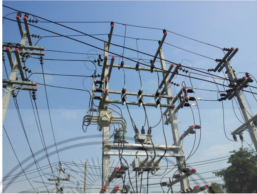
รูปที่ 3.21 การติดตั้งระบบตัดตอนแรงดันดันสูง
