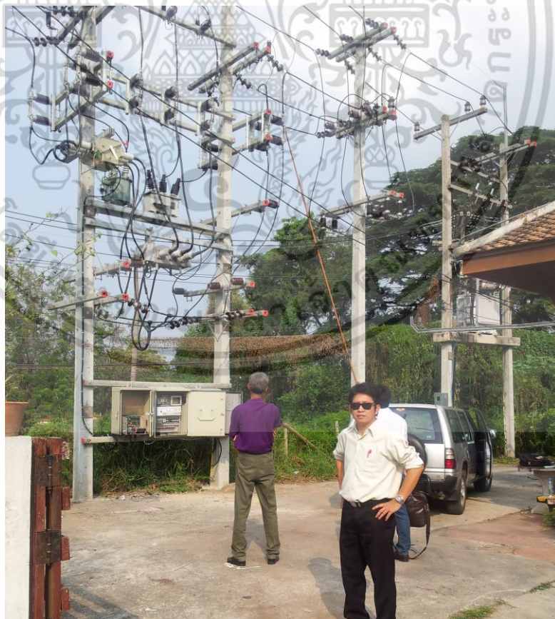
รูปที่ 3.24 การติดตั้งและทดสอบการทำงานของระบบ ATS ชั้นตอนสุดท้าย
