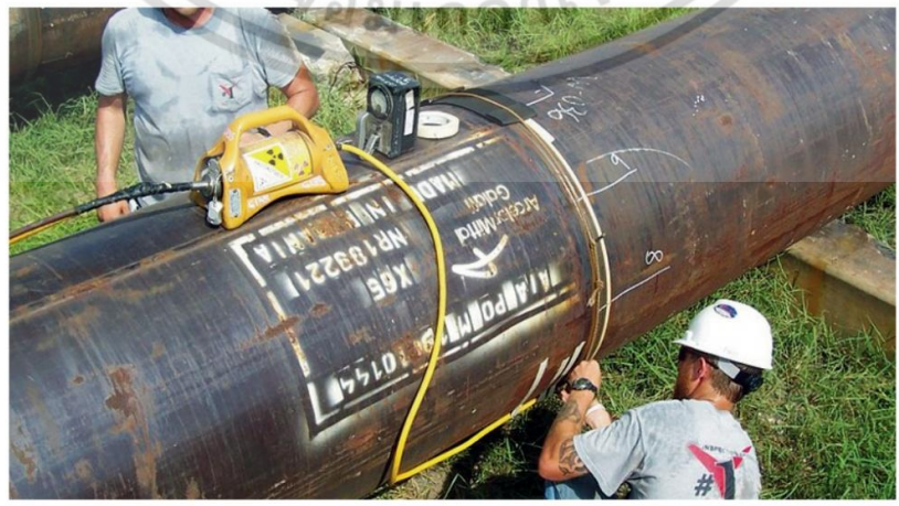
รูปที่ 2.16 การตรวจสอบด้วยภาพถ่ายรังสีรอยเชื่อมท่อ
