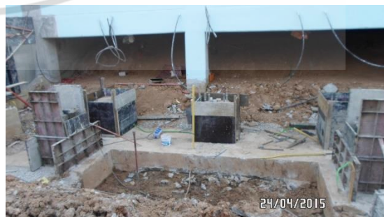
รูปภาพที่ 4.18 แสดงตัวอย่างการตรวจสอบตำแหน่งและระดับ Anchor bolt
