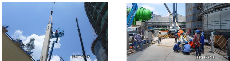
รูปภาพที่ 4.20 แสดงตัวอย่างการตรวจสอบการยกชิ้นงานอย่างถูกวิธี
