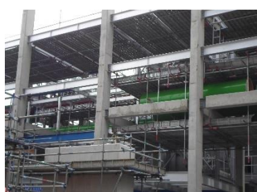
รูปภาพที่ 4.13 แสดงตัวอย่างของการทำคอนกรีตป้องกันไฟหุ้มโครงสร้างเหล็ก
