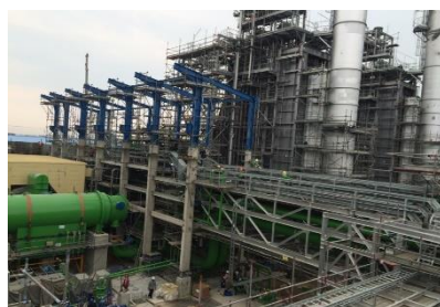
รูปภาพที่ 4.13 แสดงตัวอย่างของการทำคอนกรีตป้องกันไฟหุ้มโครงสร้างเหล็ก
