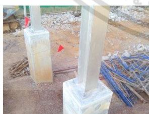
รูปภาพที่ 4.21 แสดงตัวอย่างการตรวจสอบ การเทปูน Grout ของเสา หลังการติดตั้งโครงสร้าง
