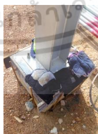
รูปภาพที่ 4.21 แสดงตัวอย่างการตรวจสอบ การเทปูน Grout ของเสา หลังการติดตั้งโครงสร้าง
