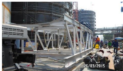
รูปภาพที่ 4.17 แสดงตัวอย่างการตรวจสอบพื้นที่ติดตั้งและวางแผนก่อนการติดตั้ง (lifting plan)
