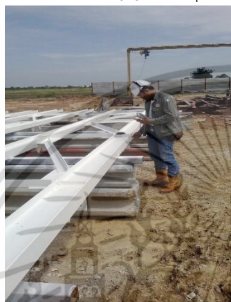
รูปภาพที่ 4.12 แสดงตัวอย่างการตรวจสอบความหนาของชั้นสีต่างๆ
