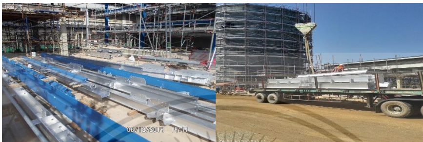
รูปภาพที่ 4.16 แสดงตัวอย่างการตรวจสอบการรับชิ้นงานที่หน้างาน
