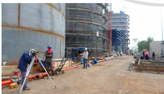
รูปภาพที่ 4.18 แสดงตัวอย่างการตรวจสอบตำแหน่งและระดับ Anchor bolt
