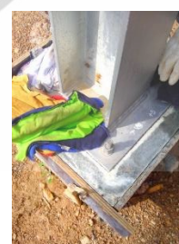
รูปภาพที่ 4.21 แสดงตัวอย่างการตรวจสอบ การเทปูน Grout ของเสา หลังการติดตั้งโครงสร้าง
