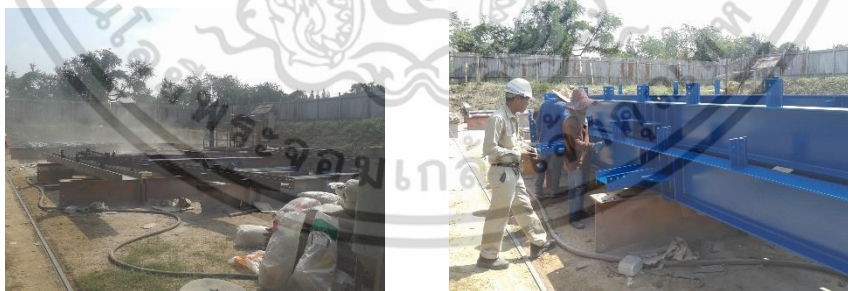
รูปภาพที่ 4.11 แสดงตัวอย่างการตรวจสอบการทาสีและการพ่นทรายขัดผิวของชิ้นงาน
