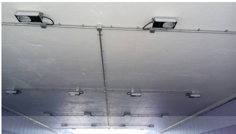
รูปที่ 3.10 โคมไฟใต้อูโมงค์ทางลอด
