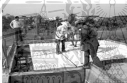
รูปที่ 2.21 การค้ำยัน และวางแผ่นพื้นสำเร็จรูป
