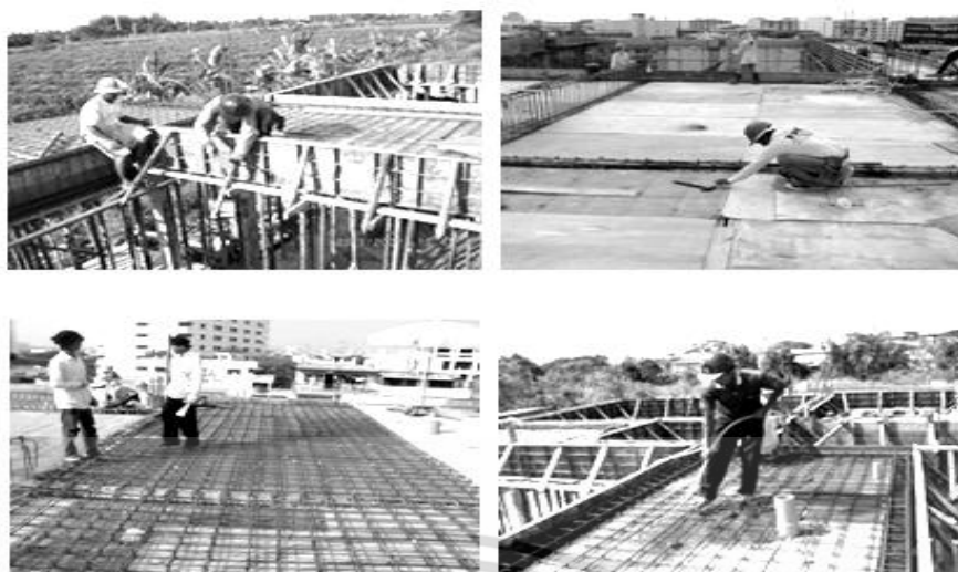
รูปที่ 2.20 การก่อสร้างพื้นหล่อในที่
