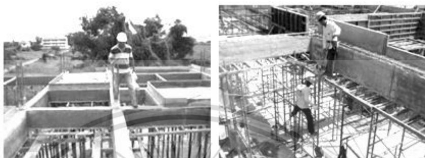
รูปที่ 2.17 การถอดแบบคาน และทาน้ำยาบ่มคอนกรีต
