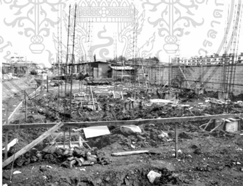
รูปที่ 2.4 แสดงการวางผังและตีผังในการก่อสร้างที่เสร็จเรียบร้อยแล้ว
