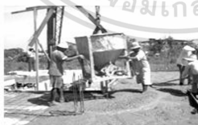
รูปที่ 2.22 การวางเหล็ก ติดตั้งไม้แบบ และการเทคอนกรีตพื้น
