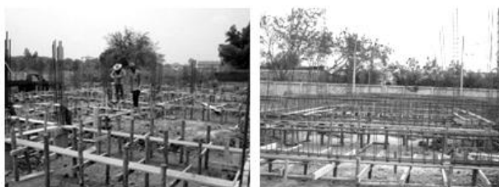
รูปที่ 2.14 การวางท้องคาน และเสริมเหล็กของคานคอดิน
