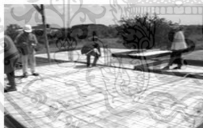
รูปที่ 2.21 การค้ำยัน และวางแผ่นพื้นสำเร็จรูป
