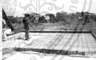
รูปที่ 2.21 การค้ำยัน และวางแผ่นพื้นสำเร็จรูป
