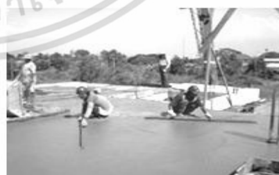
รูปที่ 2.22 การวางเหล็ก ติดตั้งไม้แบบ และการเทคอนกรีตพื้น
