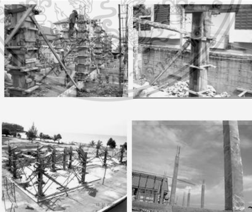
รูปที่ 2.13 การเข้าแบบเสา และการบ่มคอนกรีต
