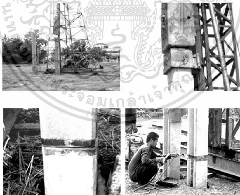
รูปที่ 2.6 ระยะยกเสาเข็มตอก และการต่อเสาเข็มควรใช้แผ่นเหล็กเชื่อม
